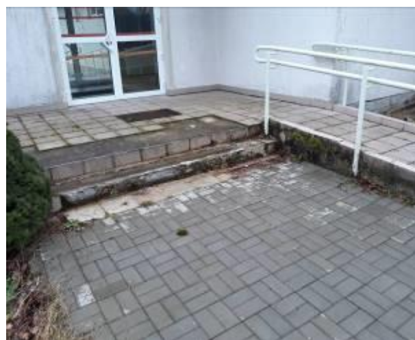
Fot. Schody i pochylnia przed wejściem do łącznika od strony północnej. Proj. wymiana płytek na izolację – nawierzchnię, wymiana balustrad
