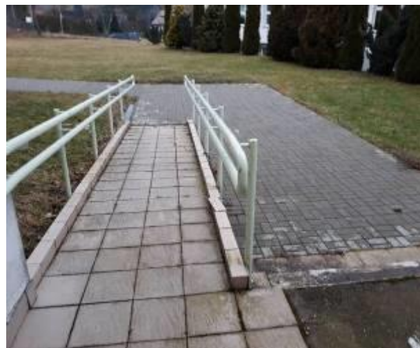
Fot. Pochylnia przed wejściem do łącznika od strony północnej. Proj. wymiana płytek na izolację – nawierzchnie, wymiana balustrad
