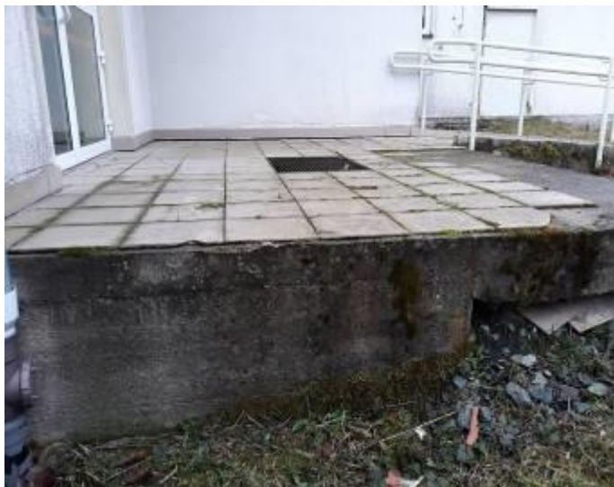
Fot. Betonowy podest wejściowy do łącznika od strony północnej Proj. wymiana płytek na izolację – nawierzchnie
