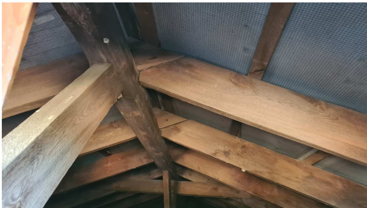
Fot. 4 Widok elementów nośnych konstrukcji więźby dachowej objętej opracowaniem.
