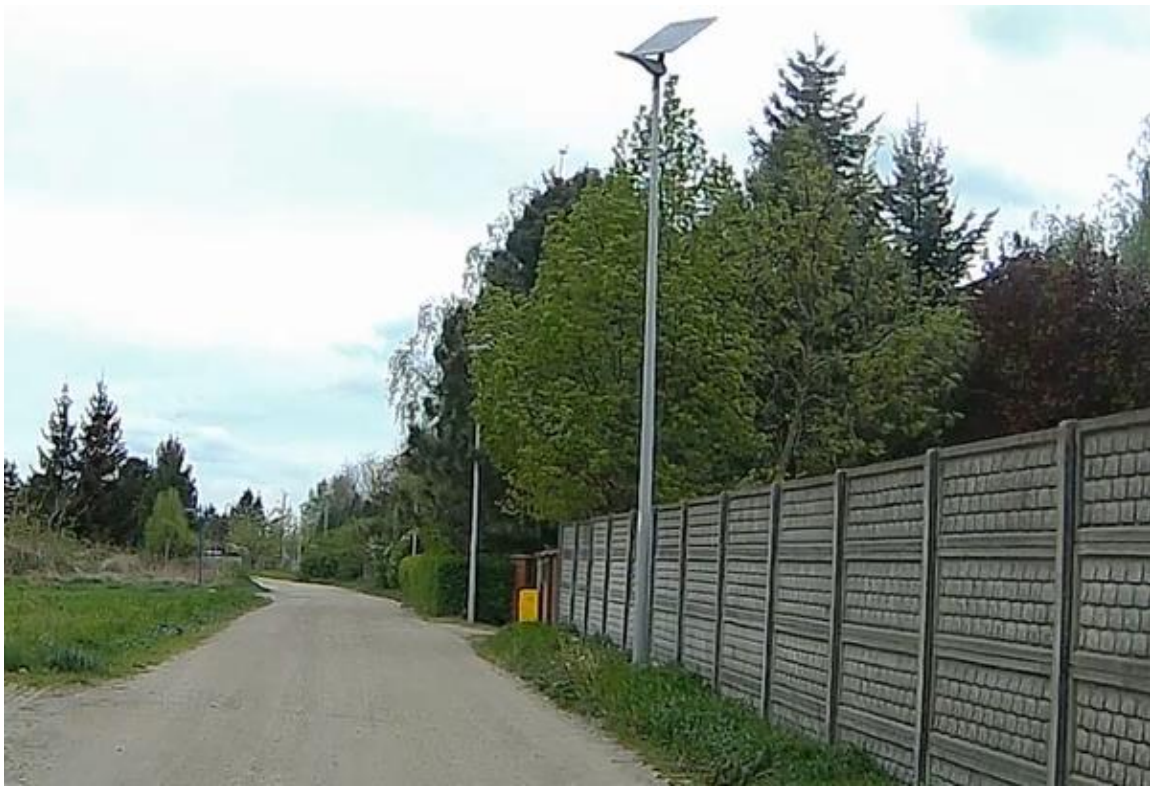
Fot. 5. Istniejące oświetlenie drogowe fotowoltaiczne.
