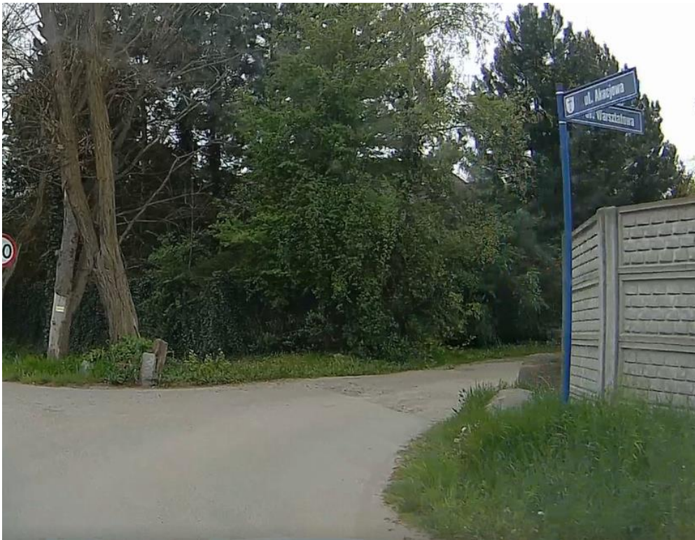
Fot. 7. Koniec opracowania km 0+374,00 (skrzyżowanie z ul. Akacją).
