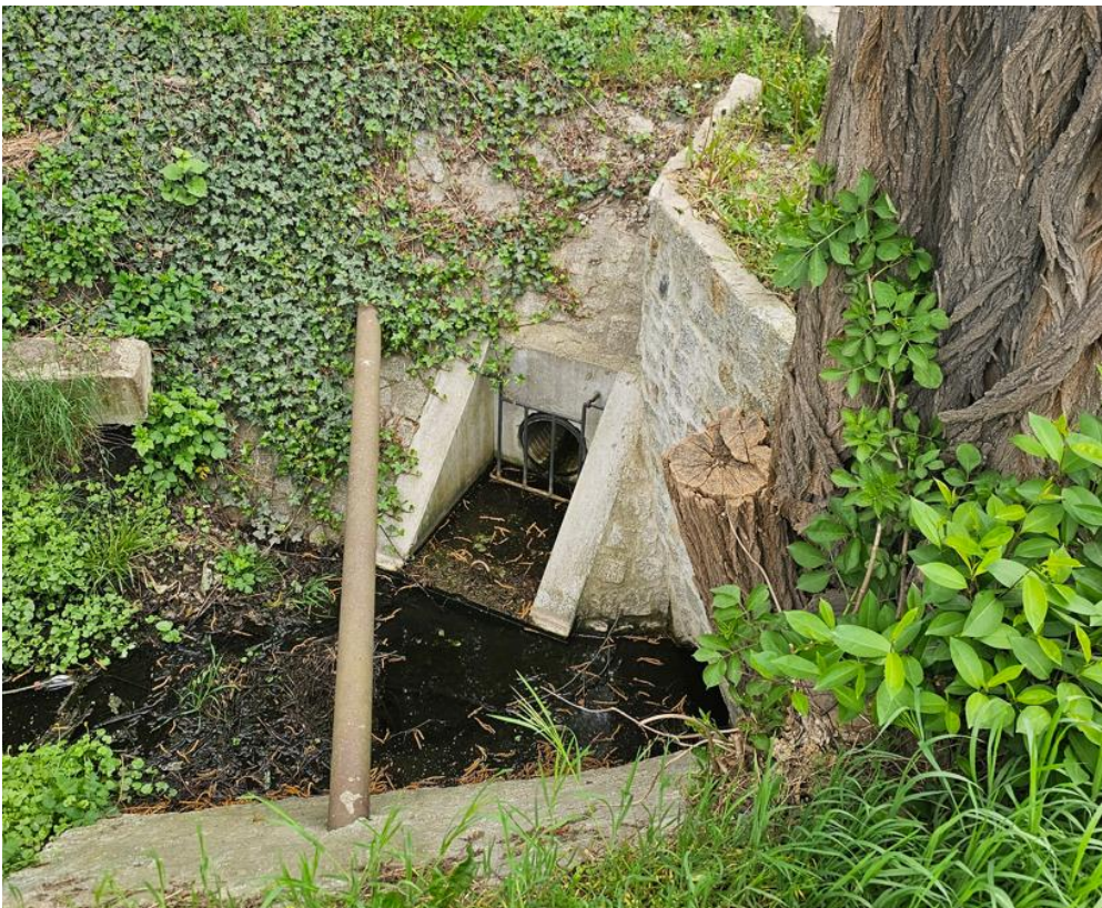
Fot. 8. Wylot rury drenarskiej PVC 250 do istniejącego rowu na dz. nr 66.
