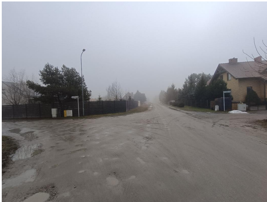
Fot.5. Droga Wojewódzka nr 307 – miejsce zakończenia inwestycji.
