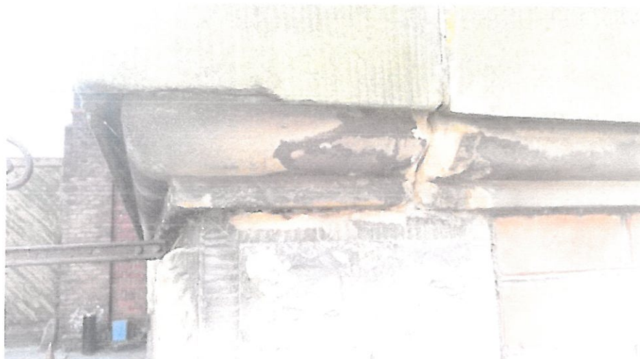
Fot.7. Widok ubytków w blokach z piaskowca.
