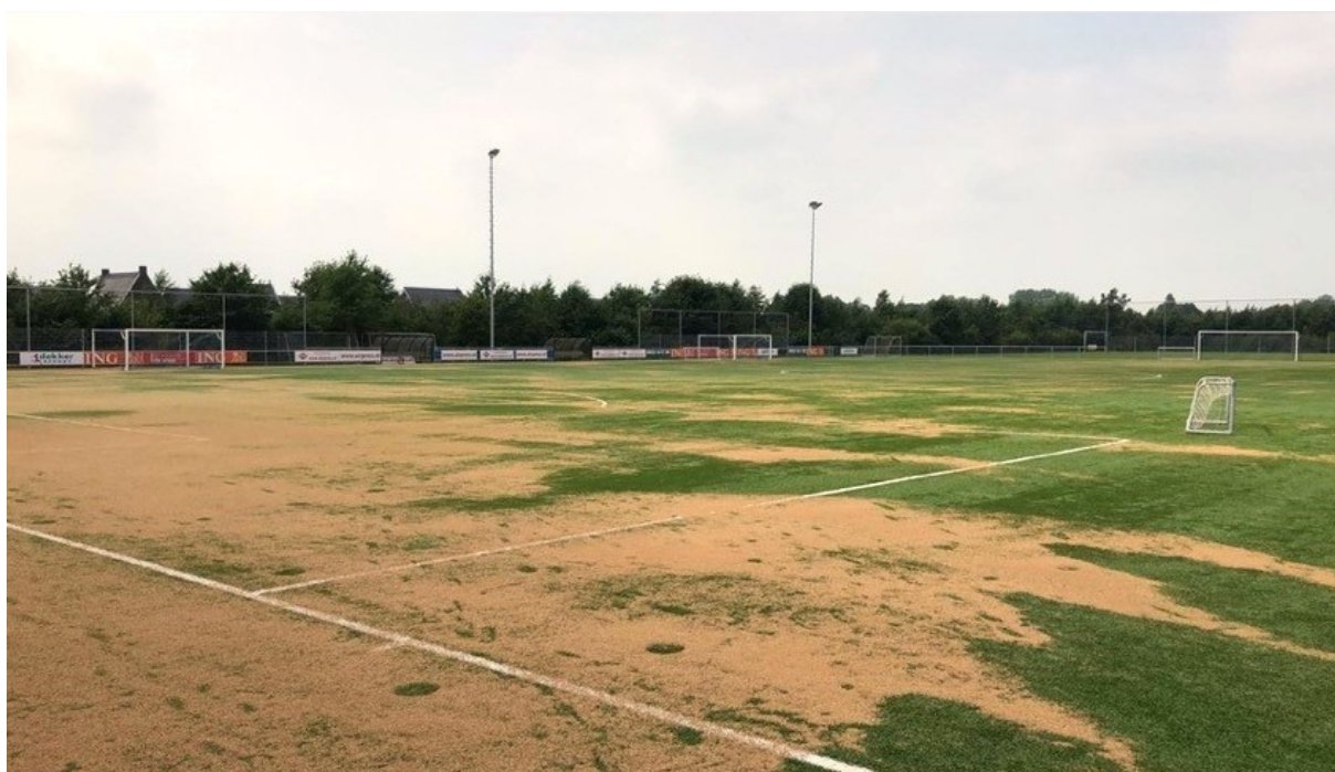
Fot. 2 Boisko z wypełnieniem korkowym po opadach deszczu
