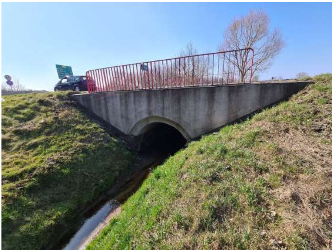
Fot. 4. Widok na głowicę wylotową przepustu.
