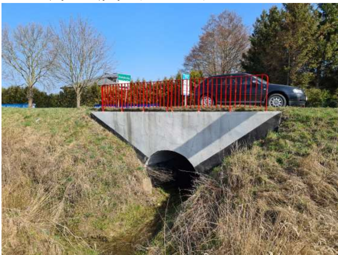
Fot. 3. Widok na głowicę wlotową przepustu.
