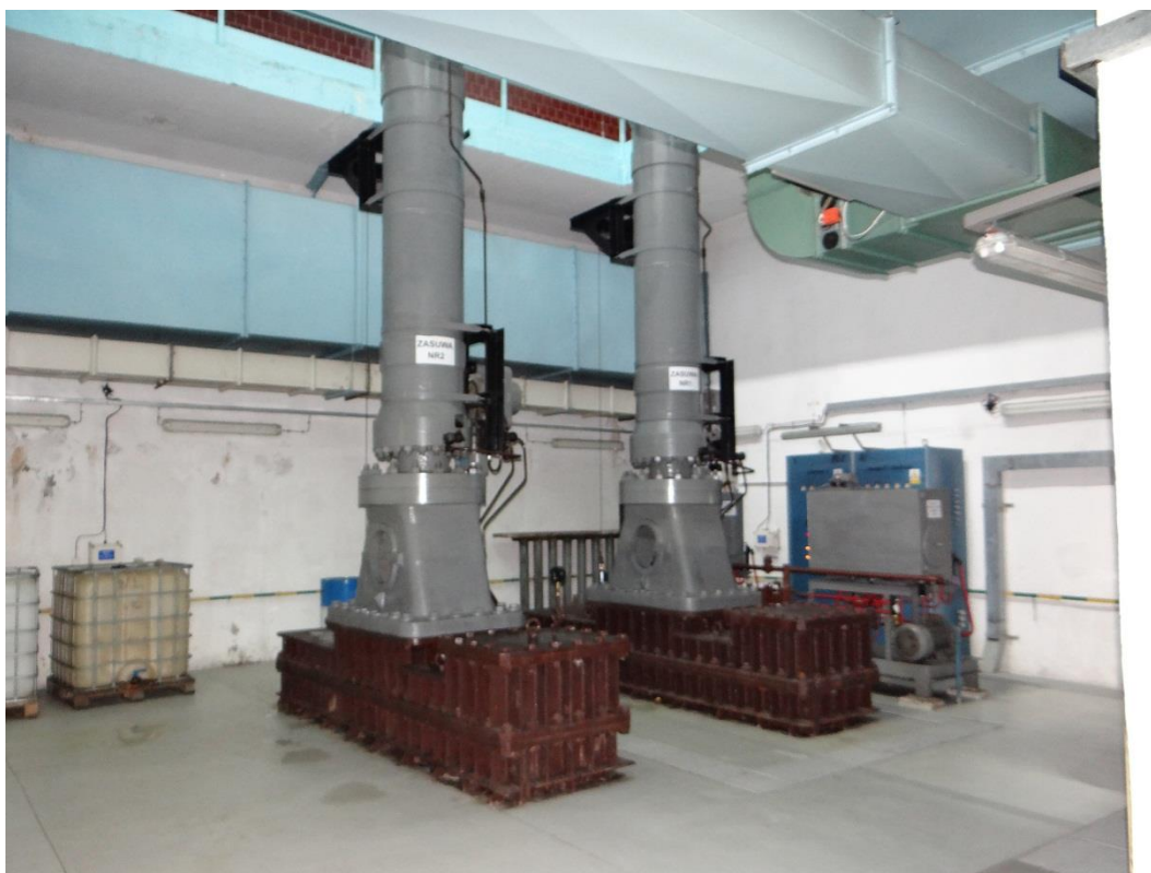
FOTOGRAFIA 4-2 POZIOM 473,20 M N.P.M. – ISTNIEJĄCE ZASUWY UPUSTU.
