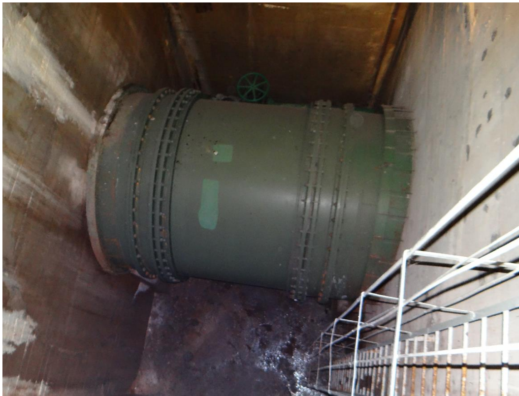
FOTOGRAFIA 4-1 LUK KOMPENSATORÓW - MIEJSCE PLANOWANEGO WPIĘCIA RUROCIĄGÓW DOPROWADZAJĄCYCH WODĘ DO TURBIN.
