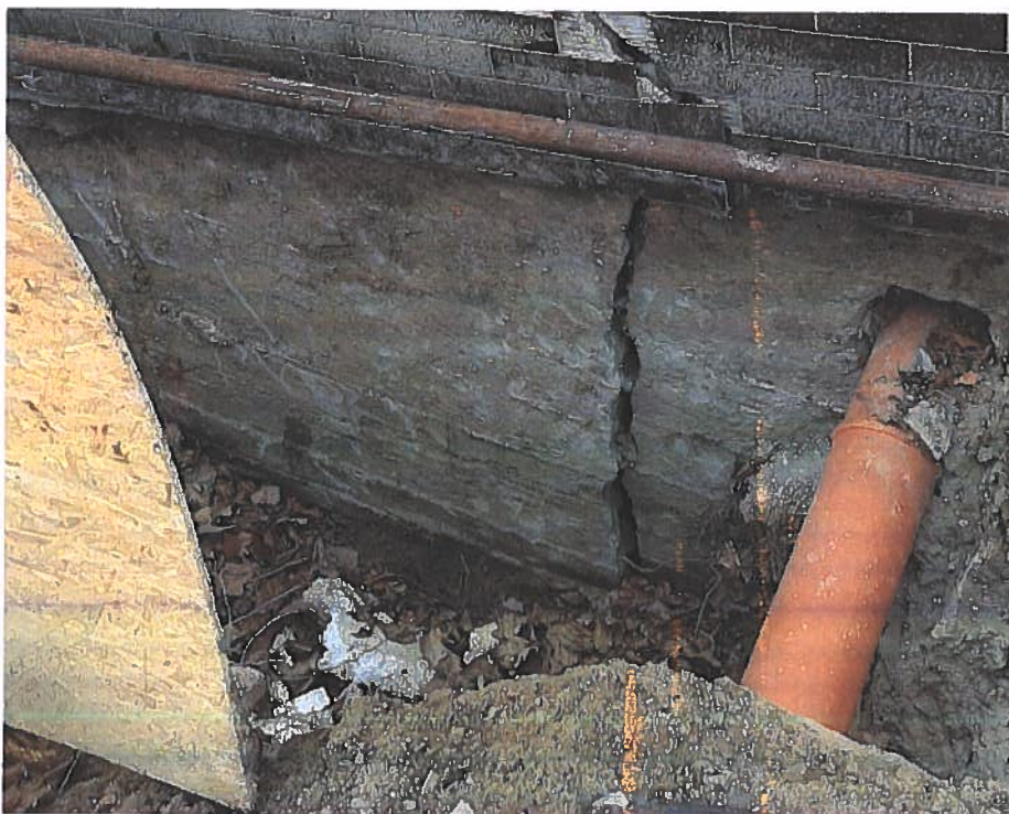
Widok pęknięcia ściany fundamentowej.
