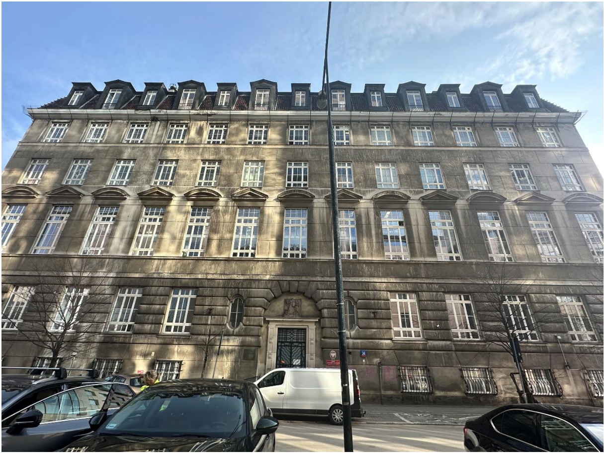
Widok elewacji zachodniej (od strony ul. Chocimskiej)
