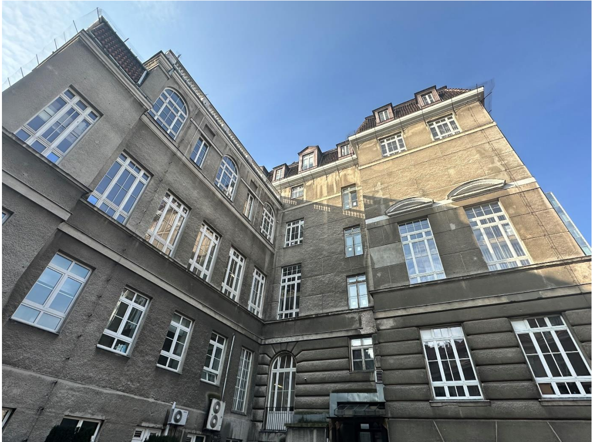
Widok części elewacji wschodniej (od strony dziedzińca)
