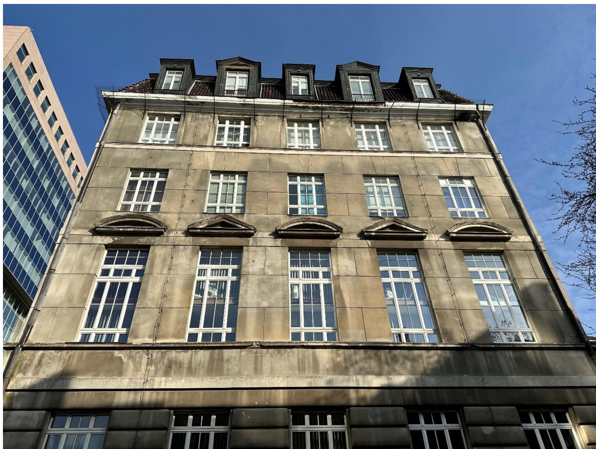
Widok elewacji południowej (od strony ul. Kujawskiej)
