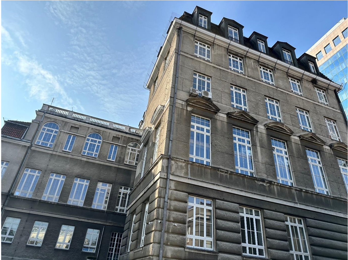
Widok elewacji północnej (od strony dziedzińca)
