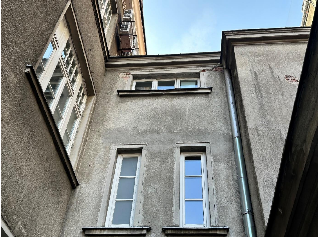
Widok elewacji łącznika do budynku AB (od strony dziedzińca)
