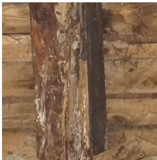
Zd.9.15. Przykład korozji biologicznej spowodowanej przez owady krokwi pozostawionej jako tzw. „świadka”.
