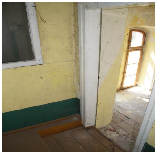
Zd. 9.20. Przykład destrukcji podłogi pomieszczeń pierwszego piętra.
