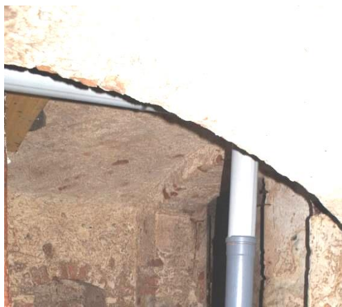
Zd.6.11. Strop kolebkowy z cegły pełnej ceramicznej piwnicy nr 01.
