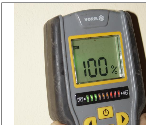
Zd. 6.30. Przykład pomiaru wilgotności ścian w pomieszczeniach parteru i pierwszego piętra
