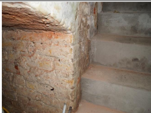
Zd.6.6. Piwnica nr 02 schody betonowe wtórne, naroże sklepienia ceglanego.
