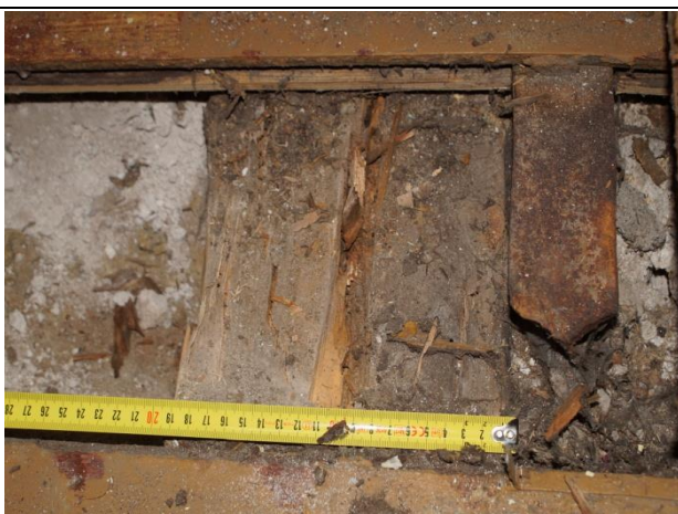
Zd.9.7. Odkrywka warstw podpodłogowych stropu nad parterem. Belki stropowe (legary) o wymiarach 19 cmx19 cm w rozstawie co 95 cm. Widoczny dwuteownik konstrukcji stalowej obok legaru. Stanowi on przedłużenie jednego z czterech wsporników podtrzymujących balkon od strony wschodniej.
