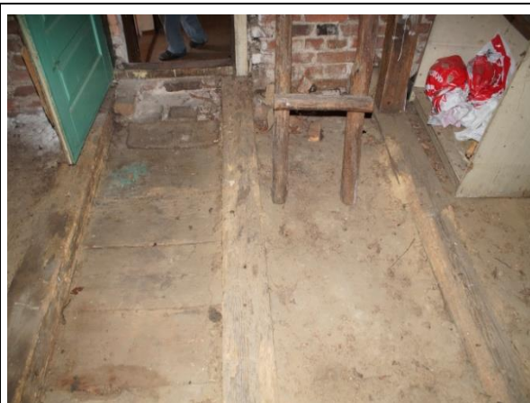
Zd.9.1. Strop nad parterem w części strychowej w osi 1-2 wykonany w konstrukcji drewnianej . Widoczne legary 20x20 cm w rozstawie co 100 cm. Pola pomiędzy legarami wypełnione gliną.
