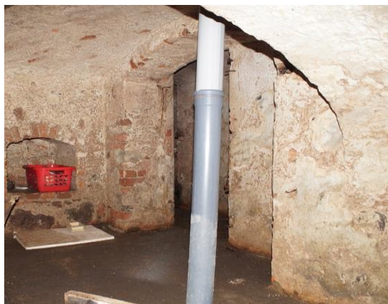
Zd.6.2. Piwnica.pom. nr 02 część południowo zachodnia. Opis jak obok.
