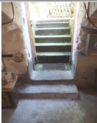
Zd.6.5. Piwnica nr 02 schody betonowe do piwnicy .
