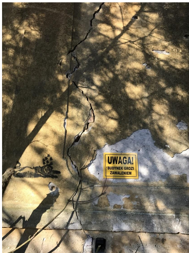
Fot. 5. Odpadający tynk na murach kondygnacji przyziemia. Zawilgocone i zagrzybione ściany oraz drewniane belki stropowe. Lokalnie brak desek drewnianej podłogi, które uległy destrukcji
