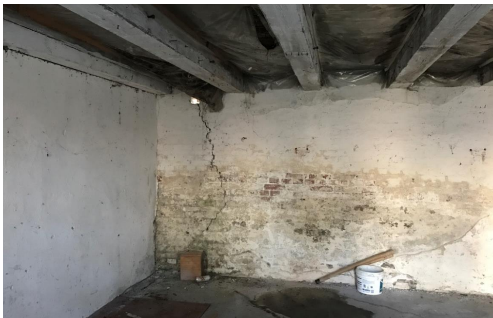
Fot. 1. Widok zewnętrznej ściany murowanej hangaru. Widoczne pęknięcie wskazuje na przemieszczenie bloku ściany, znajdującego się po prawej stronie fotografii, w kierunku pionowym w dół i obrocie w prawo. Maksymalne rozwarście pęknięcia oszacowano na 3,0 cm. Należy zwrócić uwagę na bliskość rosnącego drzewa, którego korzenie destrukcyjnie wpływają na fundamenty
