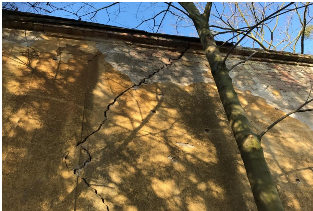
Fot. 1. Widok zewnętrznej ściany murowanej hangaru. Widoczne pęknięcie wskazuje na przemieszczenie bloku ściany, znajdującego się po prawej stronie fotografii, w kierunku pionowym w dół i obrocie w prawo. Maksymalne rozwarście pęknięcia oszacowano na 3,0 cm. Należy zwrócić uwagę na bliskość rosnącego drzewa, którego korzenie destrukcyjnie wpływają na fundamenty
