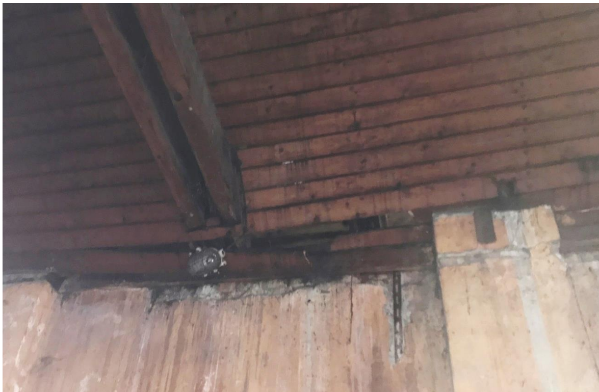
Fot. 13. Widok drewnianego deskowania dachu od dołu. Widoczne przełamanie drewna – podbitki dachu, w miejscu oparcia kleszczy ściągających więźbę
