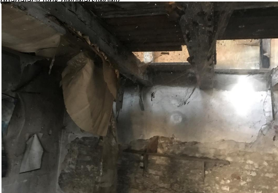
Fot. 5. Odpadający tynk na murach kondygnacji przyziemia. Zawilgocone i zagrzybione ściany oraz drewniane belki stropowe. Lokalnie brak desek drewnianej podłogi, które uległy destrukcji
