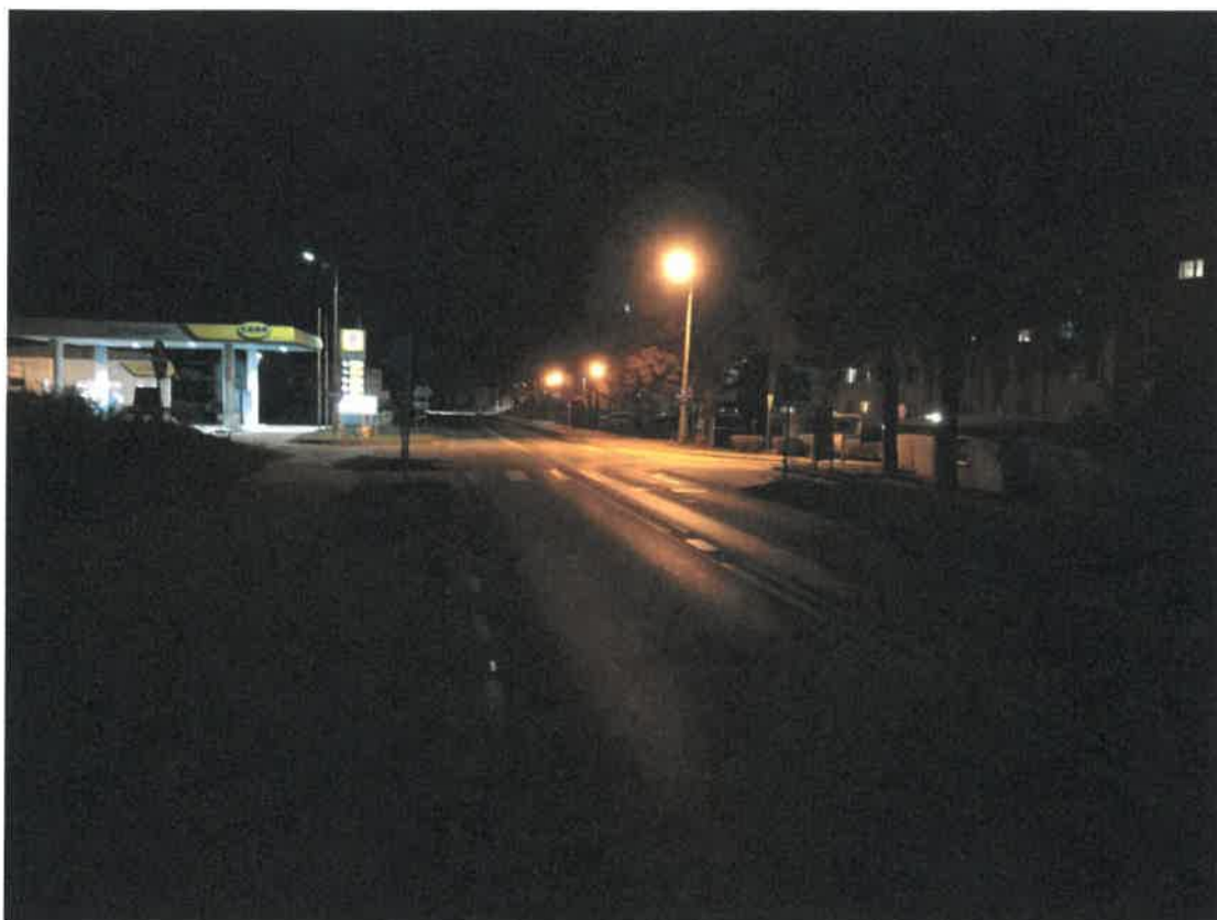
Rys. nr 1. Widok instalacji oświetleniowej na ul. Laskowickiej w miejscu przejścia dla pieszych.
