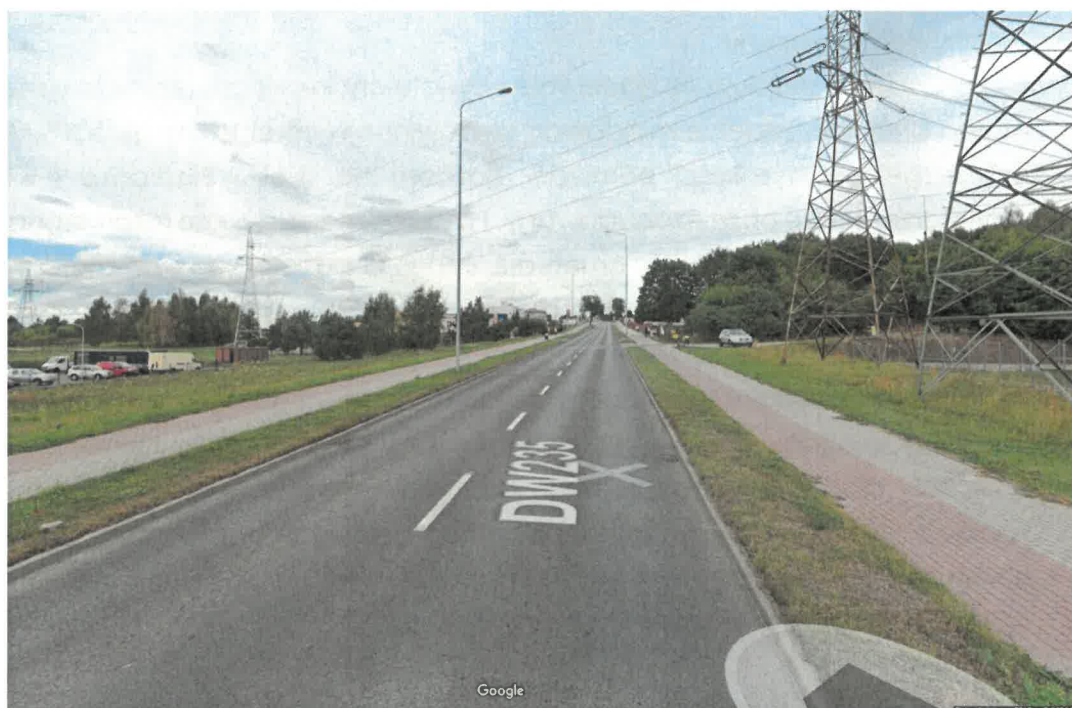
Rysunek 3. Widok na potencjalne miejsce inwestycji (źródło google maps)
