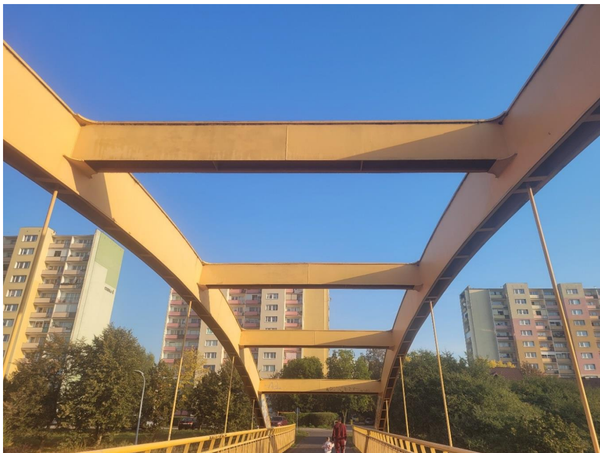
FOT. 5 Konstrukcja nośna kładki
