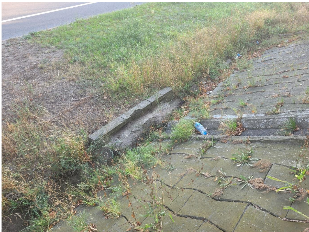
FOT. 10 Ściek skarpowy, koryto ściekowe
