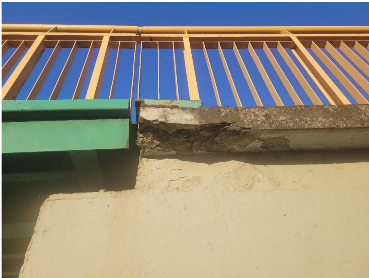
FOT. 17 Ubytki betonu na przyczółku północnym
