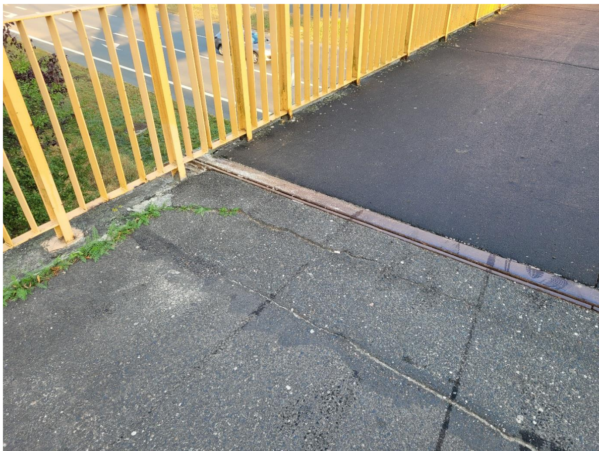
FOT. 14 Dylatacja, nawierzchnia od strony ul. Niziny
