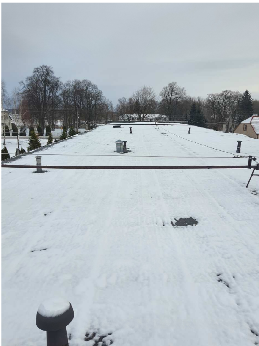
Fot. 2.4 Pokrycie dachu papą termozgrzewalną
