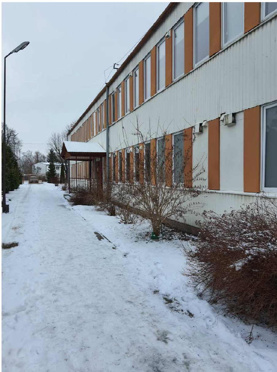
Fot. 2.1 Elewacja frontowa
