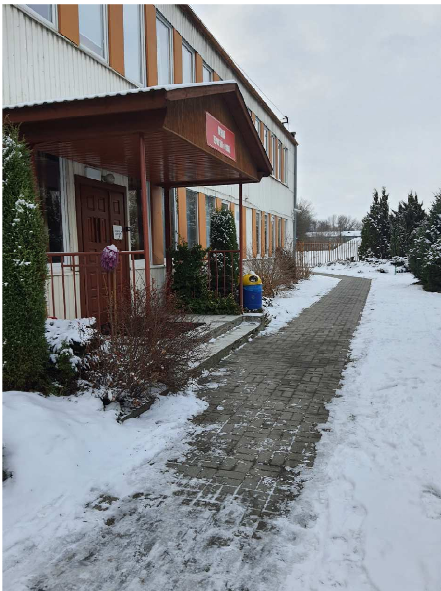
Fot. 2.2 Elewacja frontowa
