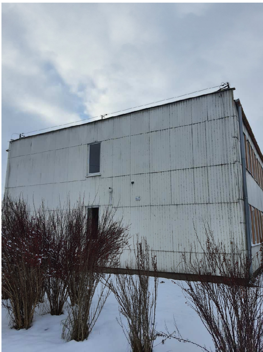
Fot. 2.3 Elewacja wschodnia
