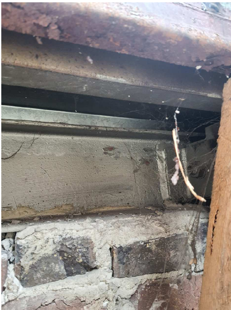
Fot. 4.3 Widok ramy głównej konstrukcji dachu
