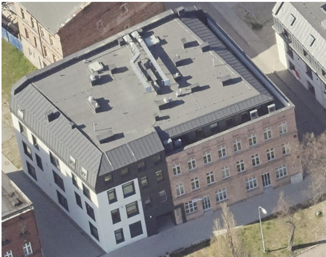
Zdjęcie nr 1. Widok budynku Gdańsk ul. Szczygła 1
