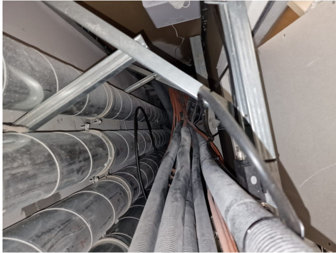
Zdjęcie nr 7. Widok szachtu kablowego.
