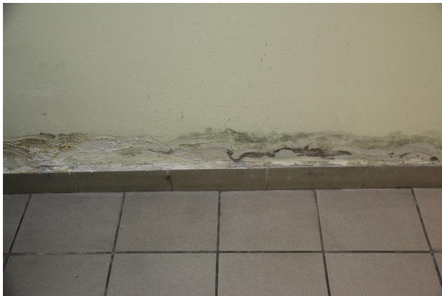
Fot. 24 Budynek socjalny nr 2 w obrębie zespołu magazynów artyleryjskich dawnej twierdzy Kraków, Kraków, ul. Rakowicka 22. Korytarz w piwnicy. Zawilgocenie murów. Stan przed konserwacją. Luty 2021. Fot. K. Sułkowska.
