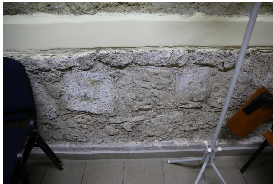
Fot. 27 Budynek socjalny nr 2 w obrębie zespołu magazynów artyleryjskich dawnej twierdzy Kraków, Kraków, ul. Rakowicka 22. Pomieszczenie w piwnicy. Oryginalny wątek kamienny. Stan przed konserwacją. Luty 2021. Fot. K. Sułkowska.
