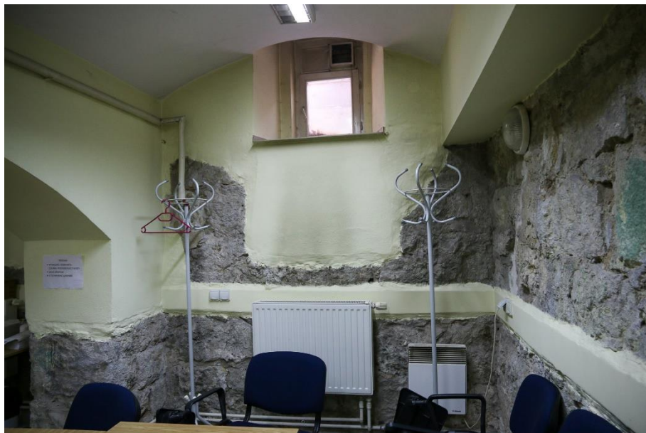
Fot. 30 Budynek socjalny nr 2 w obrębie zespołu magazynów artyleryjskich dawnej twierdzy Kraków, Kraków, ul. Rakowicka 22. Pomieszczenie w piwnicy. Oryginalny wątek kamienny. Stan przed konserwacją. Luty 2021. Fot. K. Sułkowska.
