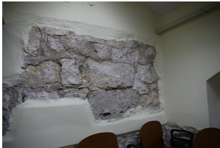
Fot. 29 Budynek socjalny nr 2 w obrębie zespołu magazynów artyleryjskich dawnej twierdzy Kraków, Kraków, ul. Rakowicka 22. Pomieszczenie w piwnicy. Oryginalny wątek kamienny. Stan przed konserwacją. Luty 2021. Fot. K. Sułkowska.
