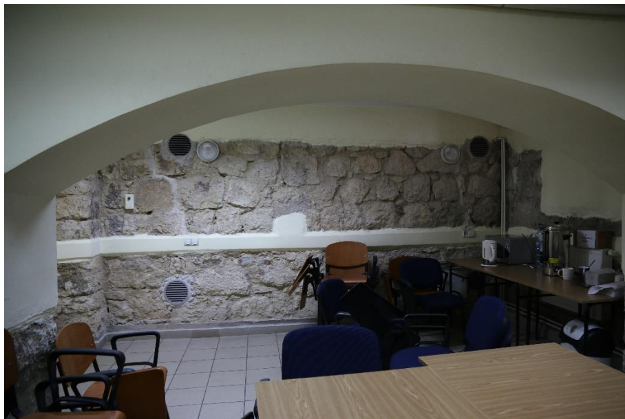
Fot. 28 Budynek socjalny nr 2 w obrębie zespołu magazynów artyleryjskich dawnej twierdzy Kraków, Kraków, ul. Rakowicka 22. Pomieszczenie w piwnicy. Oryginalny wątek kamienny. Stan przed konserwacją. Luty 2021. Fot. K. Sułkowska.
