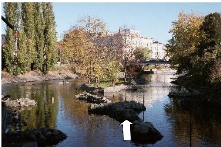
Wylot dla wody z kanału derywacyjnego (z tzw. Młynówki).
