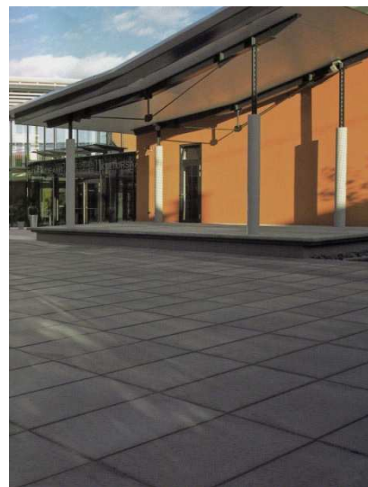
Ryc. 33 Nawierzchnia z płyt betonowych o wymiarze 60x40cm
