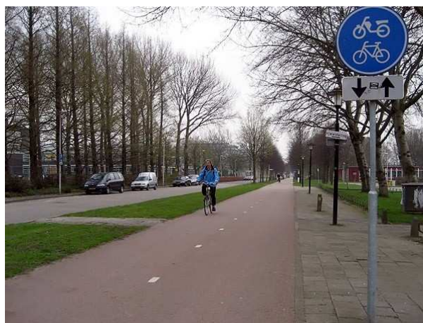
Ryc. 34 Nawierzchnia rowerowa z asfaltobetonu
