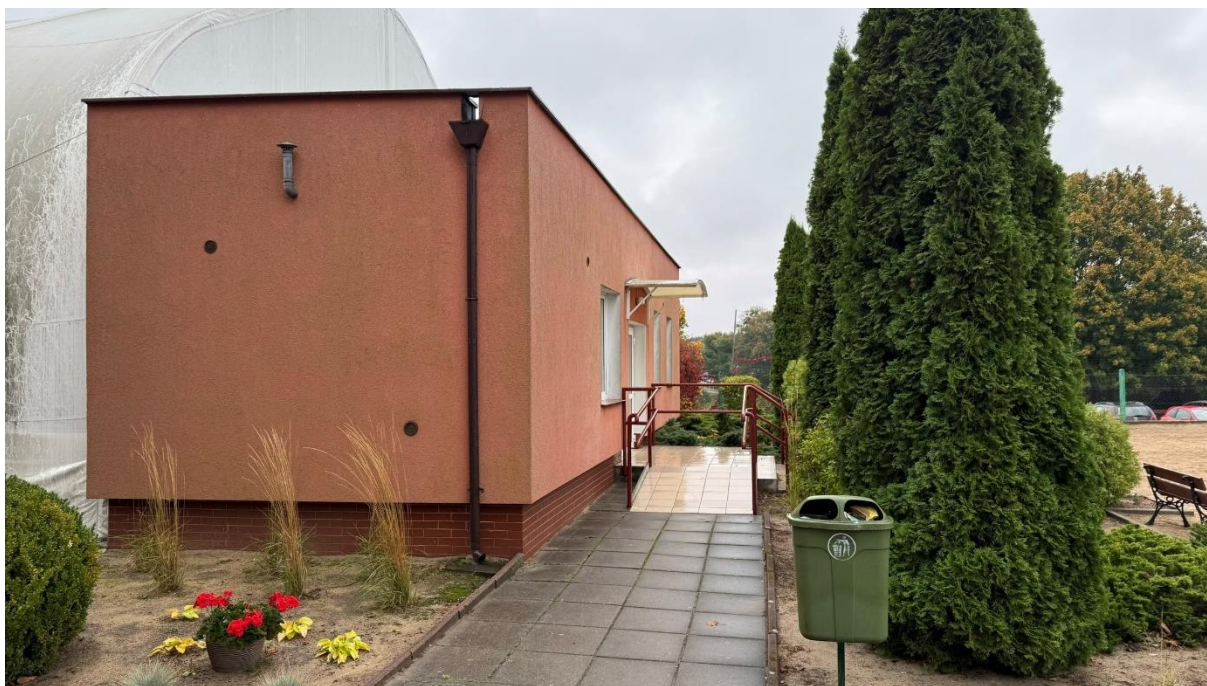
Łącznik wykonany w technologii murowej z zsadzeniem z płyt poliwęglanowych, łącznik wyposażony w instalację oświetleniową oraz hydrant p.poż.
