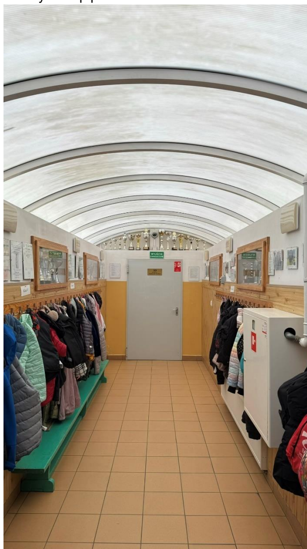
Łącznik wykonany w technologii murowej z zsadzeniem z płyt poliwęglanowych, łącznik wyposażony w instalację oświetleniową oraz hydrant p.poż.
