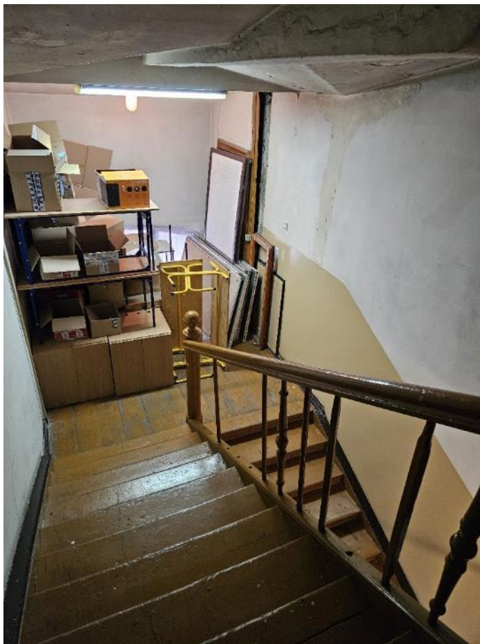
Zdjęcie 15 Drewniana klatka schodowa – spocznik wraz ze śladami zużycia
