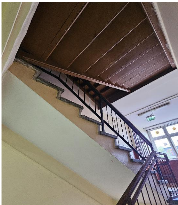
Zdjęcie 11 Zmiana klatki żelbetowej na klatkę drewnianą
