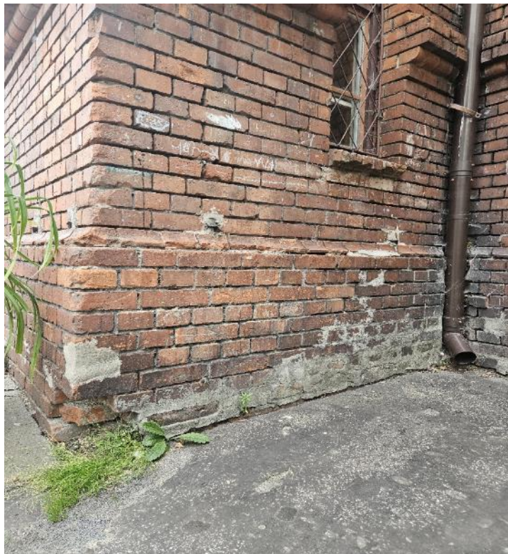
Zdjęcie 3 Ubytki w elewacji, widok orynnowania i opaska wokół budynku
