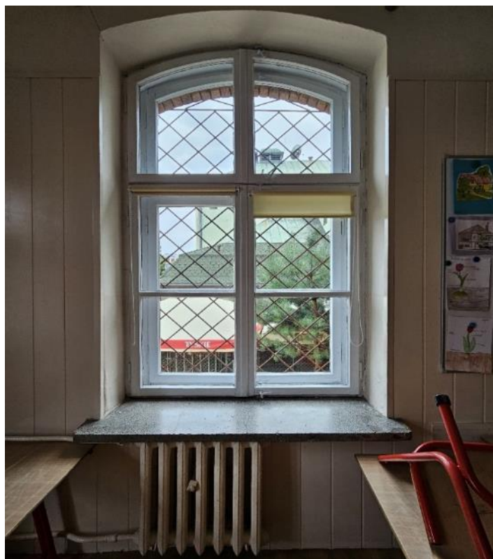
Zdjęcie 7 Widok okna - sposób otwierania, widok parapetu
