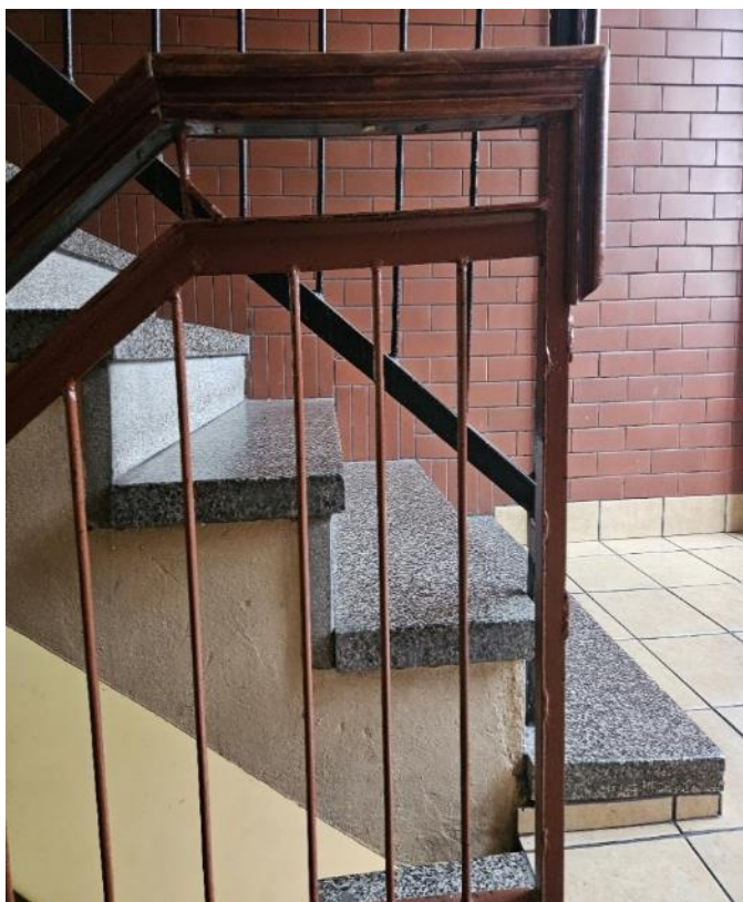
Zdjęcie 13 Klatka schodowa żelbetowa - nierówne stopnie, odspojony tynk na ścianie sutereny
