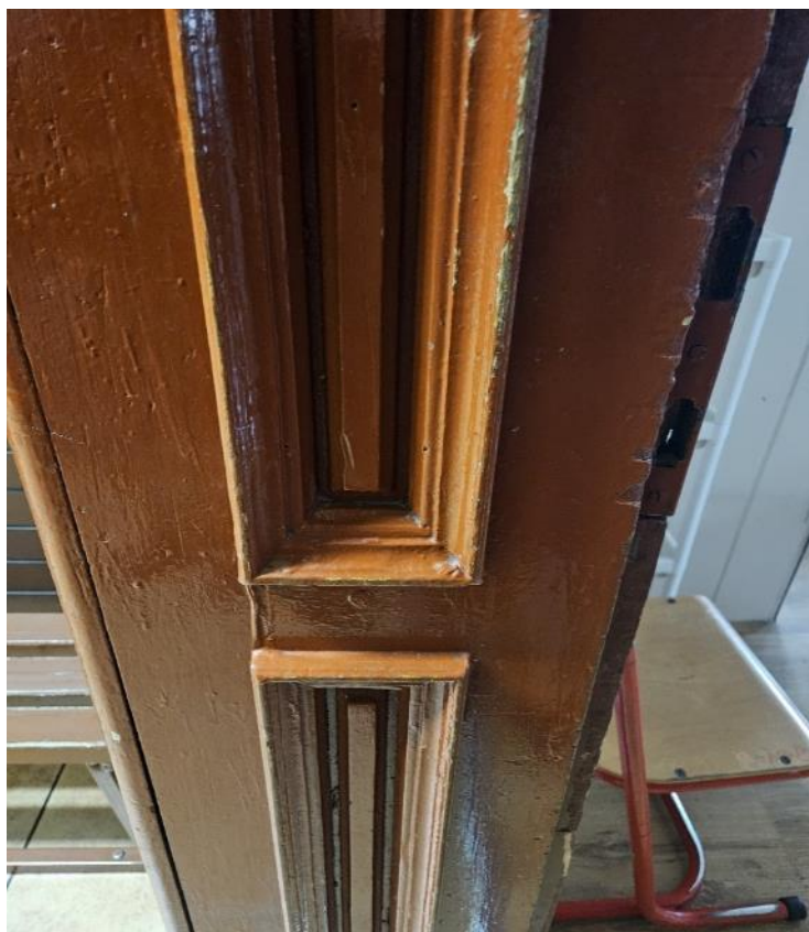
Zdjęcie 18 Uszkodzona futryna z widocznym spękaniem
