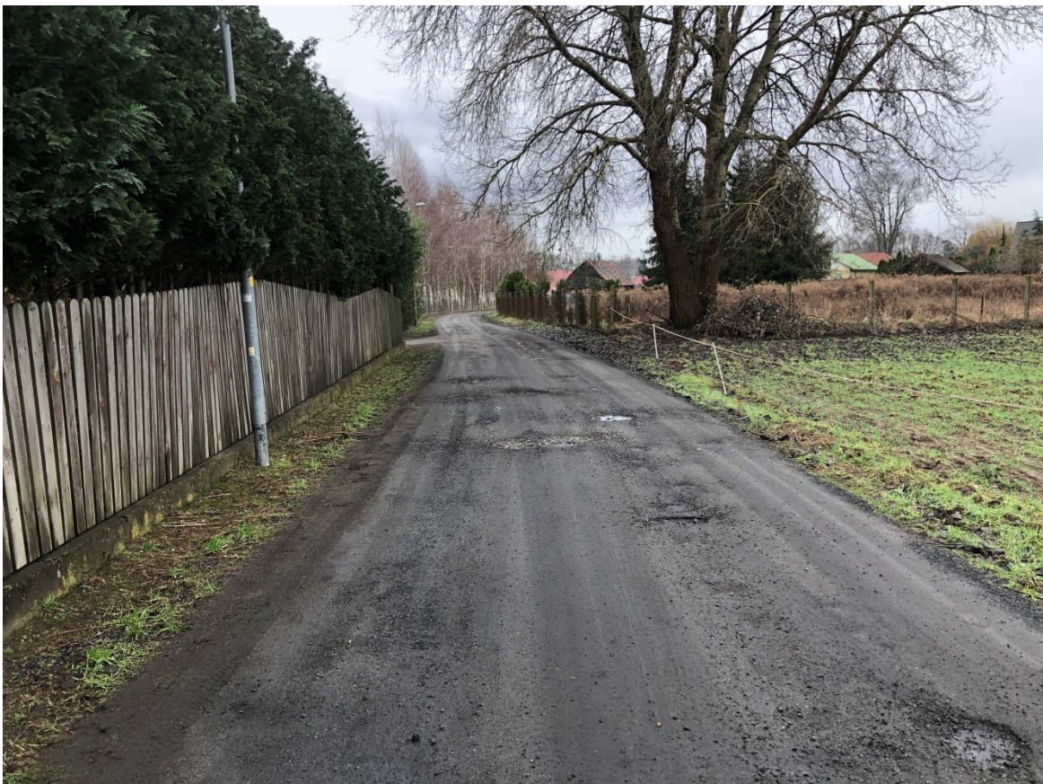
Zdjęcie 10. Widok w rejonie km 0+250,00 (zdjęcie w kierunku drogi krajowej)
