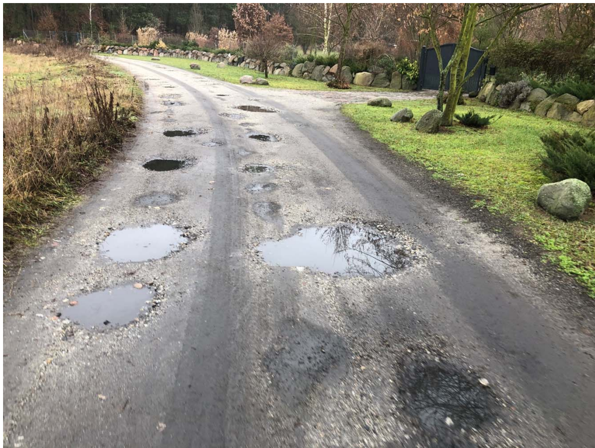
Zdjęcie 11. Widok w rejonie końca inwestycji (zdjęcie w głąb drogi gminnej)
