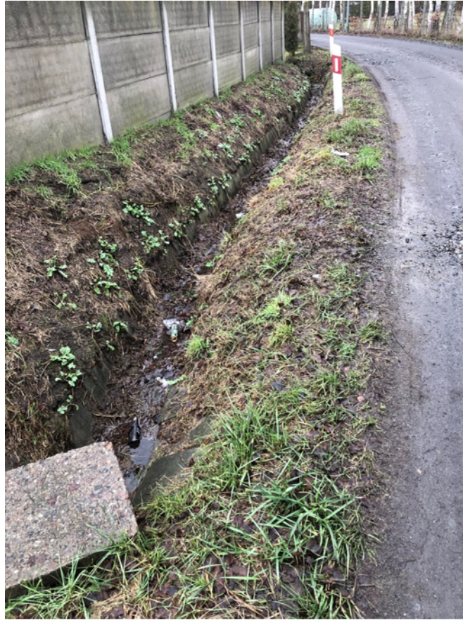
Zdjęcie 5. Widok na rowu przeznaczony do umocnienia
