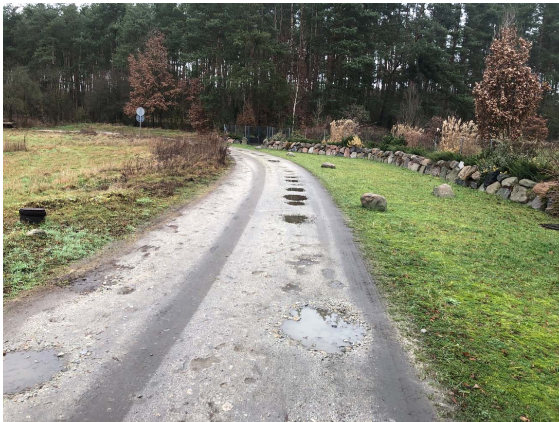
Zdjęcie 12. Widok w rejonie końca inwestycji (zdjęcie w głąb drogi gminnej)
