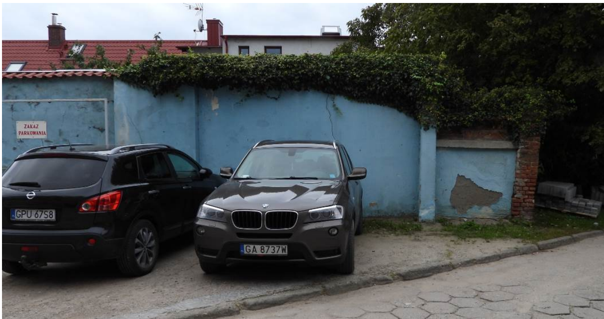
Zdjęcie nr 34. Ogrodzenie wewnętrzne szpitala. Część otynkowana. Źródło: Zdjęcie własne.
