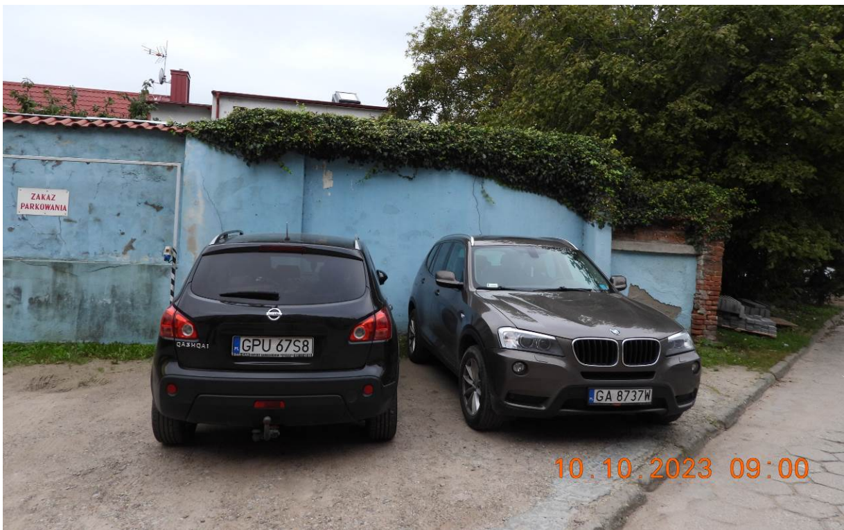
Zdjęcie nr 33. Ogrodzenie wewnętrzne szpitala. Część otynkowana. Źródło: Zdjęcie własne.
