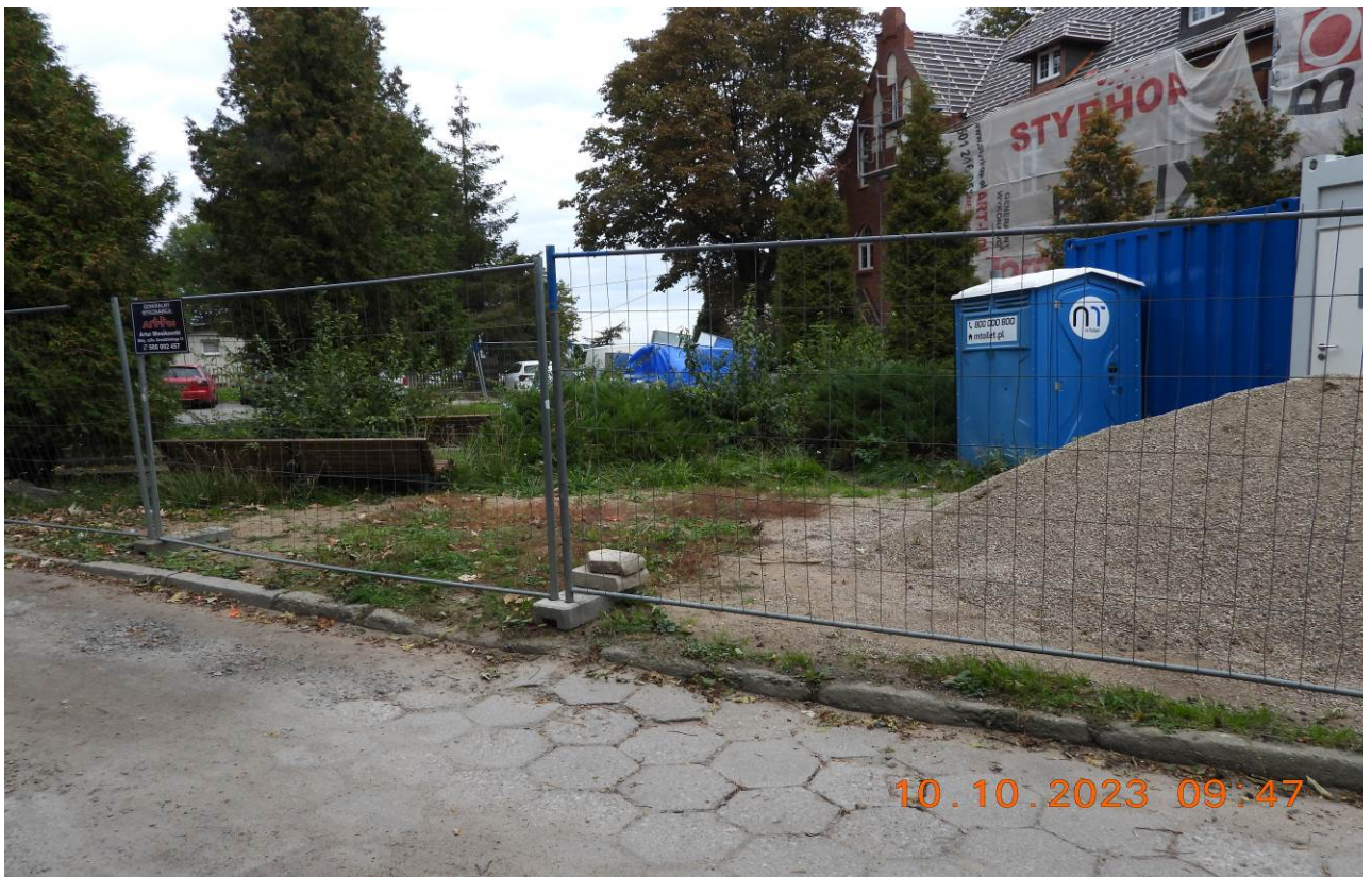
Zdjęcie nr 42. Zagospodarowanie terenu. Źródło: Zdjęcie własne.
