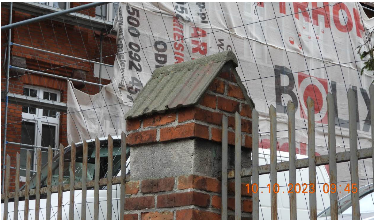
Zdjęcie nr 20. Widok wtórnego zwieńczenia słupa od strony alei Kościuszki. Źródło: Zdjęcie własne.
