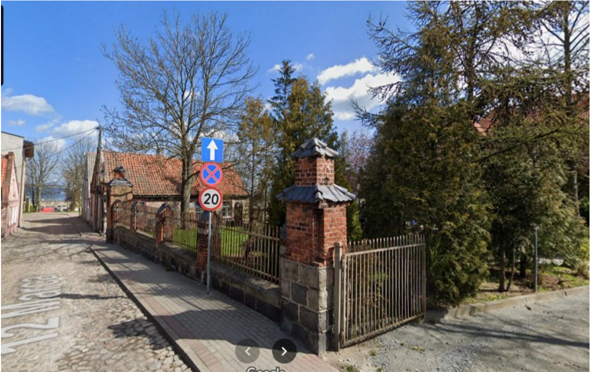
Zdjęcie nr 8. Widok ogrodzenia od strony ul. 12 Marca. Widoczna brama wiązdowna i słupki. Źródło: Google Maps.
