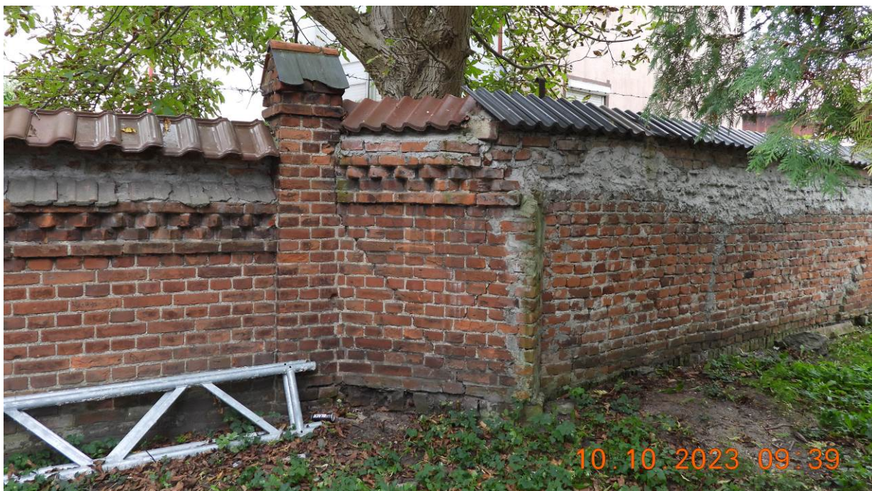
Zdjęcie nr 26. Ogrodzenie ceglane, wewnętrzne szpitala. Widoczny fragment oryginalnego i wtórnego muru ceglanego. Źródło: Zdjęcie własne.
