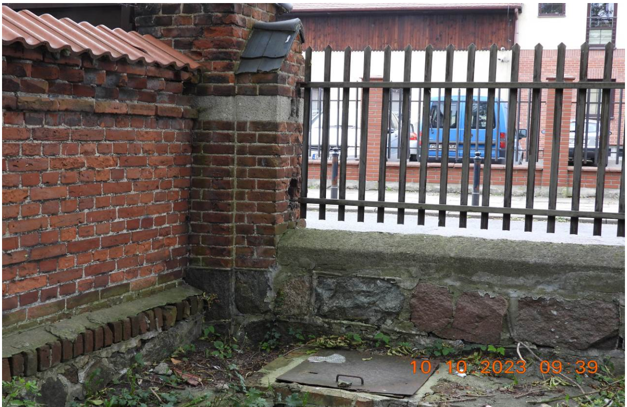
Zdjęcie nr 29. Ogrodzenie ceglane, wewnętrzne szpitala. Połączenie części ceglanej z ogrodzeniem od ul 12 Marca z przęstem metalowym. Widoczny kamienny mur oporowy i betonowe czapy. Źródło: Zdjęcie własne.
