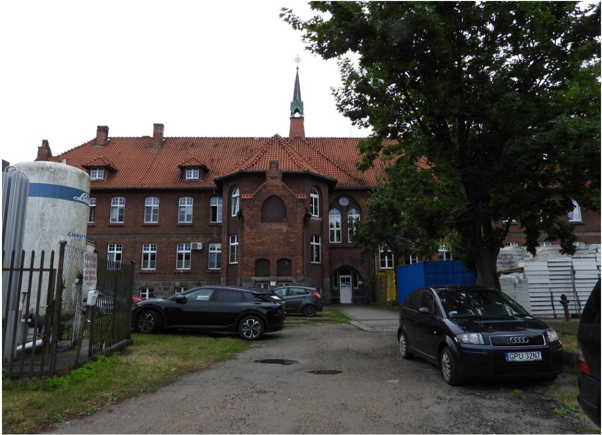
Zdjęcie nr 5. Widok Szpitala elewacja wschodnia (klasztor). Źródło: Zdjęcie własne.
