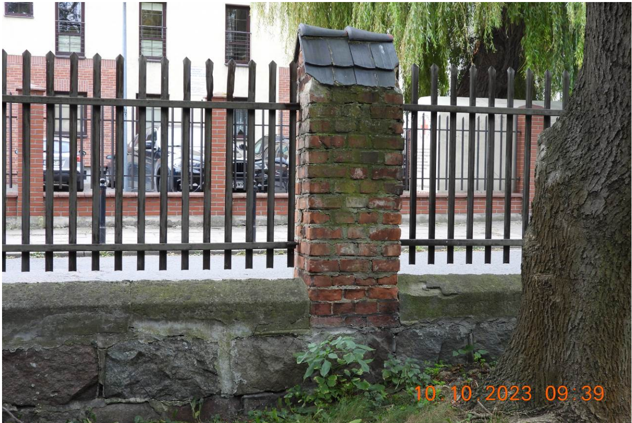
Zdjęcie nr 30. Ogrodzenie od ul 12 Marca z przesłem metalowym, część wewnętrzna. Widoczny słup ceglany, kamienny mur oporowy i betonowe czapy. Źródło: Zdjęcie własne.
