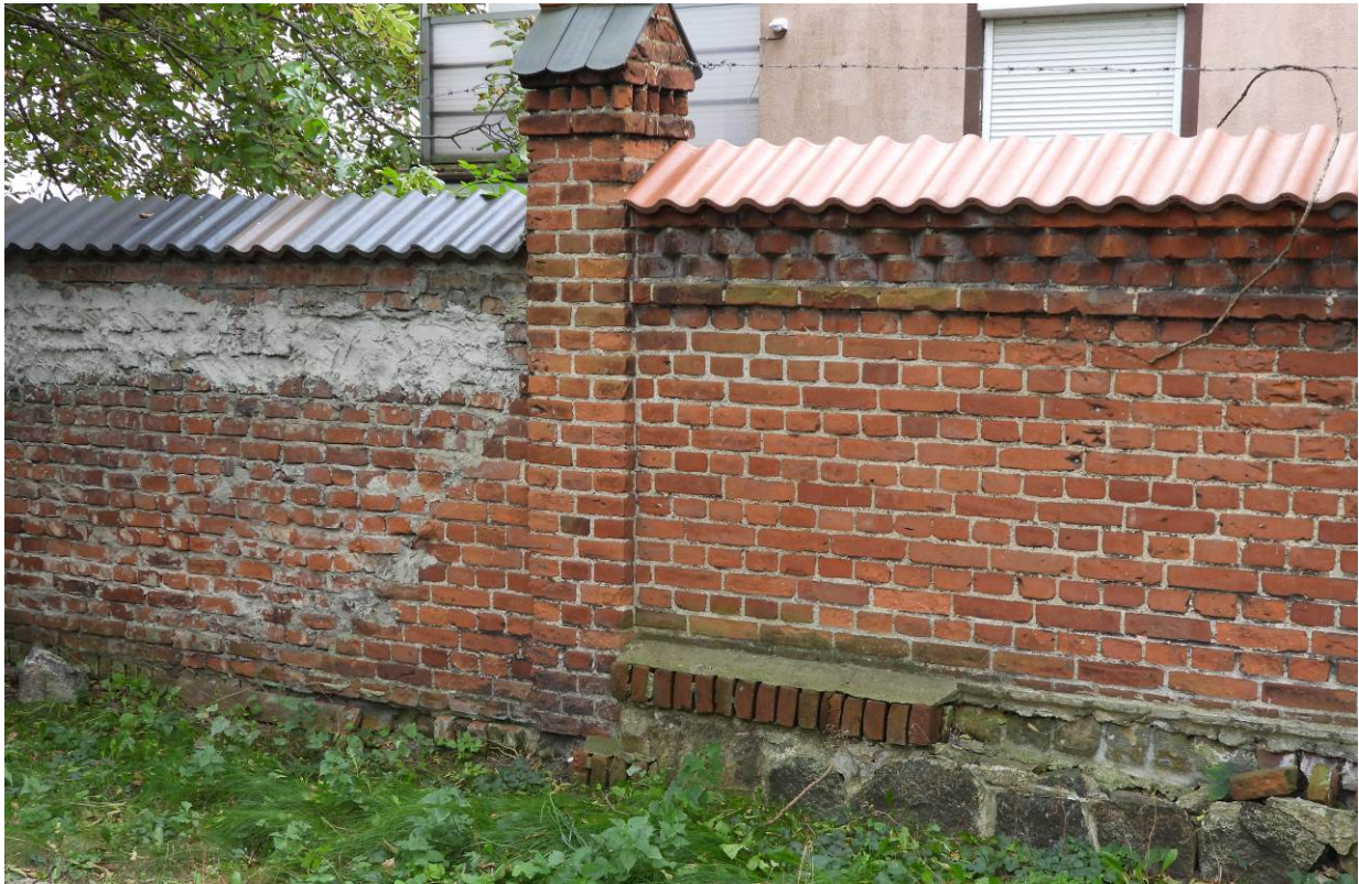
Zdjęcie nr 28. Ogrodzenie ceglane, wewnętrzne szpitala. Połączenie części wtórnego, przemurowanego muru ceglanego i ceglanego ogrodzenia oryginalnego. Widoczny kamienny mur oporowy. Źródło: Zdjęcie własne.
