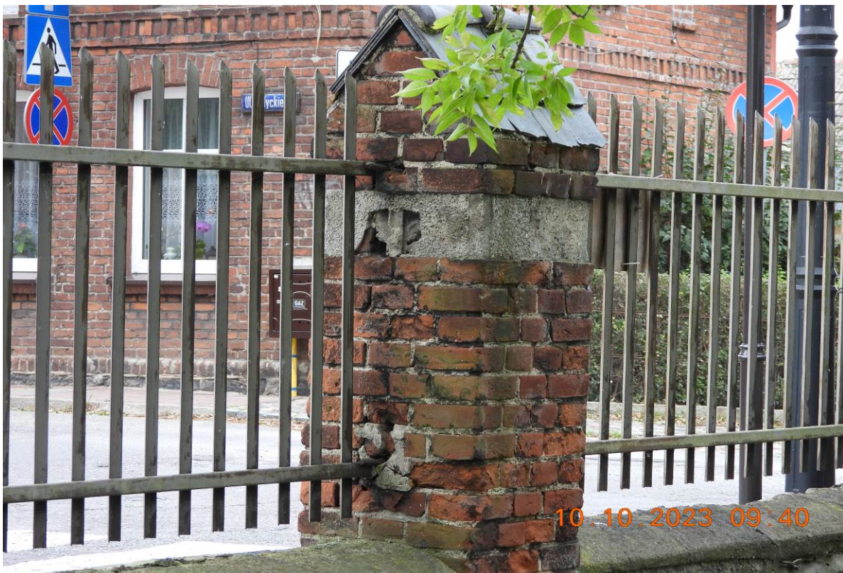
Zdjęcie nr 31. Ogrodzenie od ul 12 Marca z przesłem metalowym, część wewnętrzna. Widoczny słup ceglany, Źródło: Zdjęcie własne.
