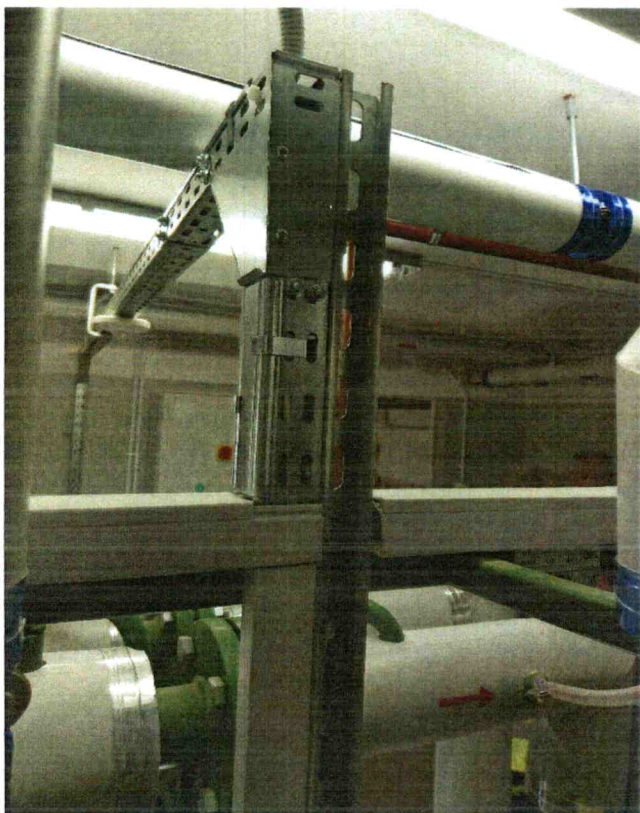
Rys. 8 Przykład wykonania mocowania koryta kablowego za pomocą konstrukcji wsporczej
