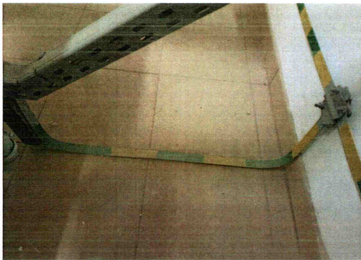
Rys.4 Połączenie kompaktu z połączeniem wyrównawczym głównym
