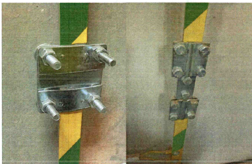
Rys. 5 Przykładowe zastosowanie zacisków pomiarowych
