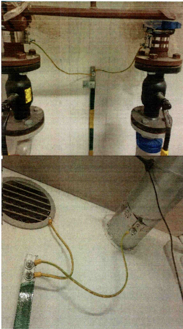
Rys. 6 Przykładowe połączenia wyrównawcze
