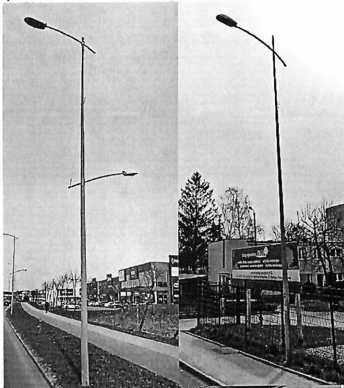
Słup z podwójnym wysięgnikiem Słup z pojedynczym wysięgnikiem
