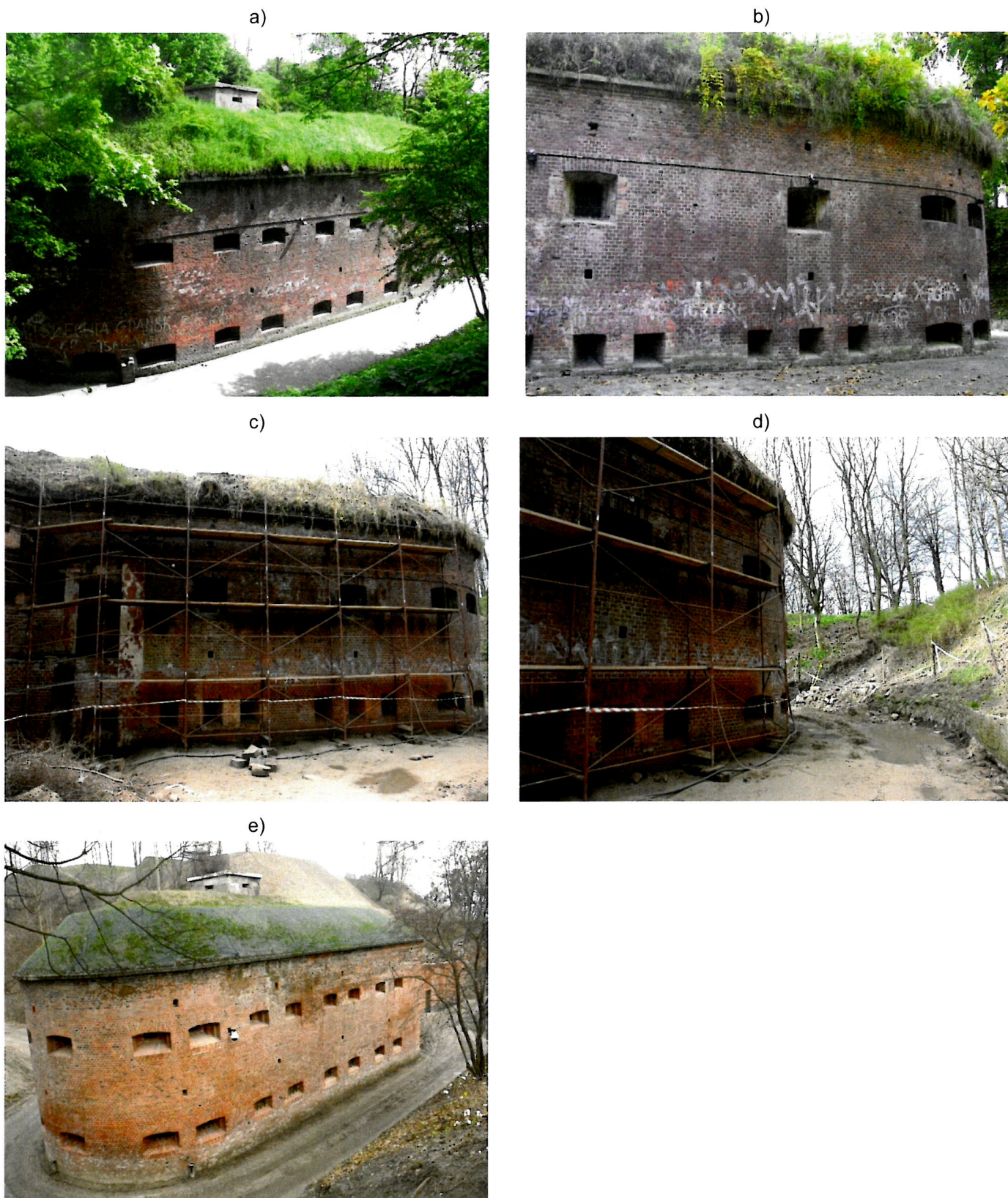
Rys.4: Bryła zewnętrzna Kaponiery Południowej: a), b) przed rozpoczęciem robót budowlanych (przed rokiem 2008), c), d) podczas realizacji robót budowlanych (w latach 2008-2009), e) po zakończeniu robót budowlanych (~2010r.)
