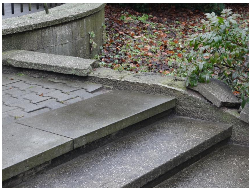
zdjęcie 4 Odspojenie zwieńczeń murków oporowych.
