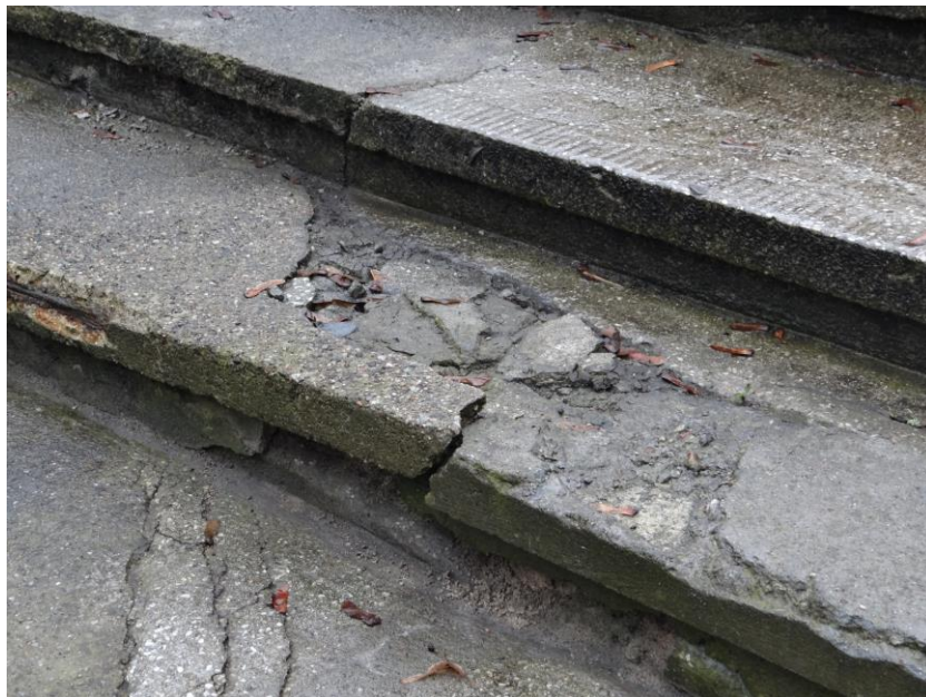
zdjęcie 3 Odspojenie warstwy lastriko w wyniku wielokrotnego przemarzania.
