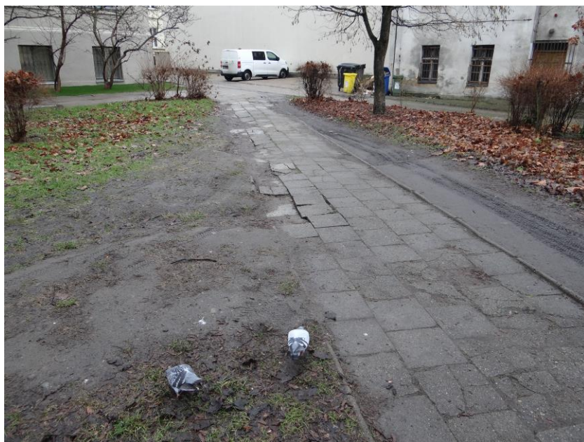
zdjęcie 6 Nierówności i uszkodzenia płyt chodnikowych.
