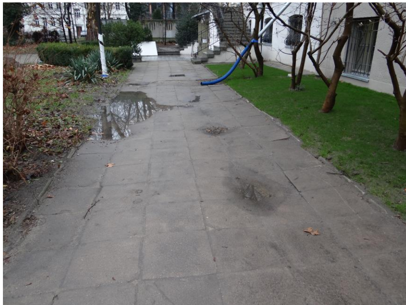
zdjęcie 5 Nierówności - zapadnięcia nawierzchni z płyt chodnikowych.
