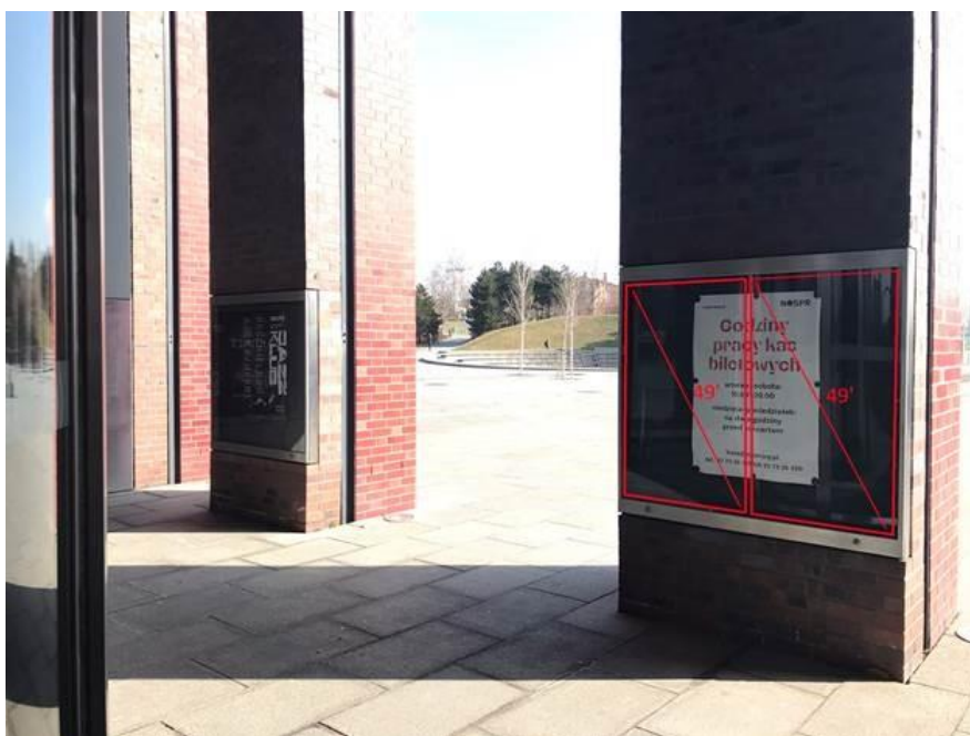
Zdjęcie nr 2 1 sztuka gabloty od wejścia do budnymku NOSPR od ulicy. Jerzego Haralda
