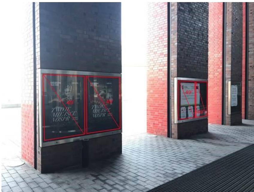
Zdjęcie nr 1. 2 sztuki gablot przy głównym wejściu do budynku NOSPR przy pl. Wojciecha Kilara
