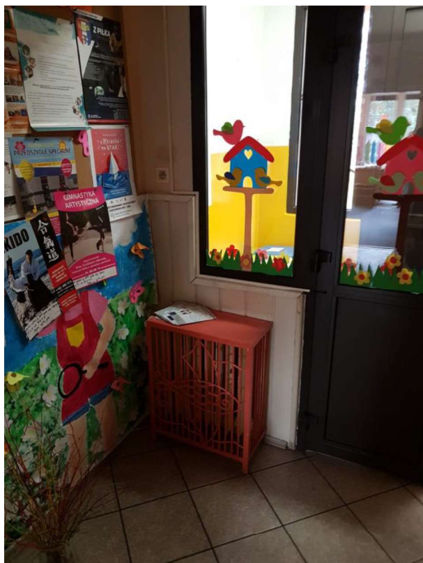
Fot. 18. Obudowany grzejnik żeliwny w holu
