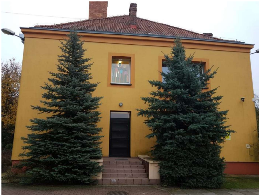
Fot. 3. Widok elewacji zachodniej
