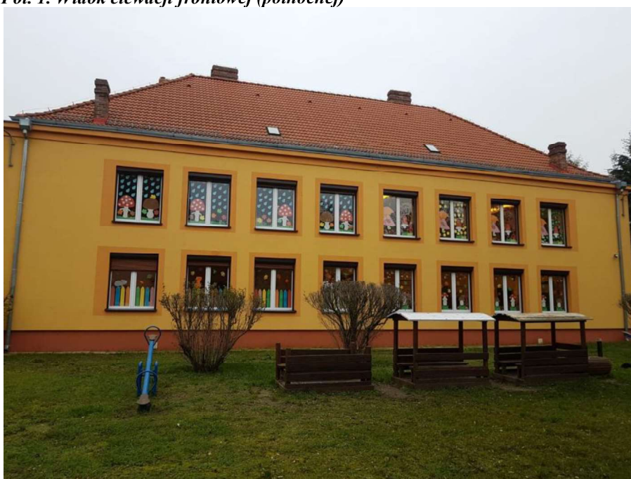
Fot. 2. Widok elewacji południowej
