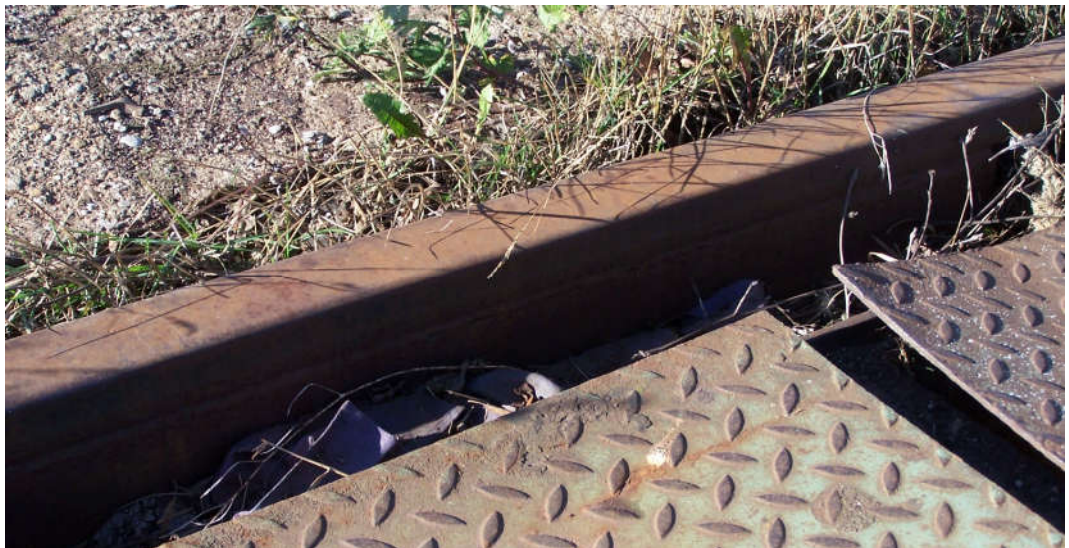
Rys. 4.17. Wypłaszczona główka szyny S49
