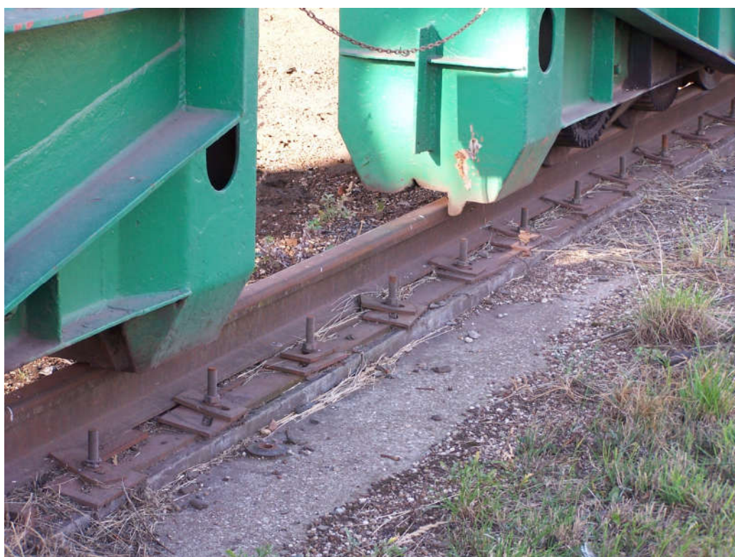
Rys. 4.20. Poluzowane mocowania punktowe
