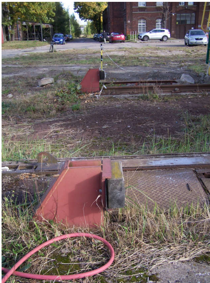
Rys. 4.25. Bufory szyn poddźwigowych
