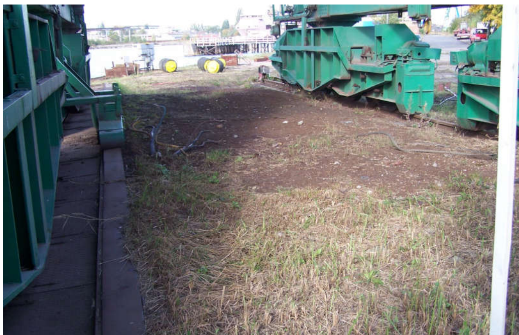
Rys. 4.5. Widok na strefę międzyszynową - wyciągnięte przewody elektryczne
