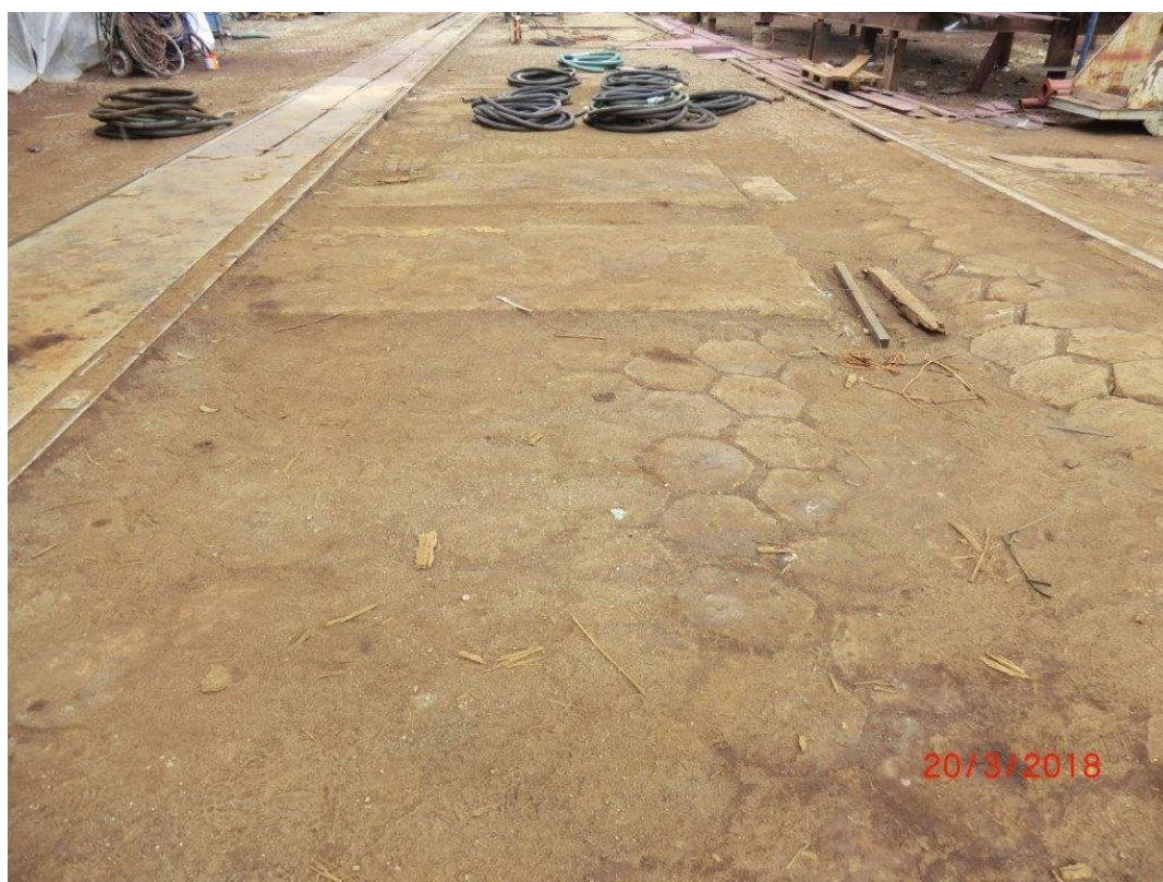
Rys. 4.9. Trzy różne konstrukcje nawierzchni na wskazanym fragmencie
