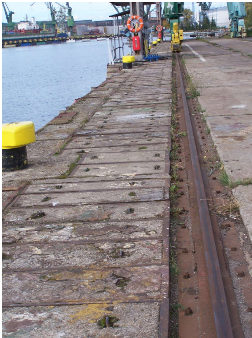
Rys. 7.1. Zabudowany tor podźwigowy
