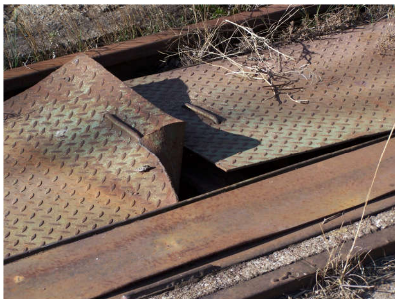
4.24. Pokrycia kanału z ciężniami
