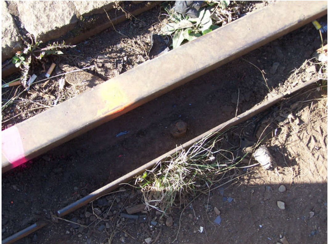
Rys. 4.21. Szyna dospawana do blachy podszynowej
