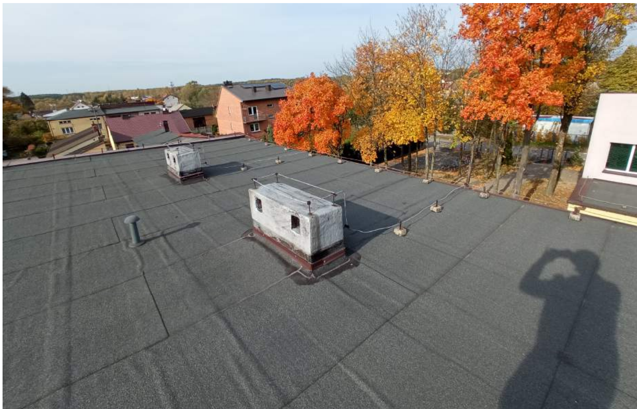
Fot. 1. Widok na dach
