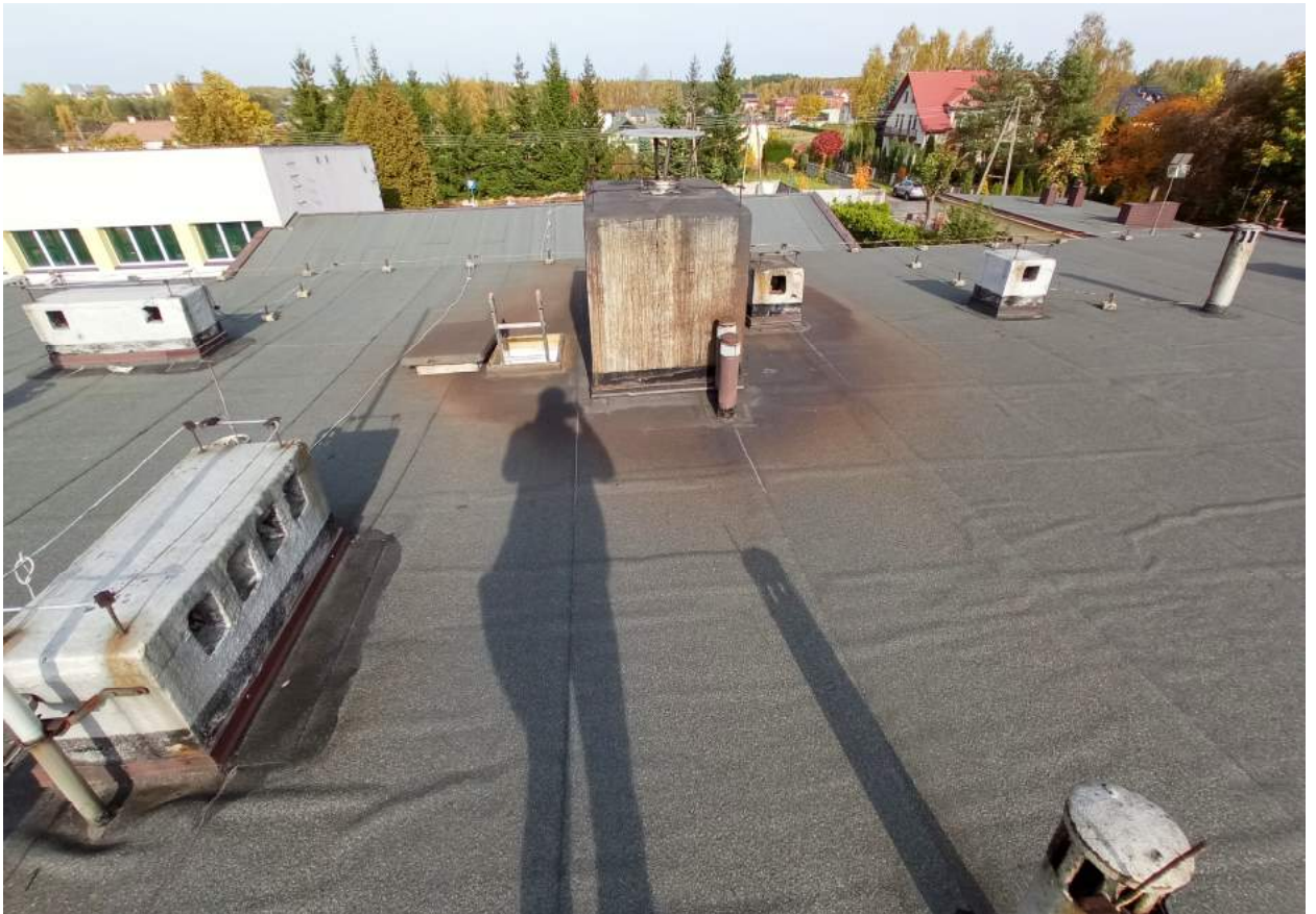
Fot. 4. Widok na dach
