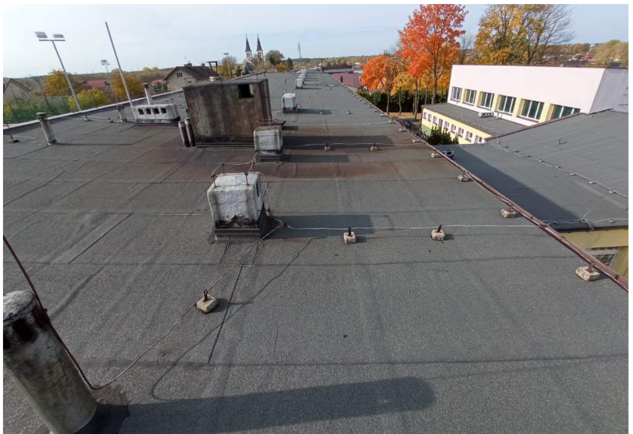
Fot. 5. Widok na dach
