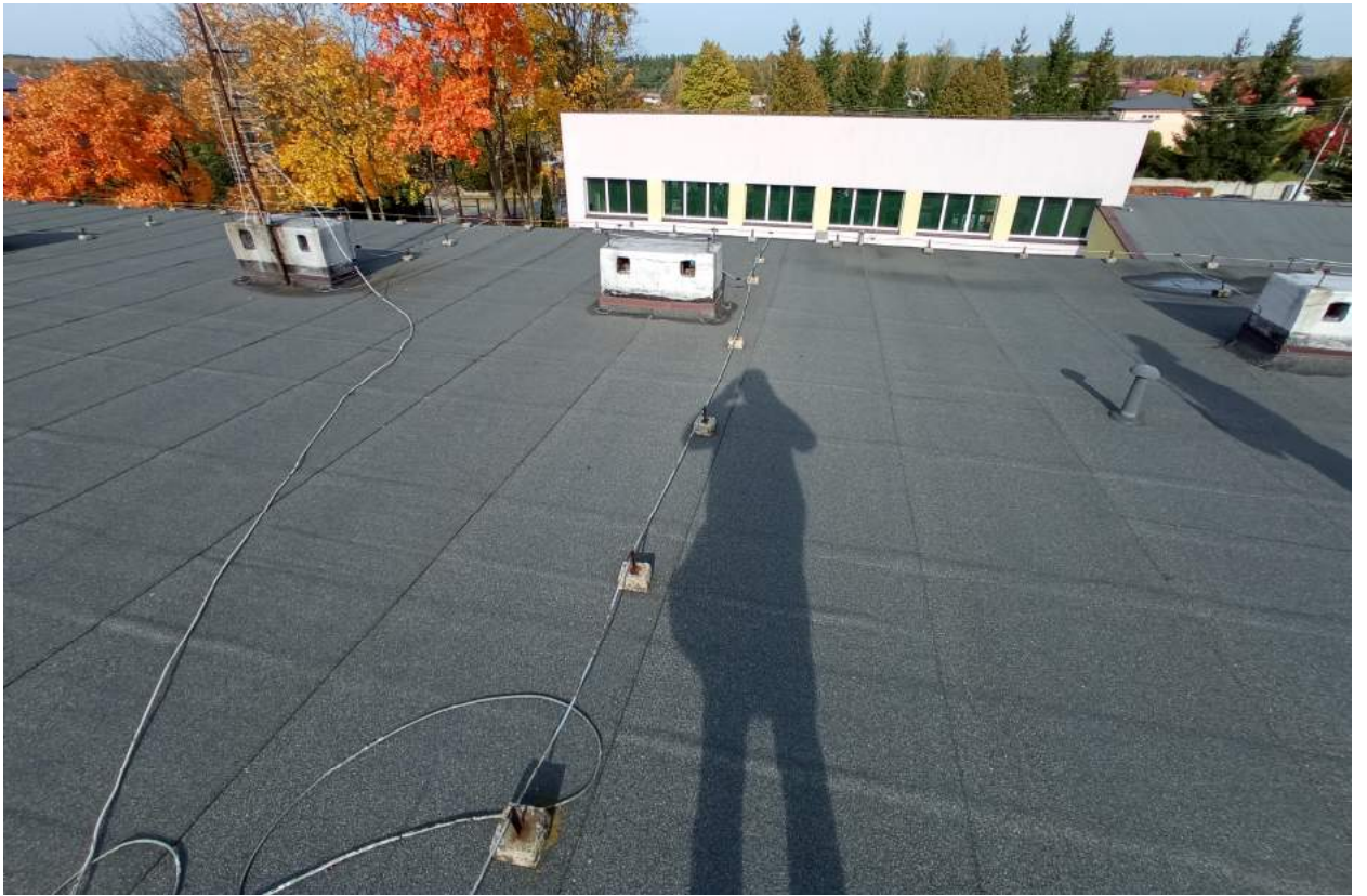
Fot. 2. Widok na dach
