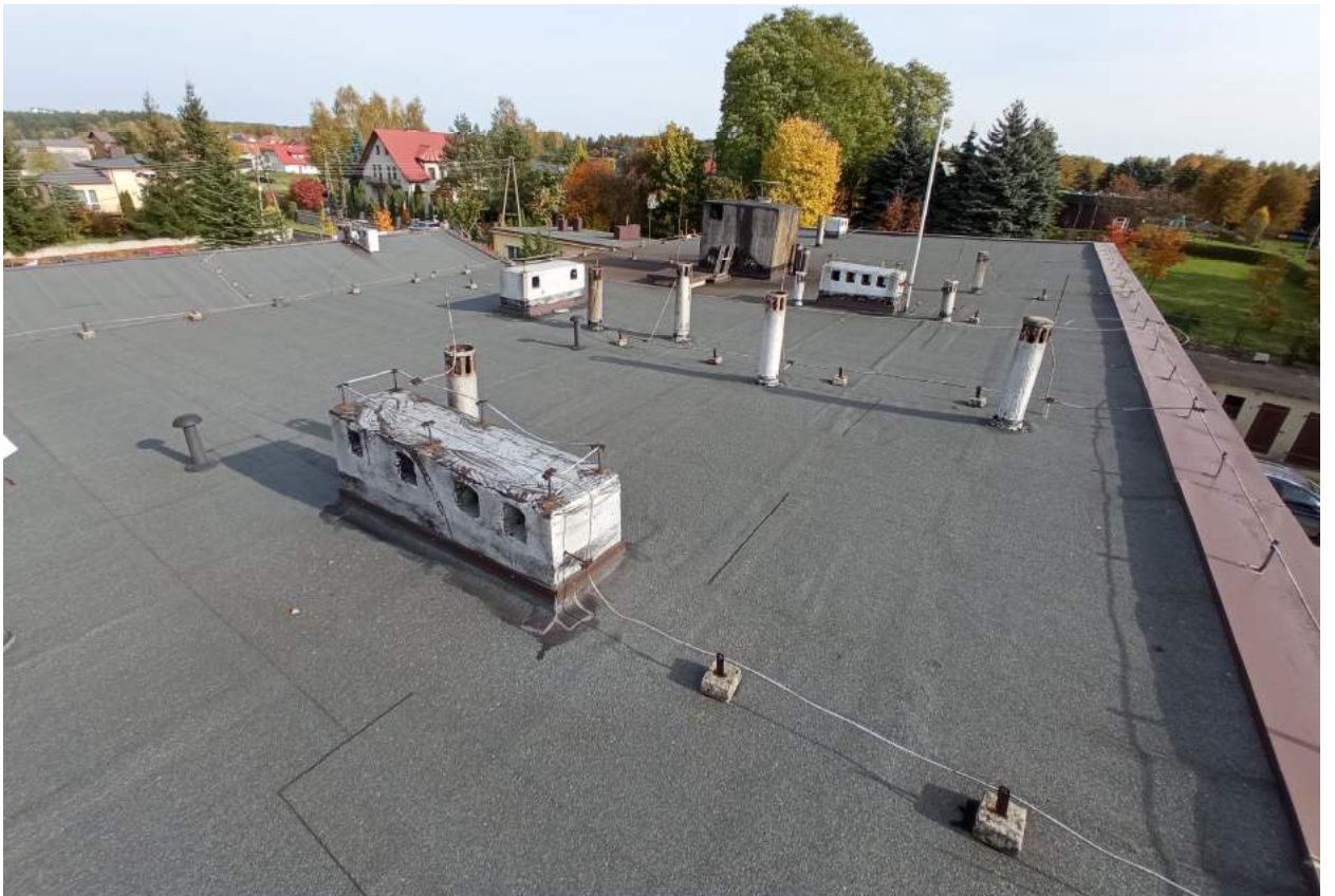
Fot. 3. Widok na dach
