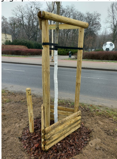
fot. 20 dodatkowy palik do montażu worków nawadniających/ fot. aut. Agata Walek
