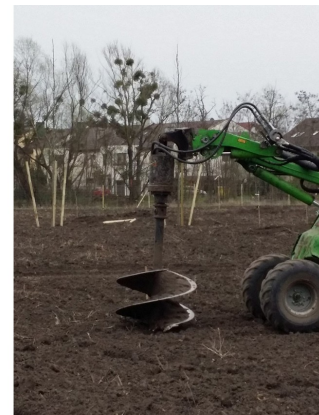
fot. 17, 18 kontrola wielkości dołów nasadzeniowych przez nadzór dendrologiczny / fot. 19 wykonywanie dołów nasadzeniowych przy użyciu wiertnicy/ fot. aut. Agata Walek
