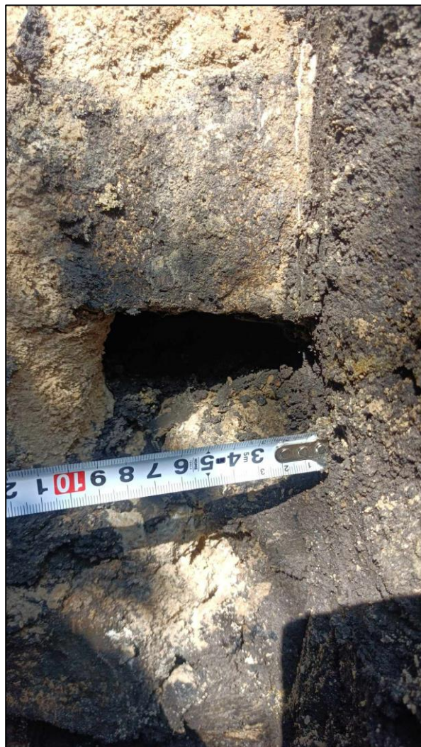
Zdjęcie 3. Ubytki zaprawy w fundamencie
