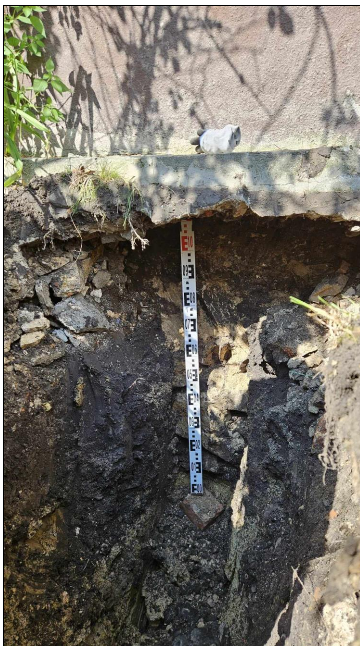
Zdjęcie 1. Odkrywa fundamentu
