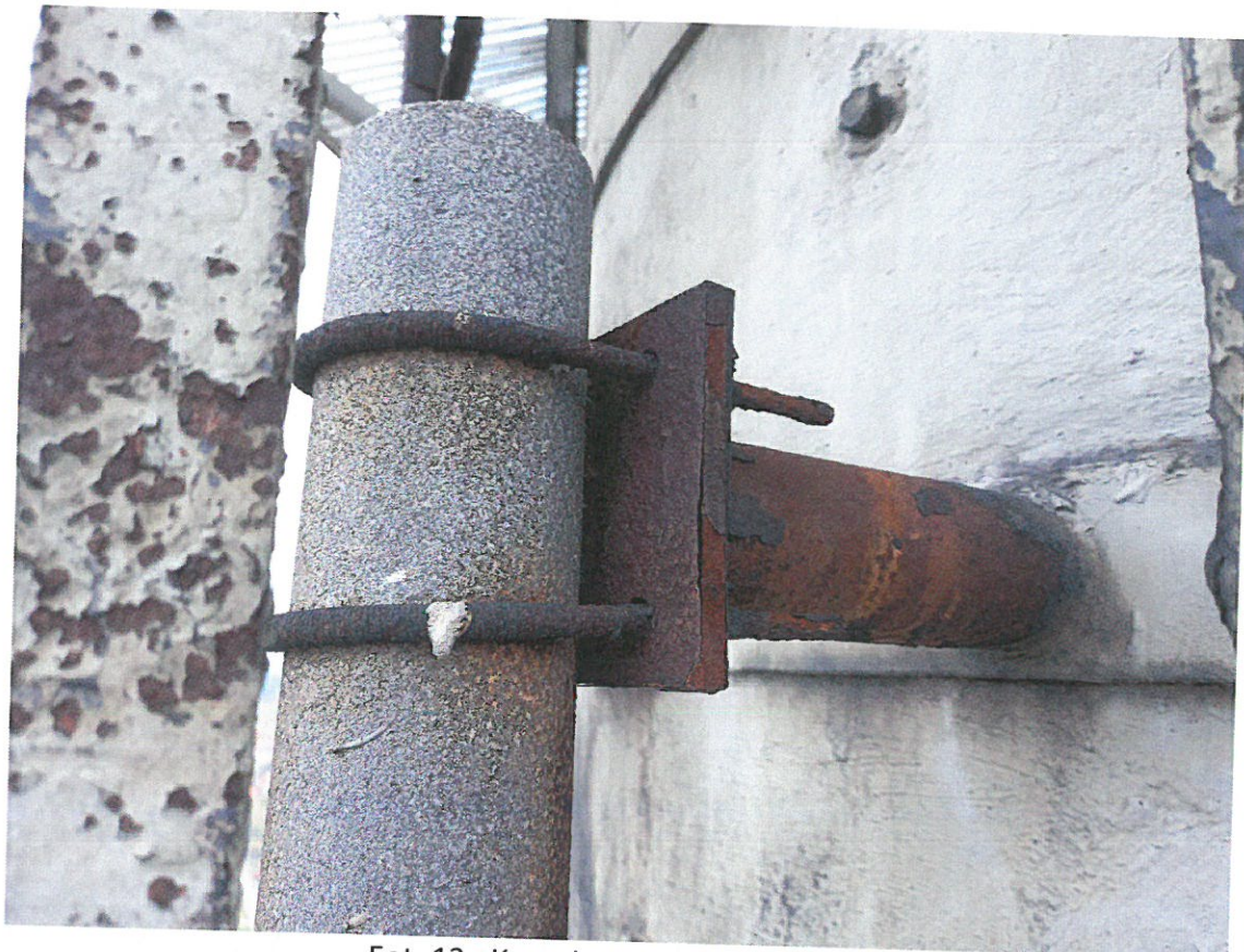
Fot. 13. Korozja wsporników anten
