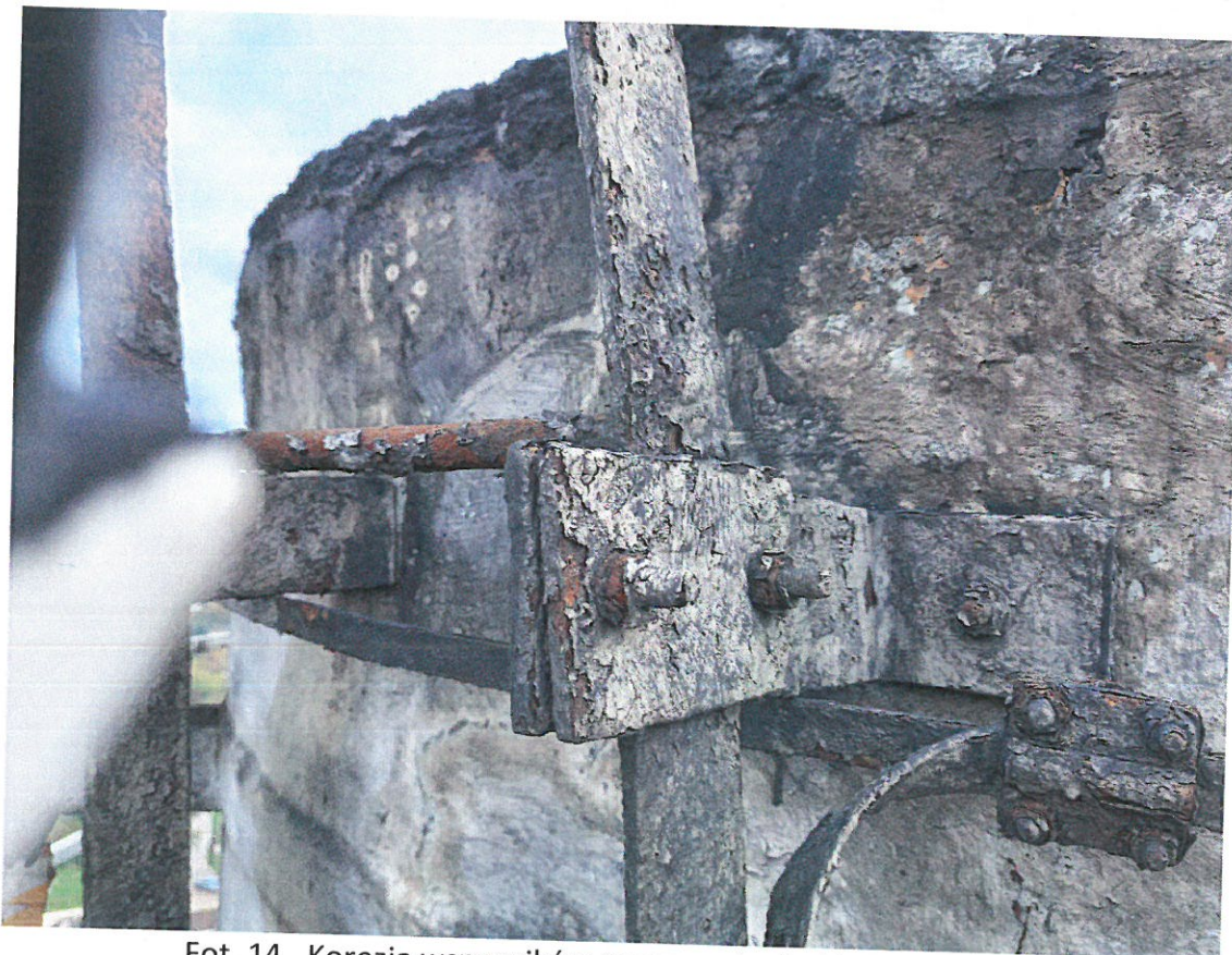
Fot. 13. Korozja wsporników anten
