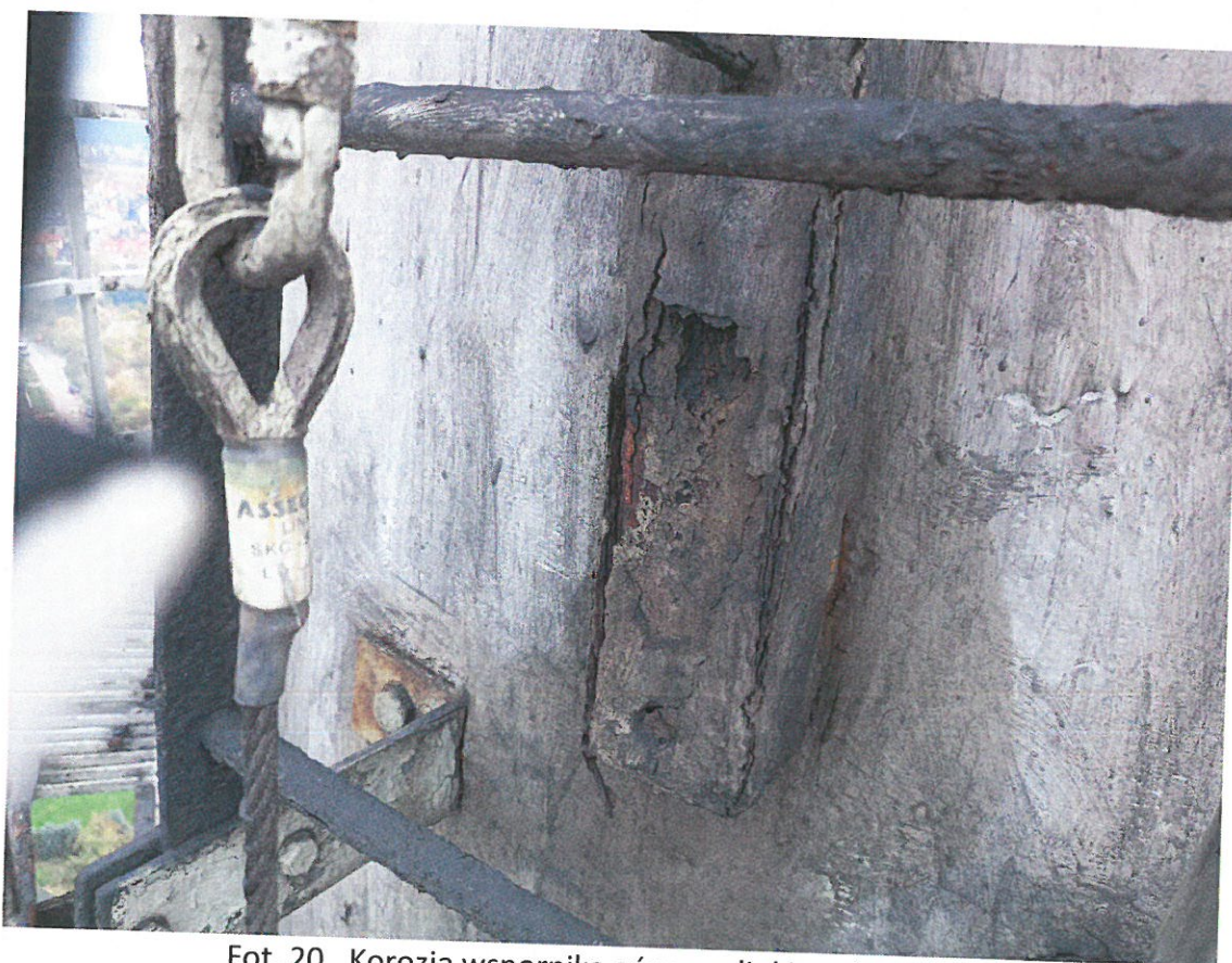
Fot. 19. Korozja elementów galerii
