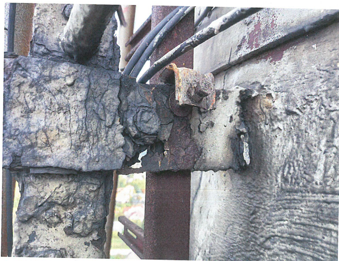
Fot. 8. Skorodowany uchwyt drabiny wejściowej.
