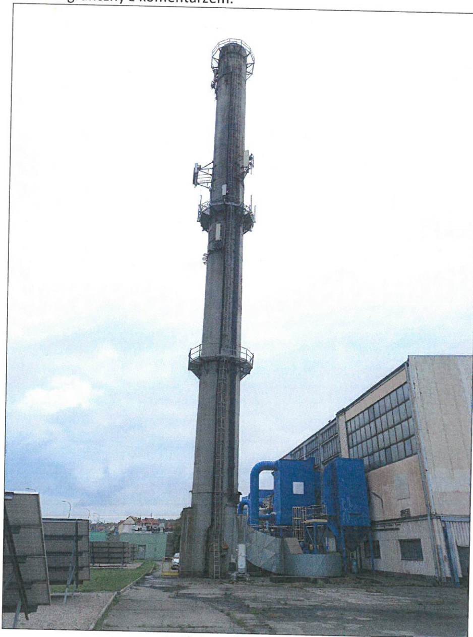
Widok ogólny komina
