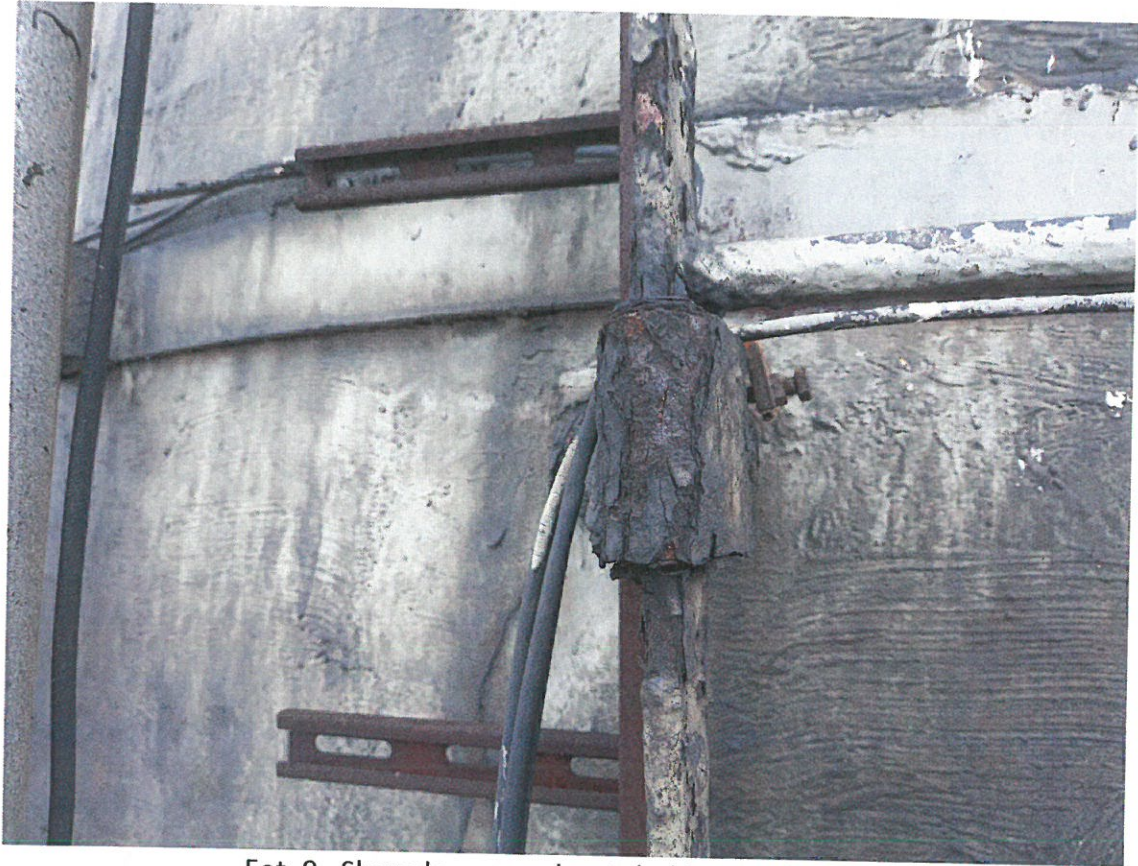
Fot. 9. Skorodowany uchwyt drabiny wejściowej.
