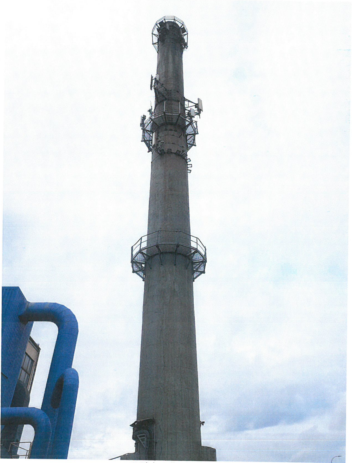
Widok ogólny komina
