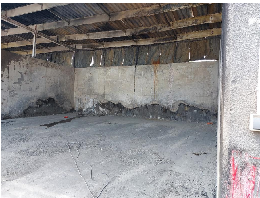
Fot. 3.3 Widok ogólny konstrukcji wiaty – widoczne uszkodzenia konstrukcji stalowej oraz konstrukcji żelbetowej (wykruszenia oraz zarysowanie otuliny)
