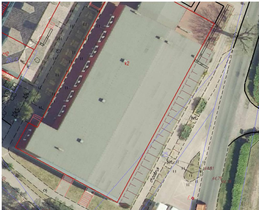
Część dachu budynku Sali gimnastycznej, na której planuje się montaż instalacji PV.
