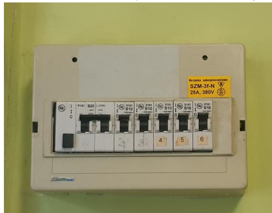
Rozdzielnia elektryczna – przedpokój
