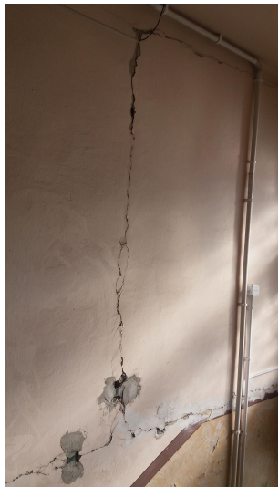
USZKODZENIA TYNKU I LUKSFERY NA KLATCE SCHODOWEJ
