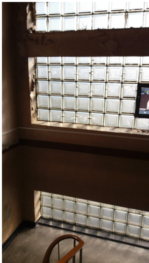
USZKODZENIA TYNKU I LUKSFERY NA KLATCE SCHODOWEJ
