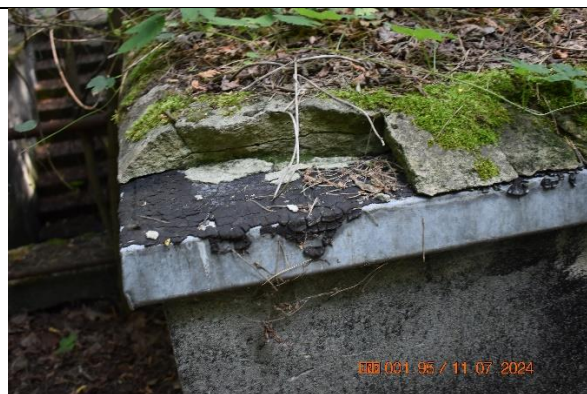
Widok płyty stropodachu i wylewki spadkowej z pozostałością izolacji
