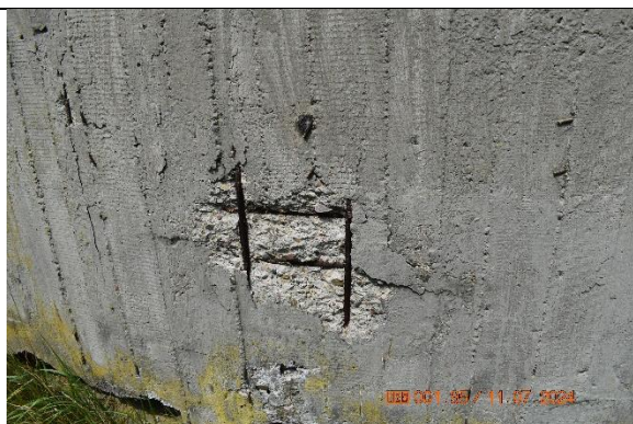
Odkrywka zbrojenia
