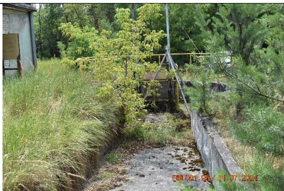
Widok utwardzenia z płyty żelbetowej – dojazd do studni
