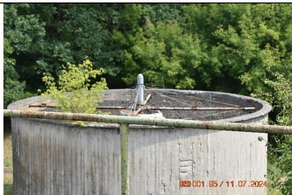
Widoczne zasypanie zbiorników oraz zraszacz złoża
