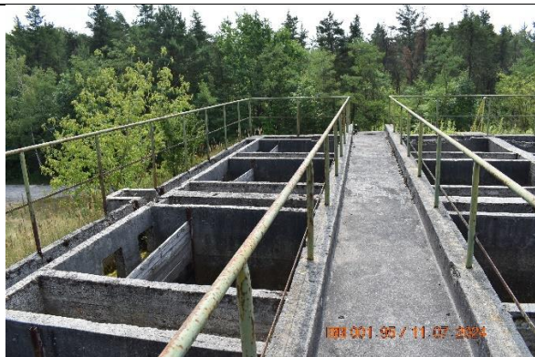
Widok typowych żelbetowych zbiorników Imhoffa
