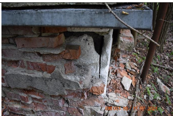
Widok ściany warstwowej
