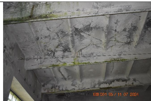
Widok stropu z prefabrykowanych płyt korytkowych
