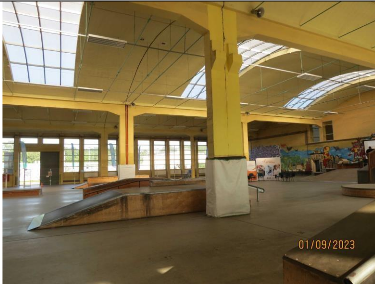
Fot. 4. Widok fragmentu hali wzdłuż dylatacji E/F.
