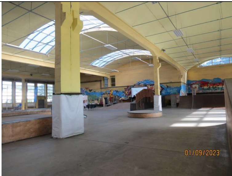
Fot. 5. Widok fragmentu hali między osiąmi 1-3 oraz F-H.
