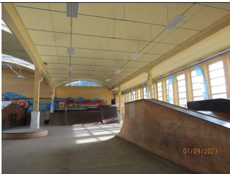
Fot. 6. Widok fragmentu hali między osiąmi 3-4 oraz F-H.
