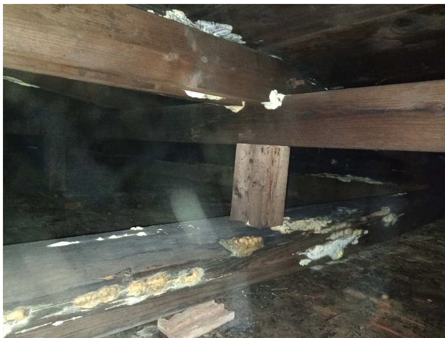
Rysunek 13 Przestrzeń dachowa nad częścią niską, zaawansowana infekcja grzybami
