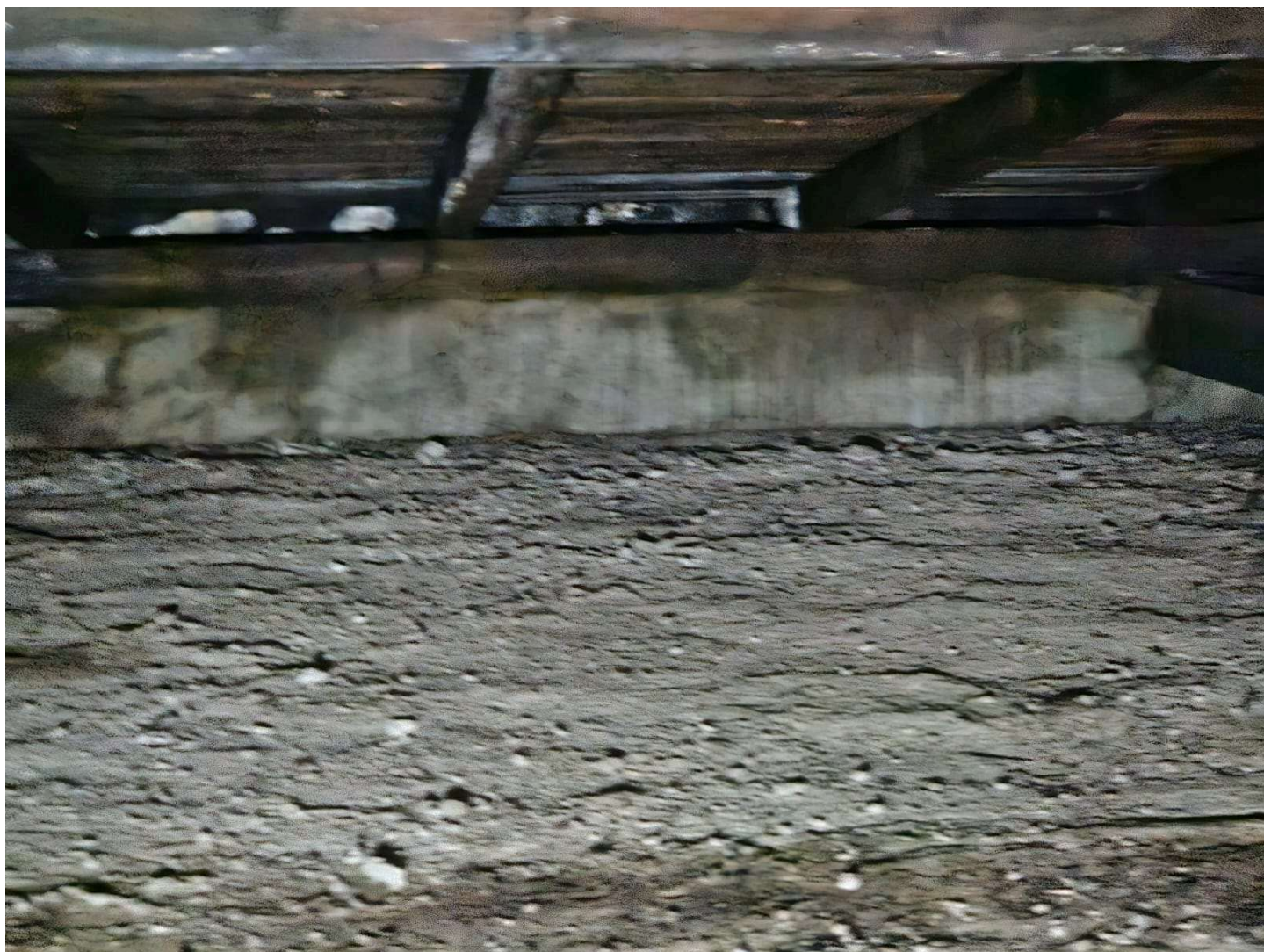
Zawilgocenie ścianki kolankowej
