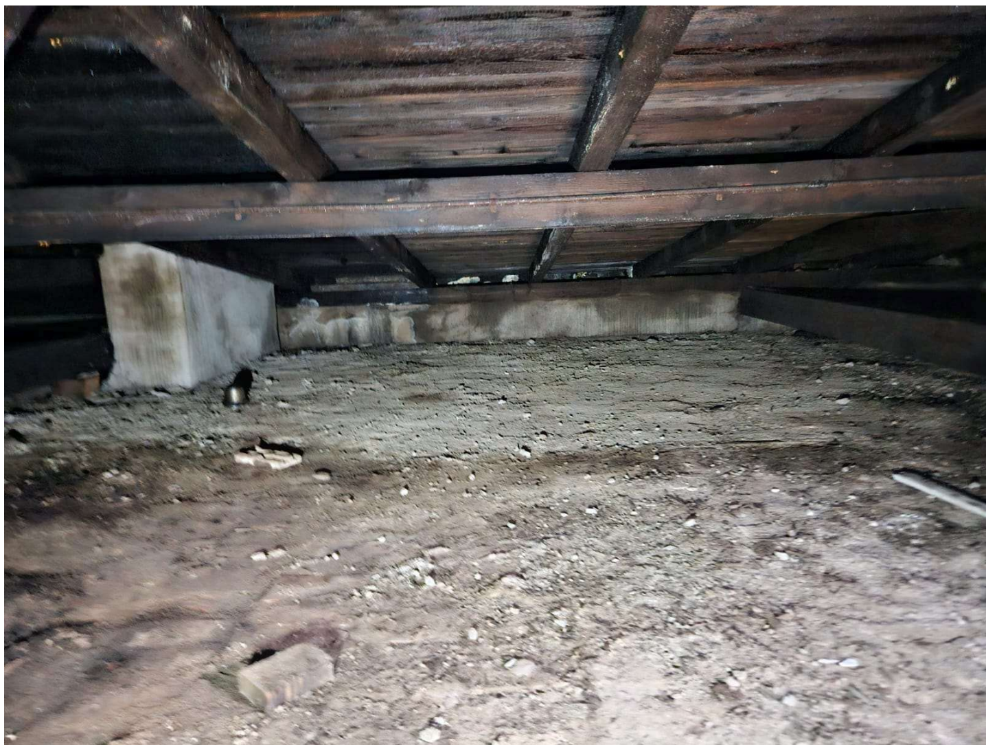
Zawilgocenie ścianki kolankowej, zły stan stropu
