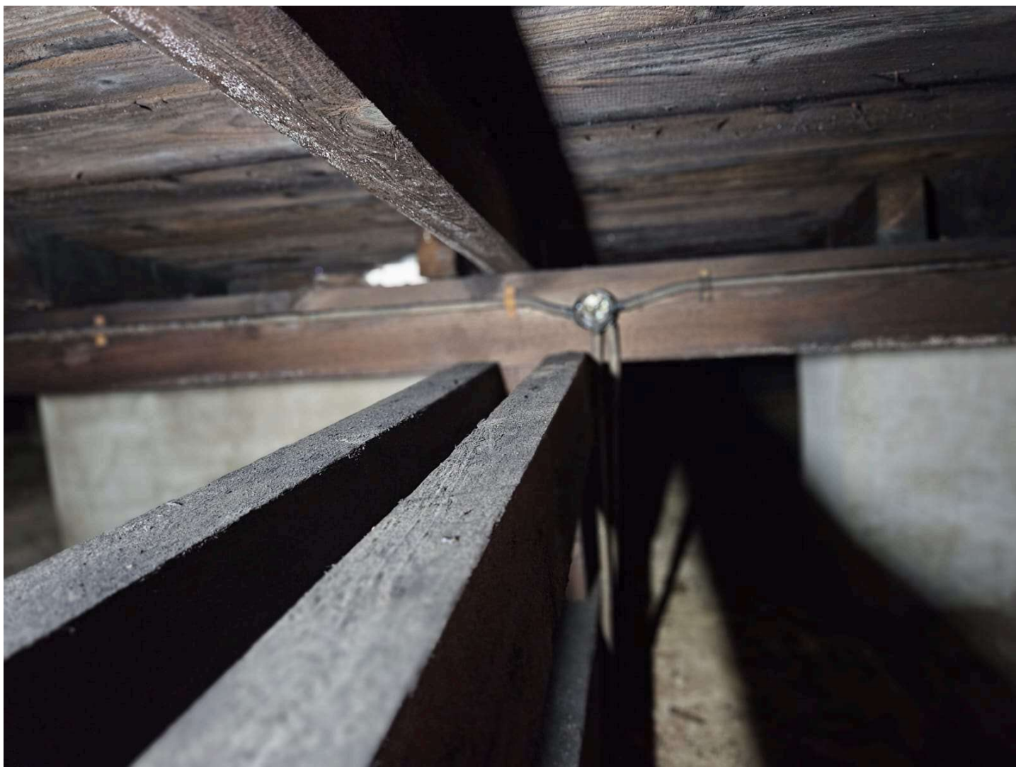
Instalacja elektryczna zagrażająca zapaleniem
