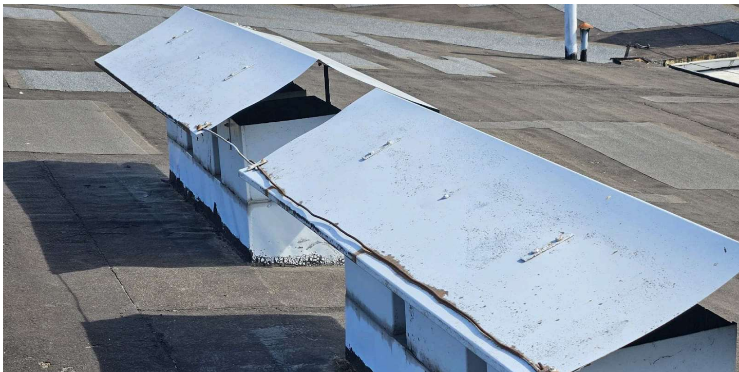
Źle wykonane obróbki
