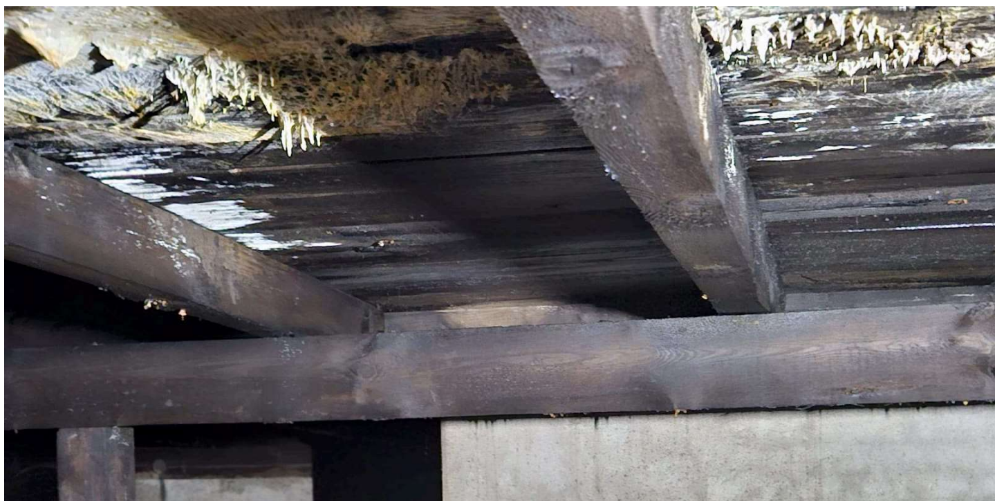
Uszkodzone poszycie
