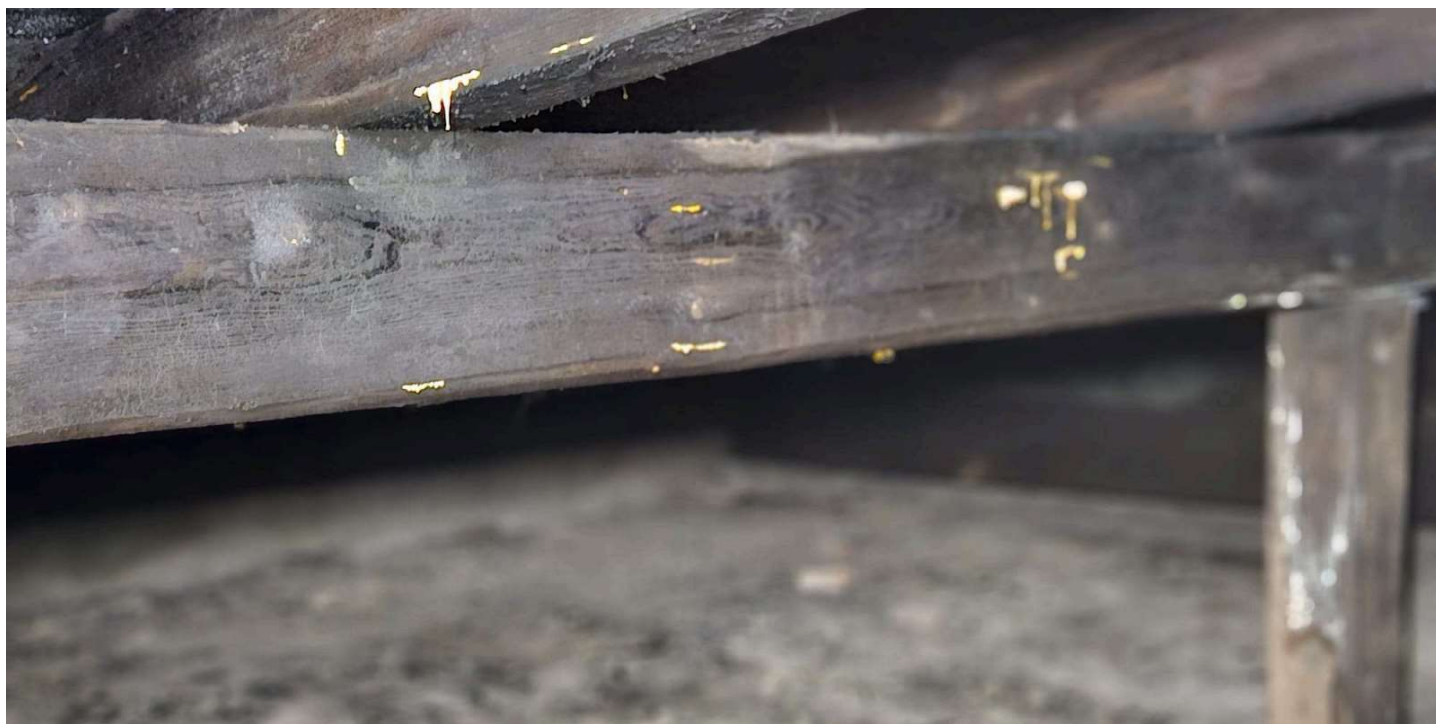
Uszkodzone elementy konstrukcyjne więźby
