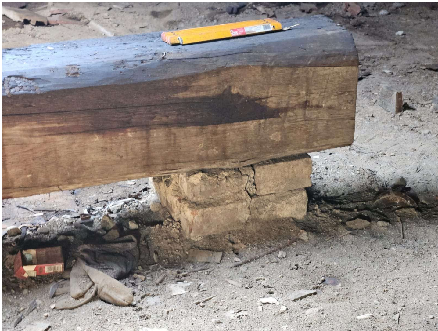
Nieprawidłowe podwaliny pod kleszczami
