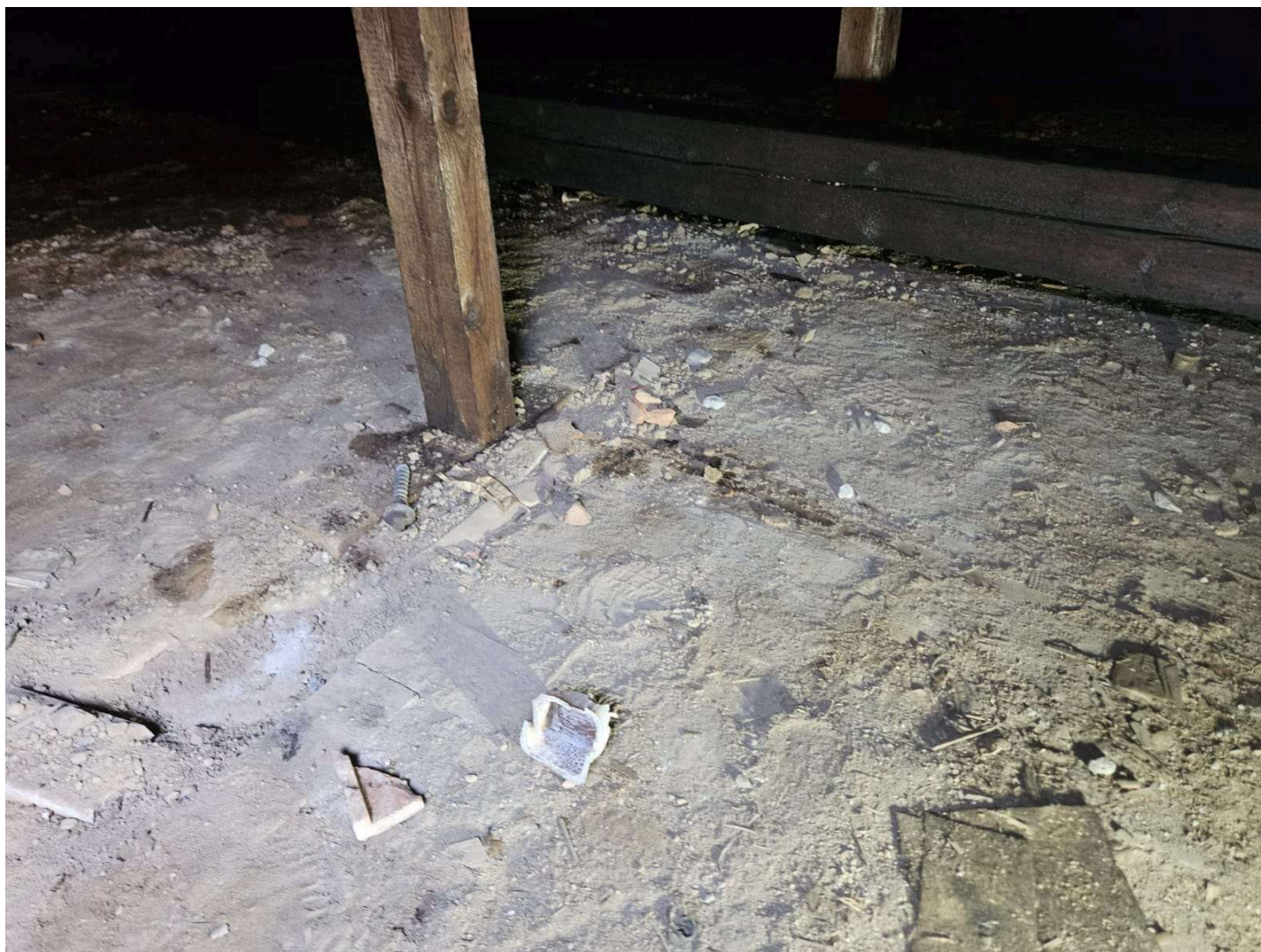
Katastrofalny stan podwalin pod słupami
