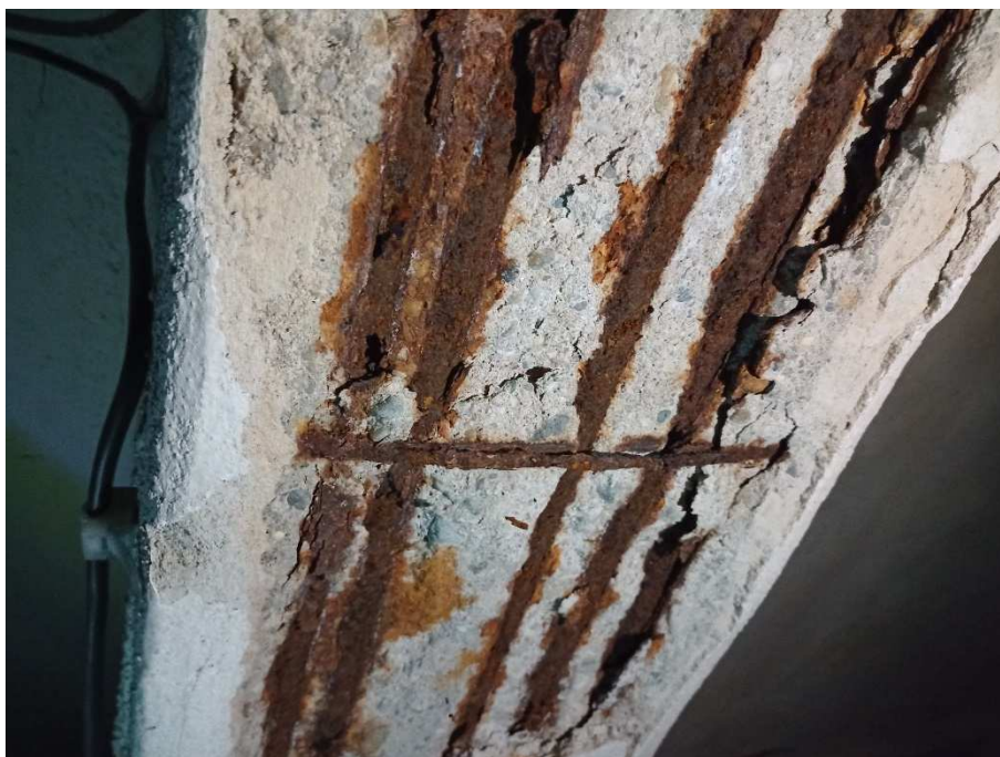
Rysunek 5 Korozja stali zbrojeniowej głównego podciągu w piwnicy
