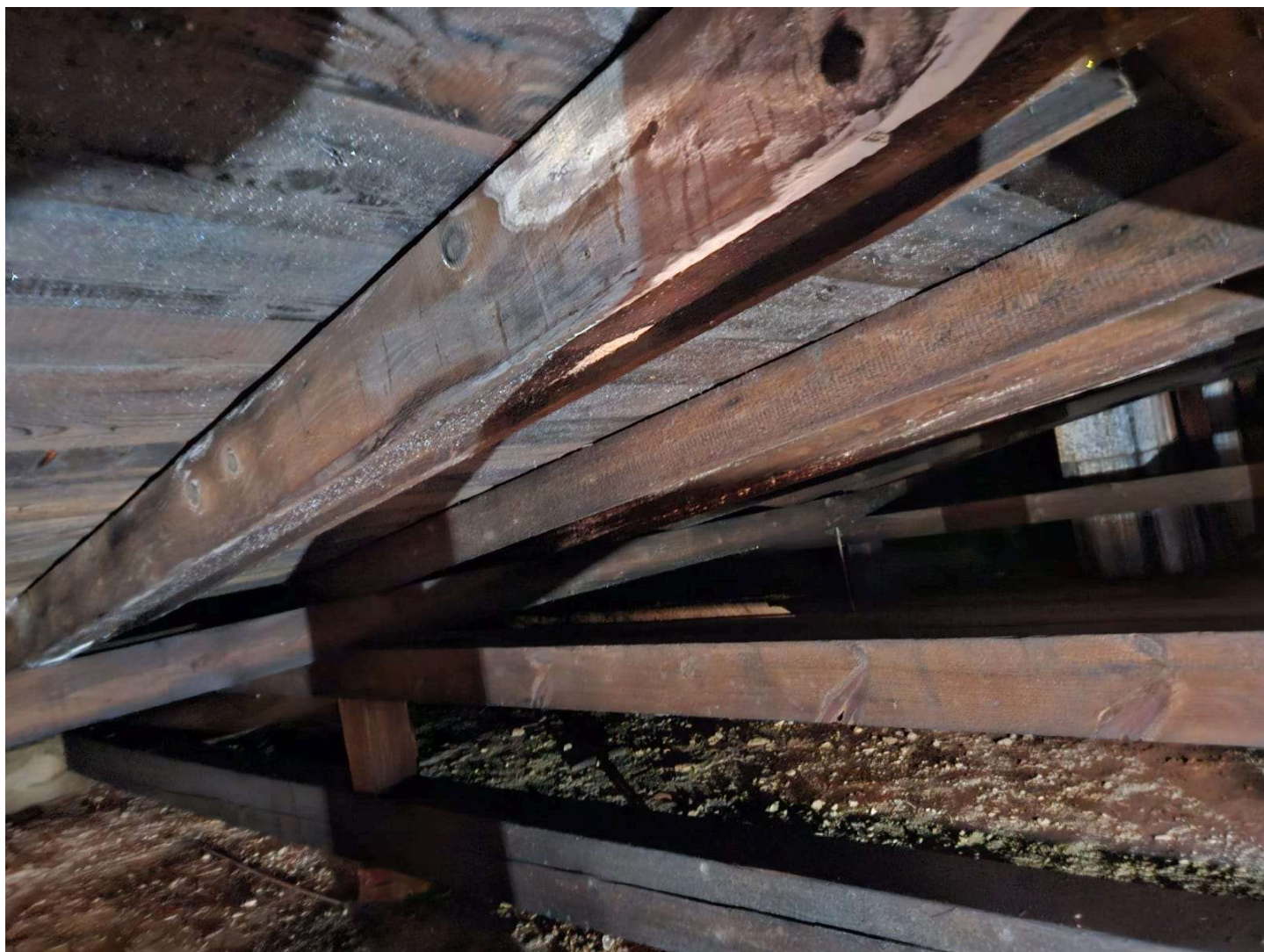
Uszkodzone krokwie
