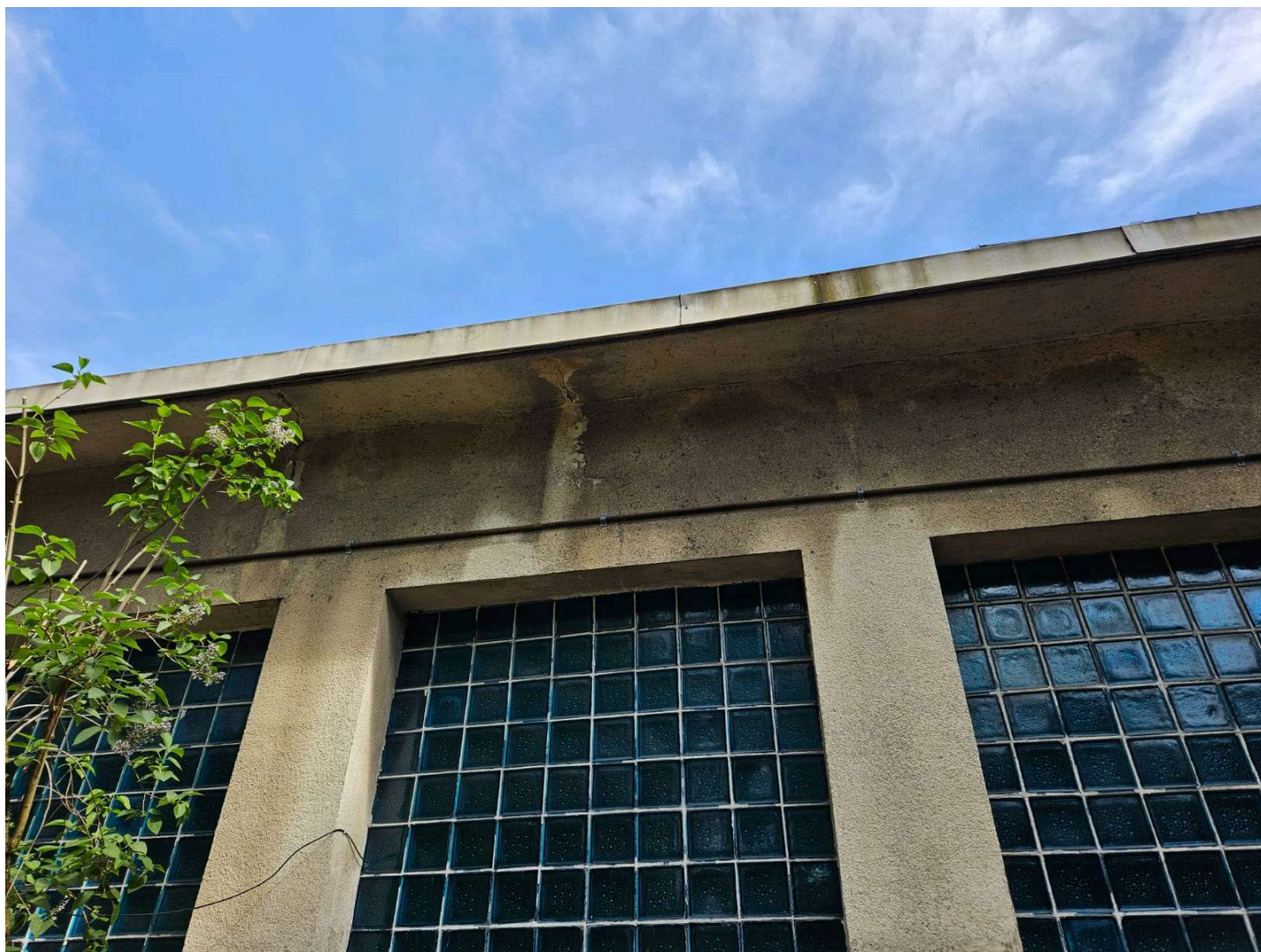
Zawilgocenia ścian w wyniku źle wykonanych obróbek na styku ściany z dachem, rynien spustowych
