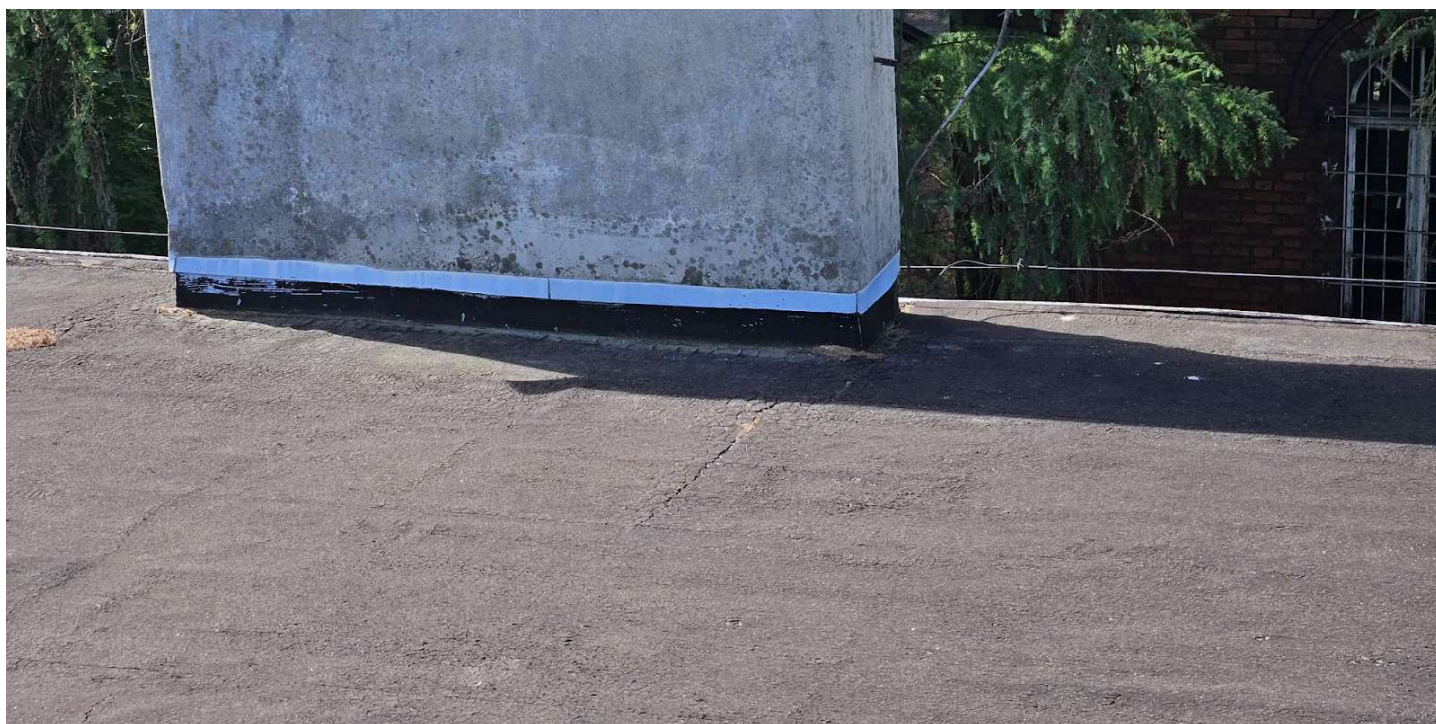
Źle wykonane obróbki
