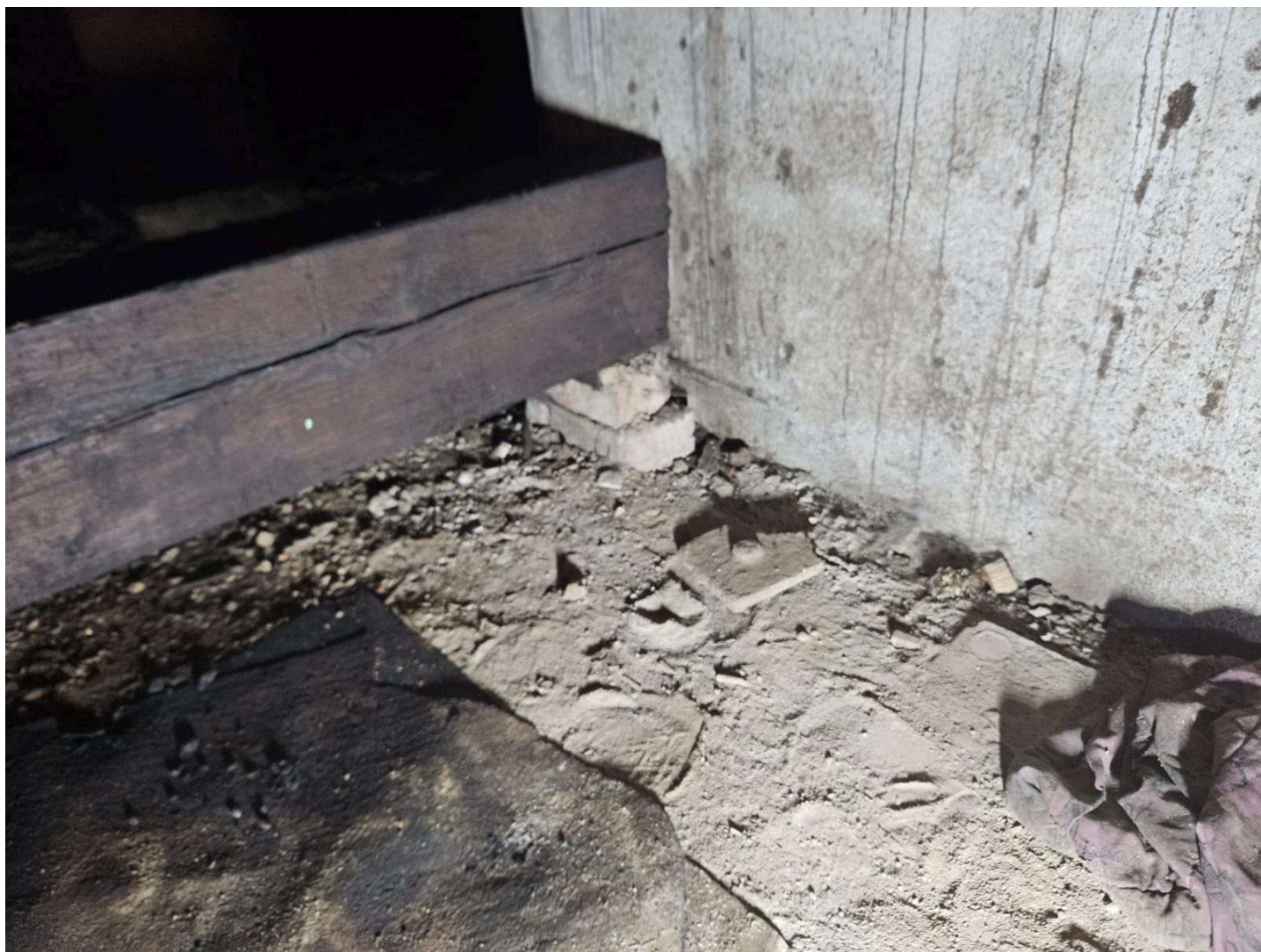
Podwaliny pod kleszczami z cegły
