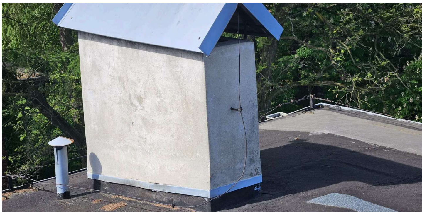
Źle wykonane obróbki
