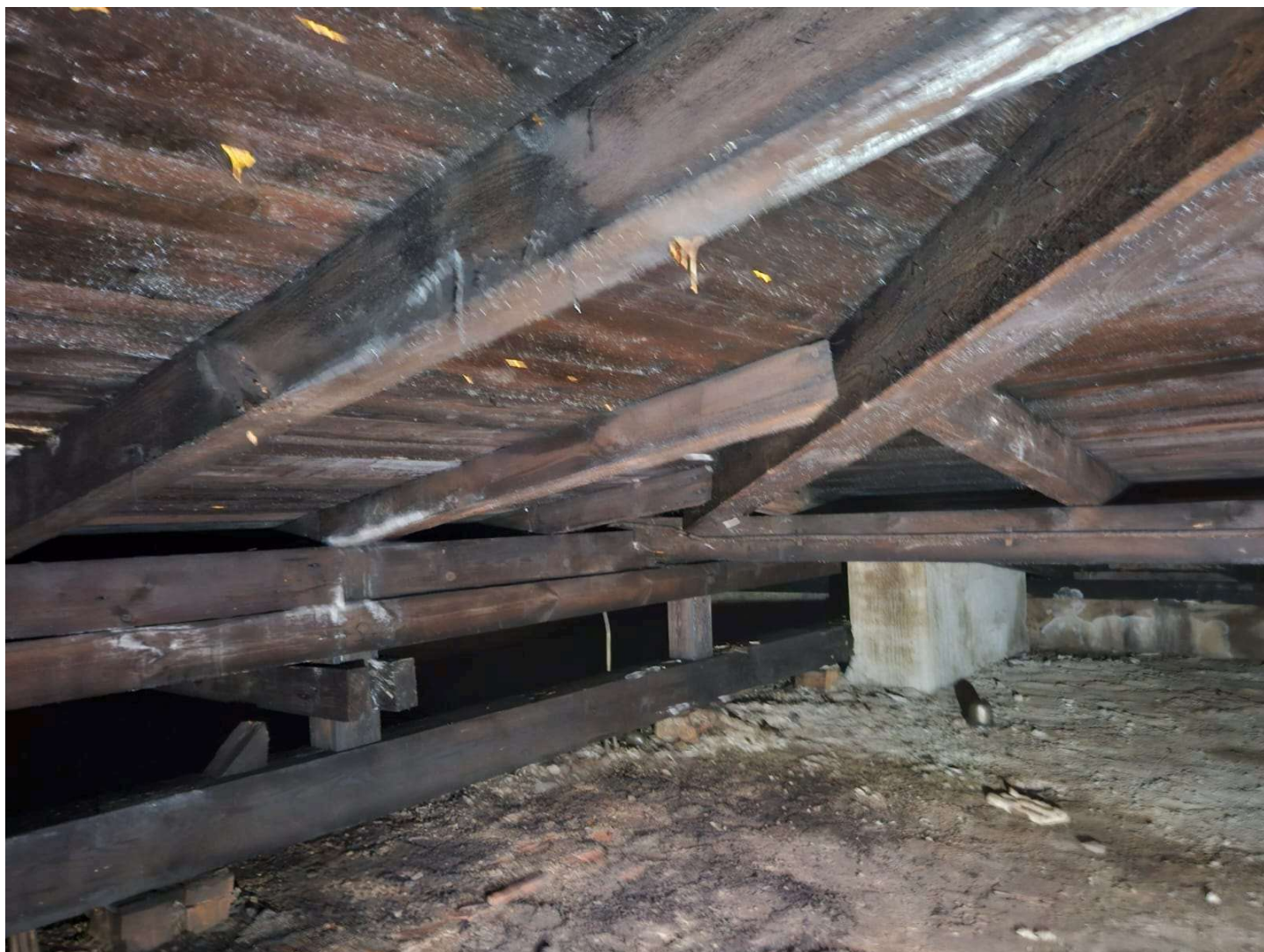
Zawilgocenie więźby dachowej
