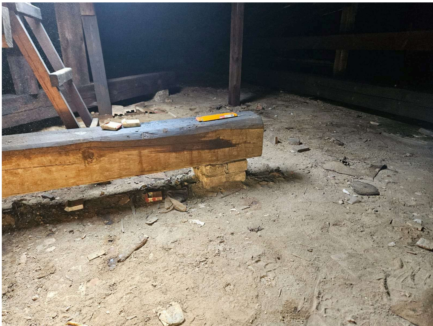
Złe podwaliny pod kleszczami
