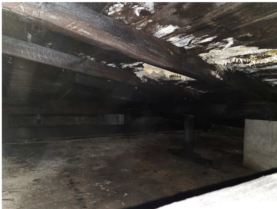
Rysunek 15 Przestrzeń dachowa nad częścią wysoką, zaawansowana infekcja grzybami
