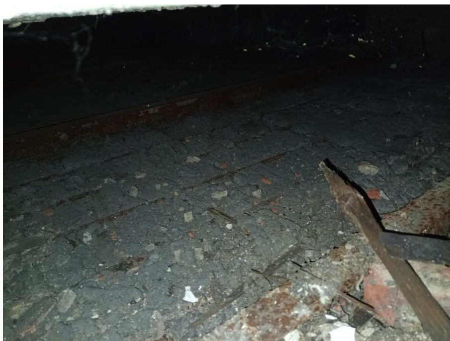
Rysunek 10 Dolna płyta stropu nad parterem, zaawansowana korozja kształtowników stalowych i zbrojenia
