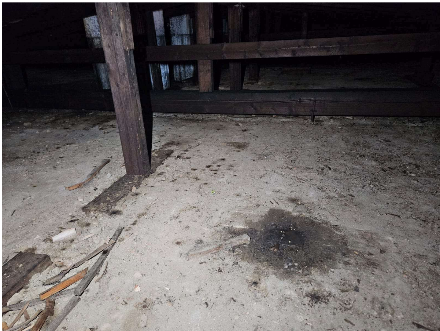
Zapadnięta w strop deska podwaliny w stropie
