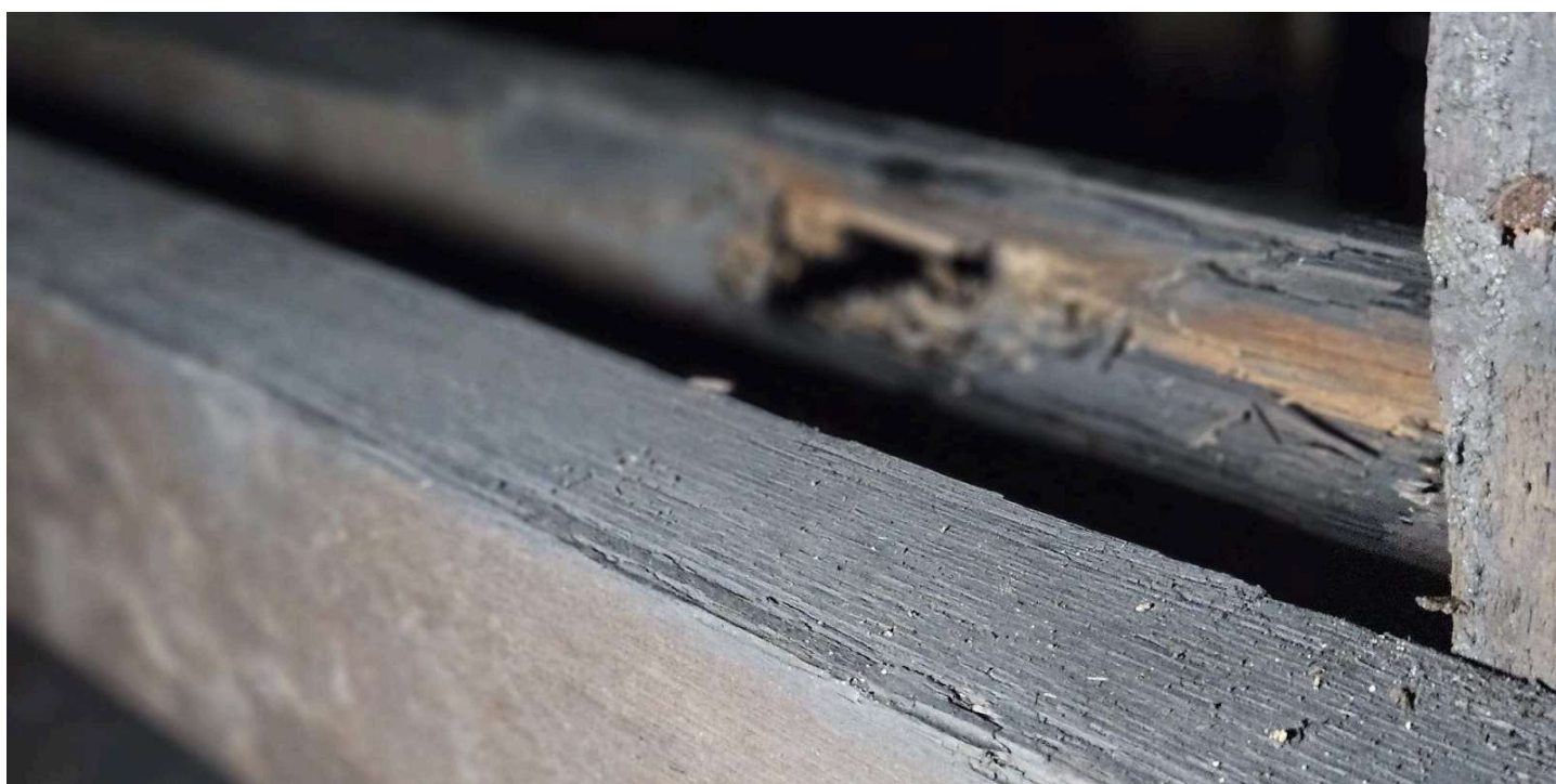
Uszkodzone elementy konstrukcyjne więźby
