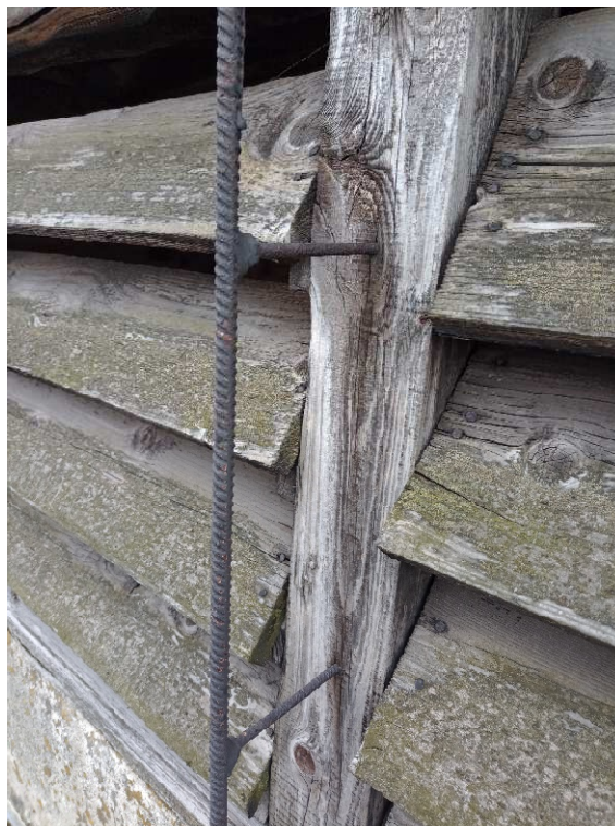
Rysunek 17 Fragment zadaszienia nad szymbem windowym, niewłaściwy montaż odgromu
