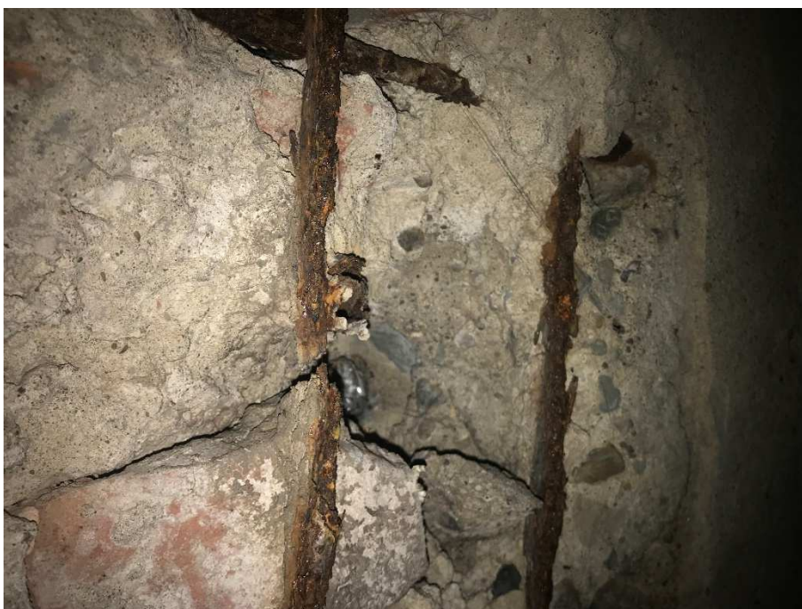
Rysunek 6 Pęknięcie nadproża i brak ciągłości zbrojenia nadproża w piwnicy
