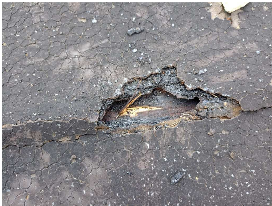
Rysunek 14 Odspojona i spękana papa na dachu części niskiej
