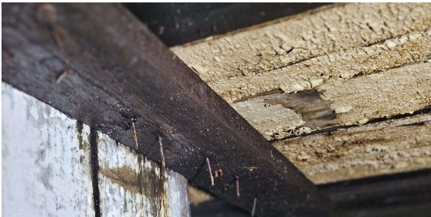
Uszkodzone poszycie
