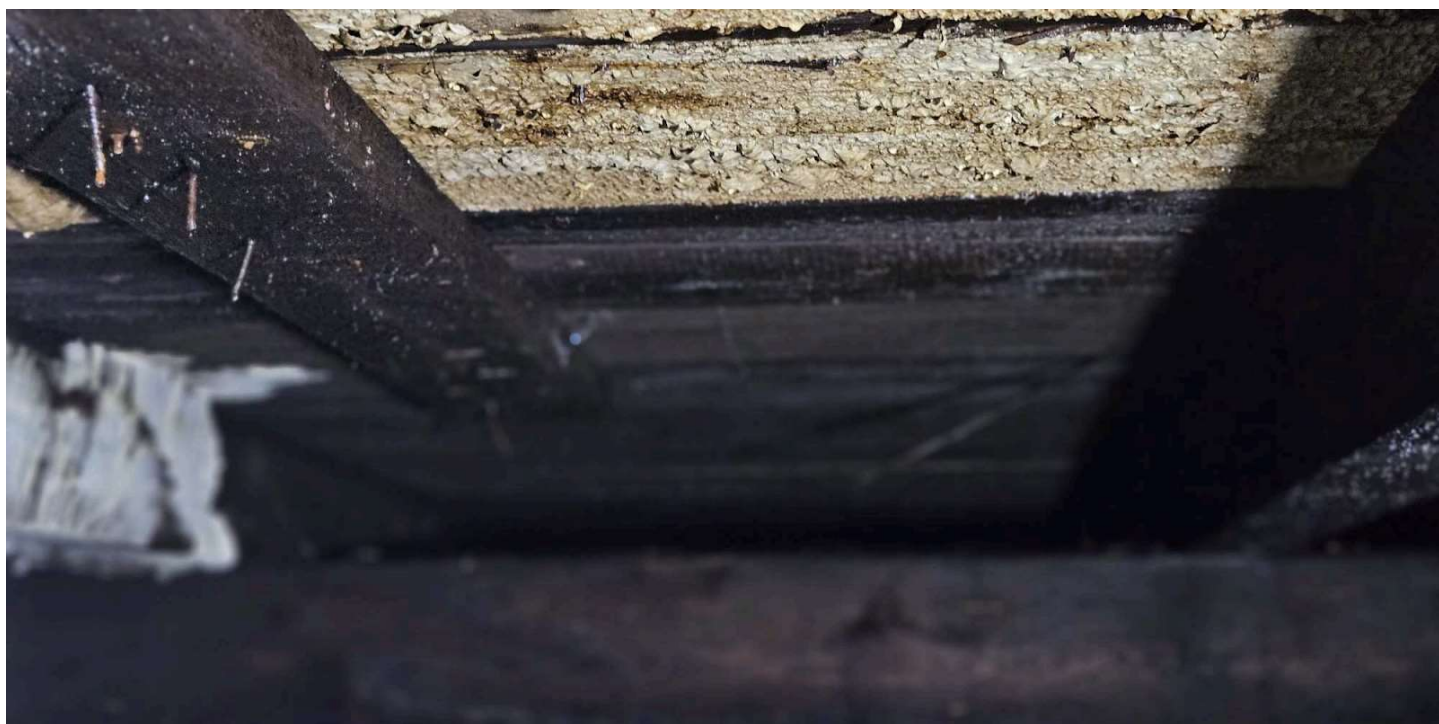
Uszkodzone poszycie
