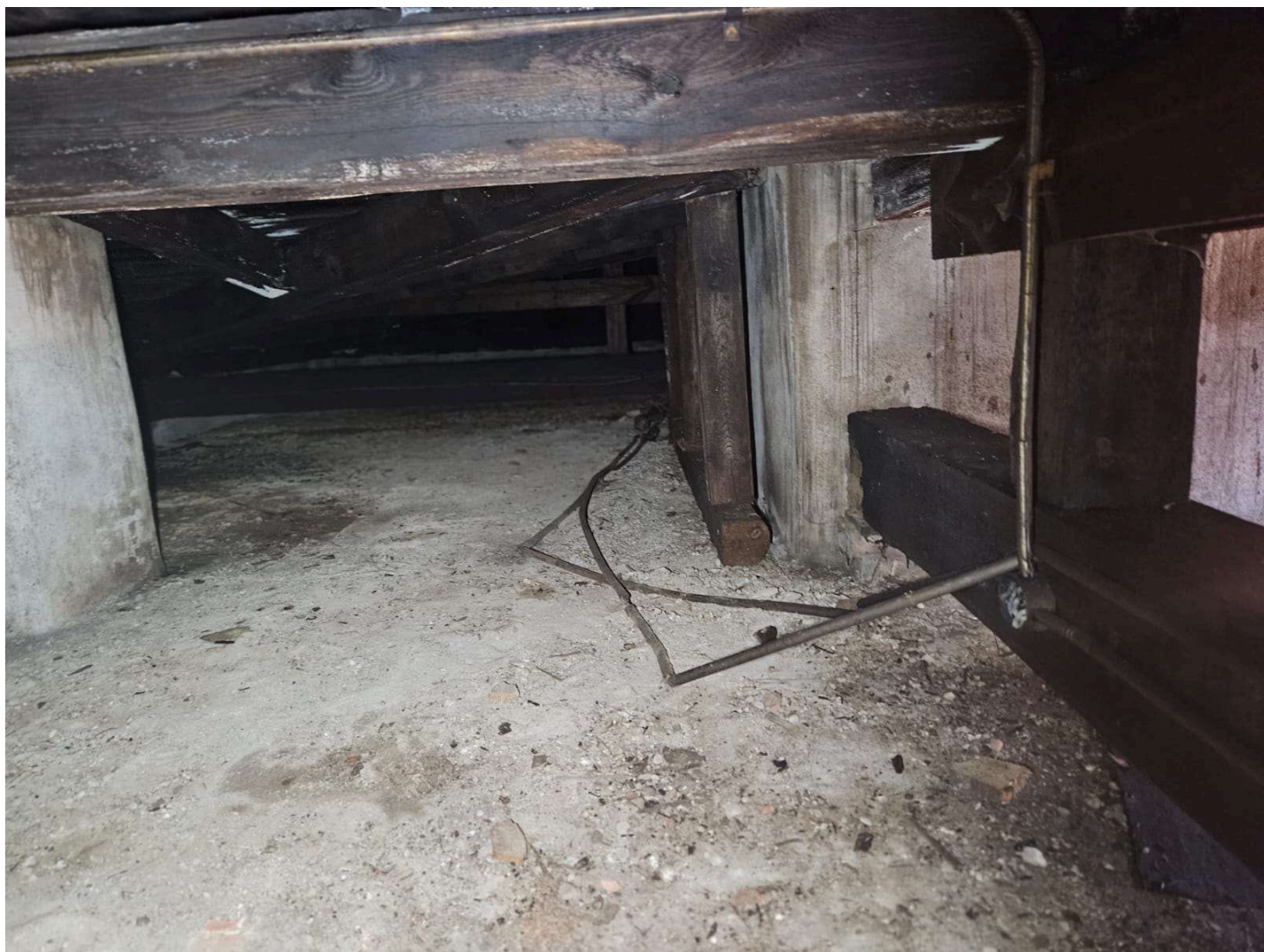
Instalacja elektryczna zagrażająca zapaleniem
