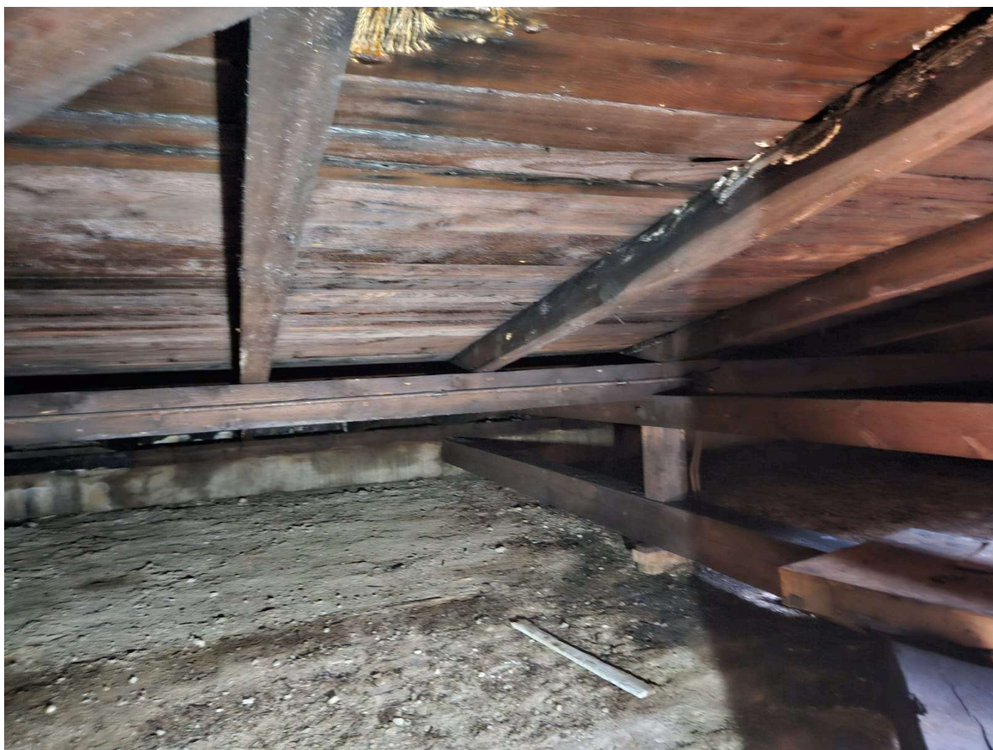
Uszkodzenia krokwi oraz poszycia
