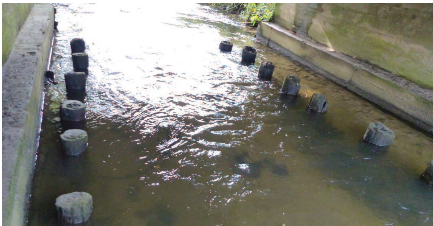
Fot. 8 Widok przestrzeni podmostowej
