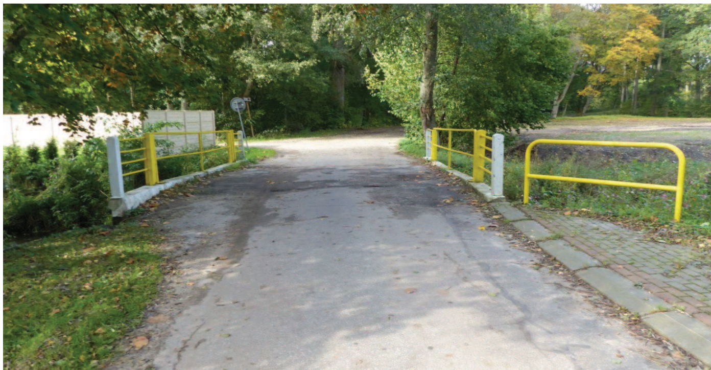
Fot. 3 Widok mostu z góry
