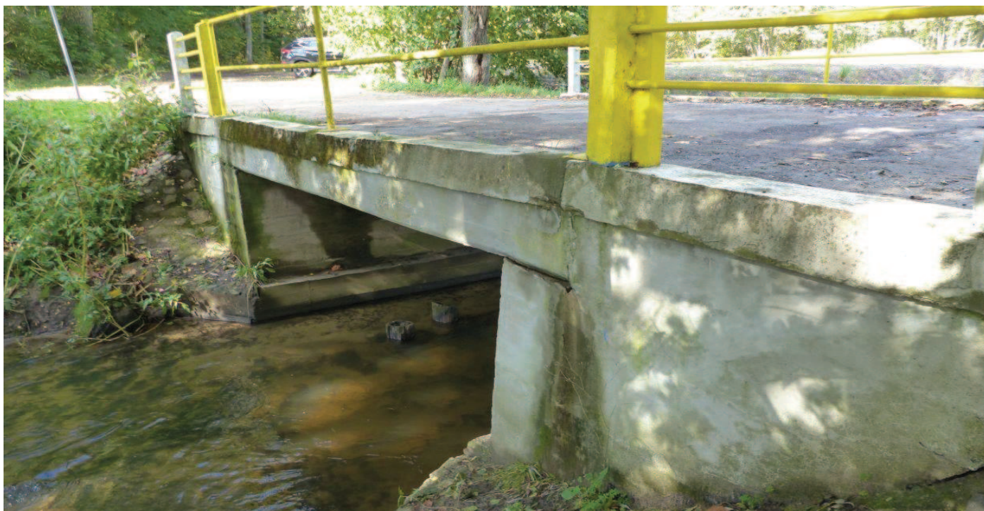
Fot. 5 Widok mostu z boku
