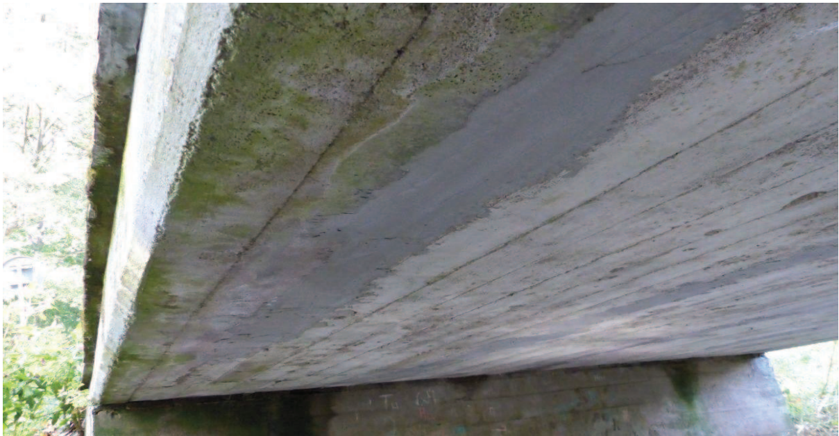
Fot. 23 Konstrukcja pomostu
