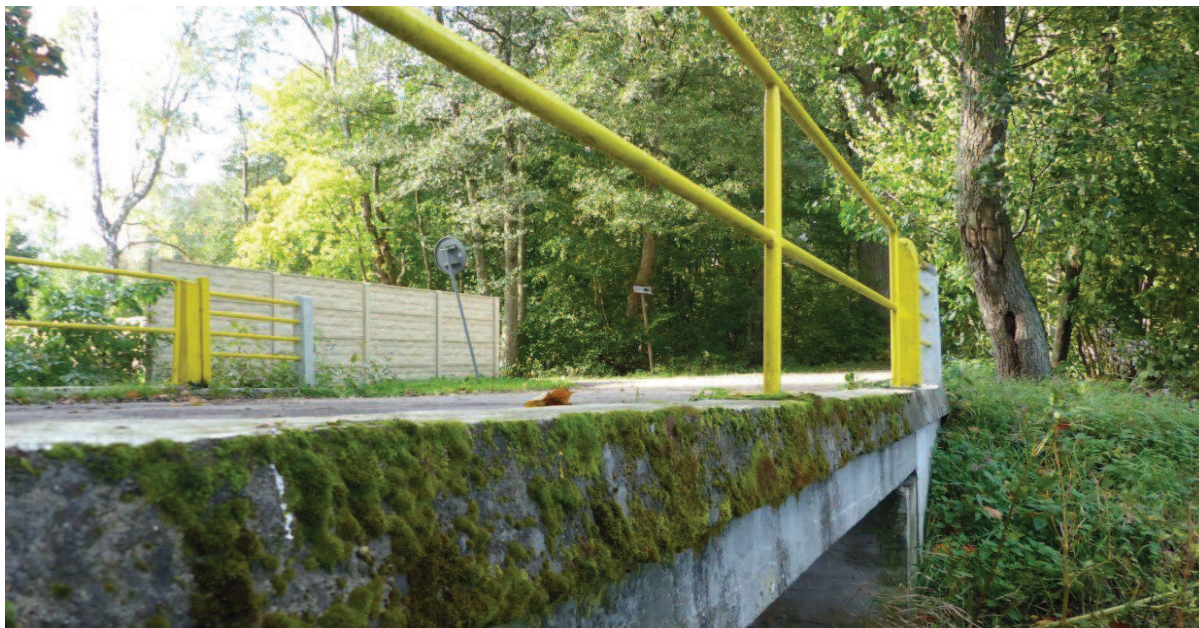
Fot. 19 Belki podporęczowe, gzymsy
