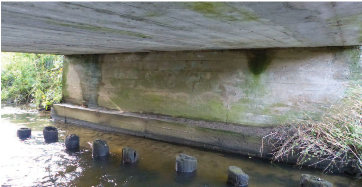
Fot. 22 Izolacja pomostu
