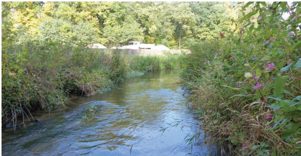
Fot. 32 Koryto rzeki, przestrzeń podmostowa nadmierna wegetacja roślin utrudniająca przepływ wody
