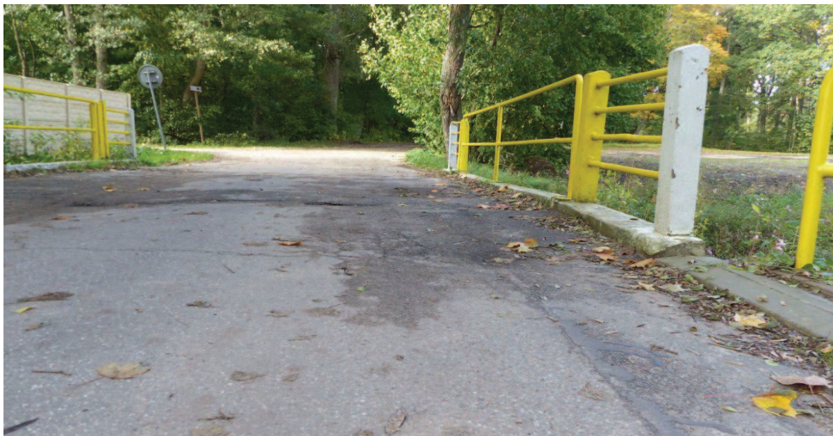
Fot. 27 Urządzenia dylatacyjne
