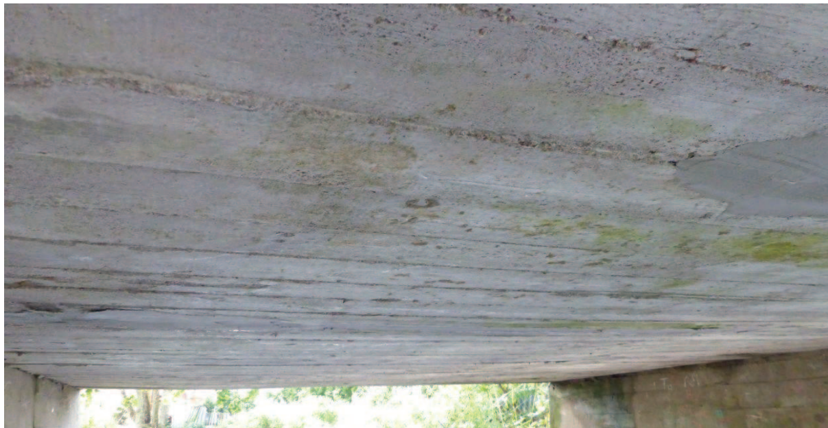
Fot. 24 Konstrukcja dźwigarów głównych
