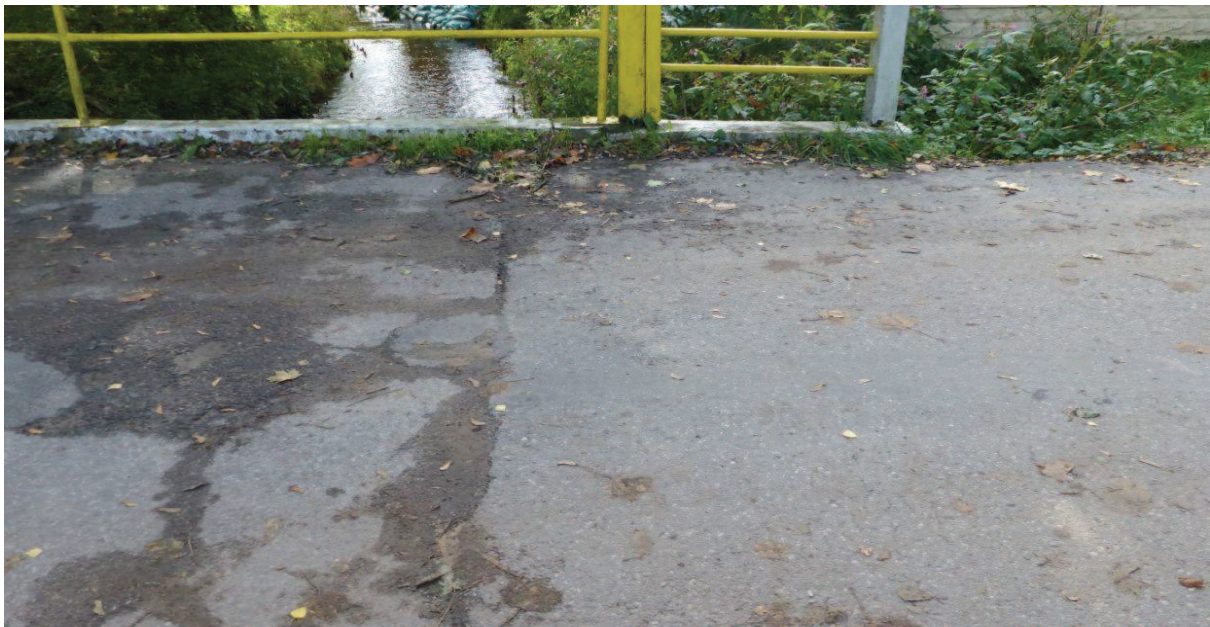
Fot. 26 Urządzenia dylatacyjne
