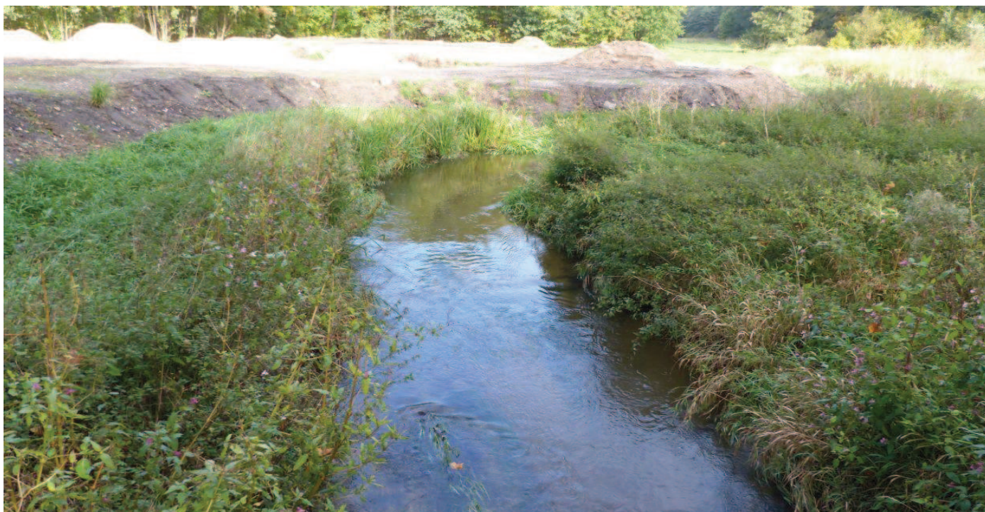
Fot. 7 Widok z mostu na ciek
