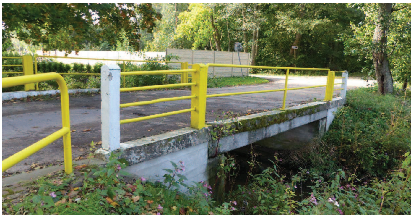
Fot. 4 Widok mostu z boku
