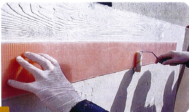
Fot. 5 PROCES WYKONYWANIA ODCISKU Z DOCIŚNIĘCIEM ZA POMOCĄ WAŁKA
