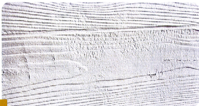
Fot. 4 PRAWIDŁOWO WYKONANA DESKA
