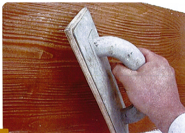
Fot. 7 PRZECIERANIE PREPARATU BOLIX DECO LAZUR PRZY POMOCY PACY Z GUMOWYM PODBICIEM
