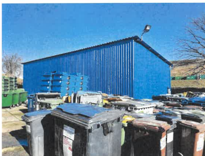
Fot.5 Elewacja zachodnia i południowa – wiata magazynowa.
