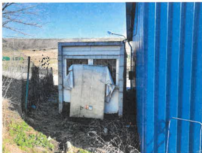
Fot.3 Elewacja zachodnia – prefabrykowany kontener
