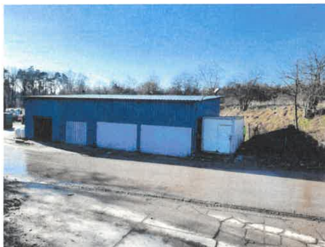
Fot.1 Widok wiaty magazynowej i kontenera – budynek przeznaczony do rozbiórki
