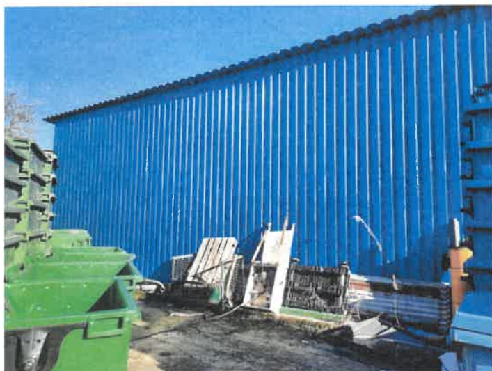
Fot.4 . Elewacja południowa – wiata magazynowa.
