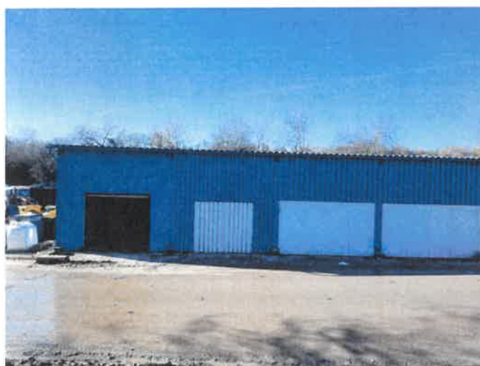
Fot.2 Elewacja wschodnia – wiaty magazynowa.
