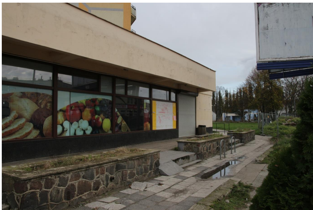
Front pawilonu od ul. Stryjewskiego. Źródło: inwentaryzacja
