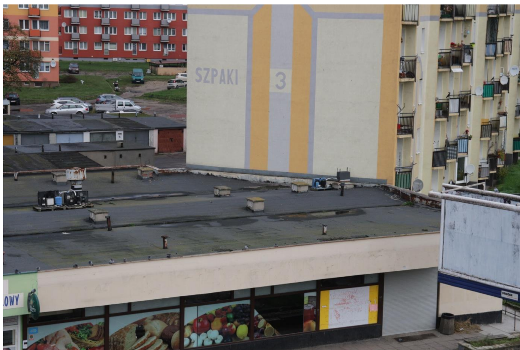
Dach pawilonu od ul. Stryjewskiego. Źródło: inwentaryzacja
