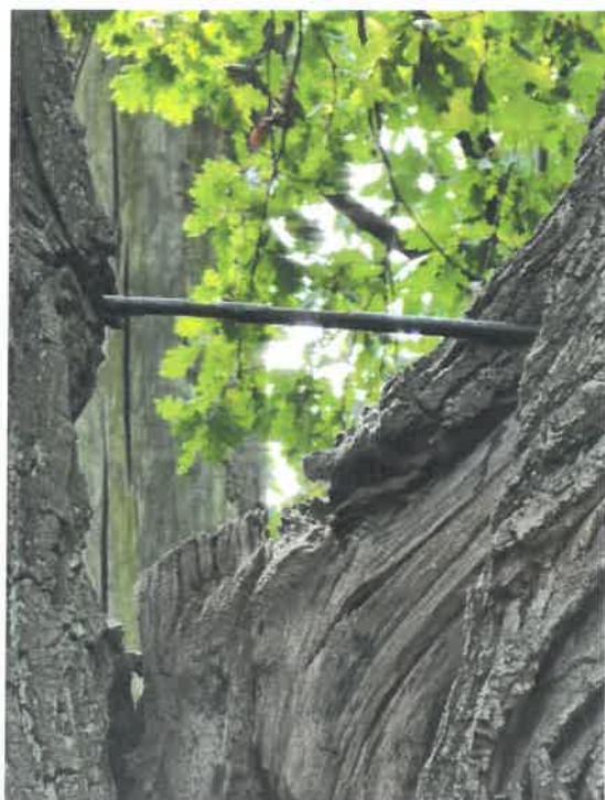
fot. 10 Wzmocnienie przewiertowe w nasadach przewodników
