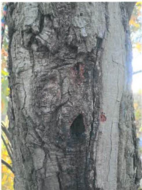
Fot. 13 Dziupla na przewodniku centralnym
