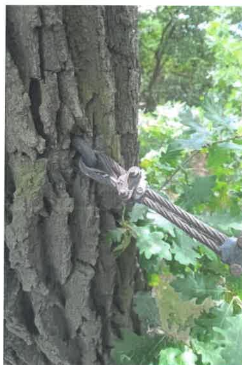
fot. 11 Wzmocnienie przewiertowe łączone liną stalową w górnej części przewodników
