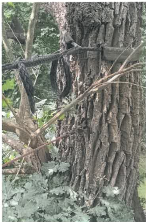
fot. 12 Wiązanie tekstylne dublujące wiązanie przewiertowe
