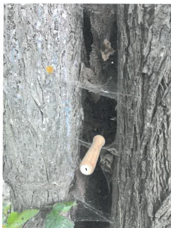
fot. 3 Ubytek w pniu
