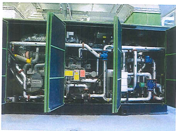
Bioelektrownia – Kogenerator
