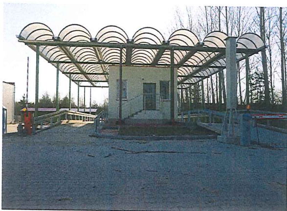
Budynek obsługi wag
