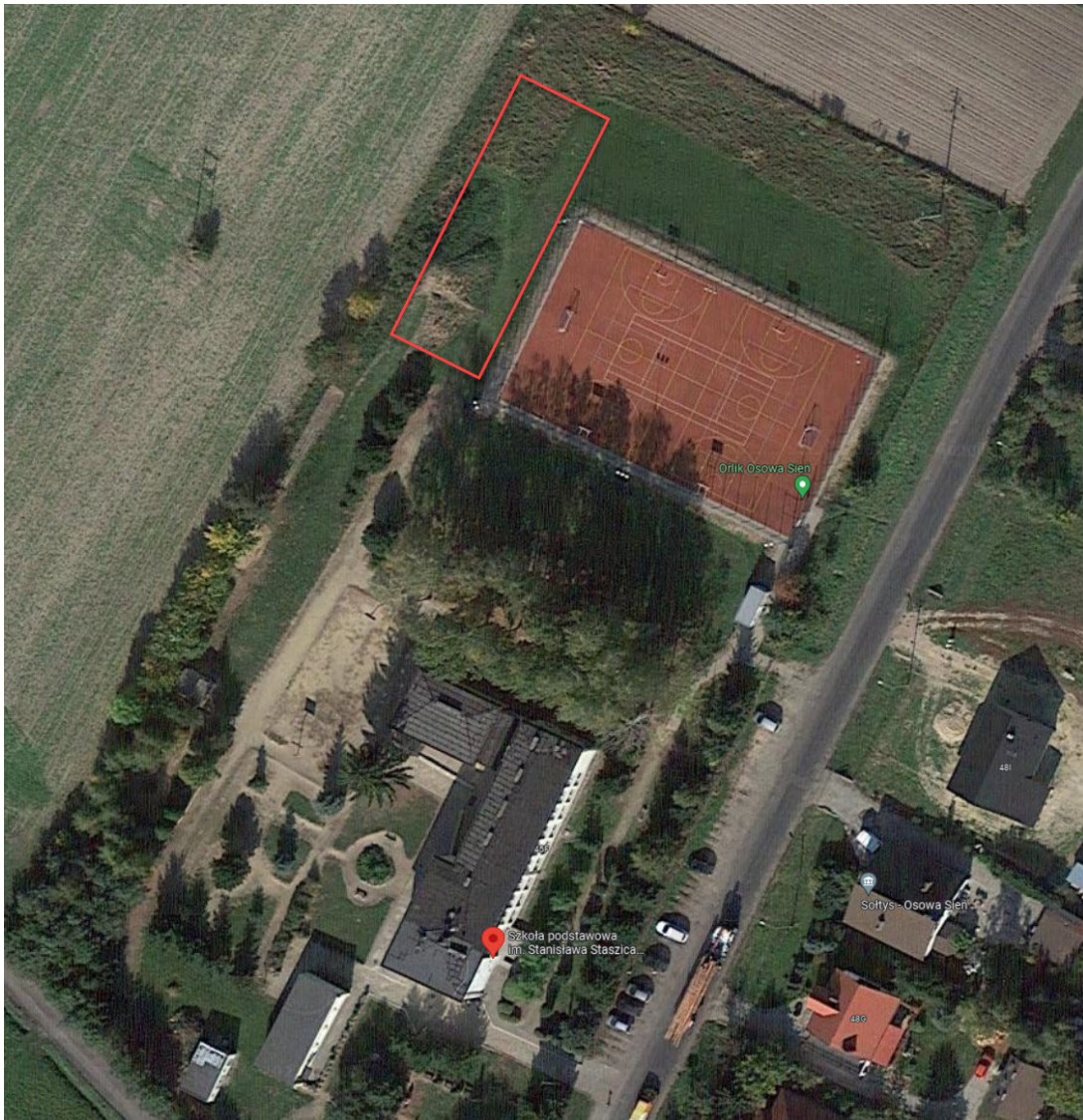
Rys. 3.3. Miejsce przewidziane na lokalizację instalacji ogniw fotowoltaicznych (PV).
