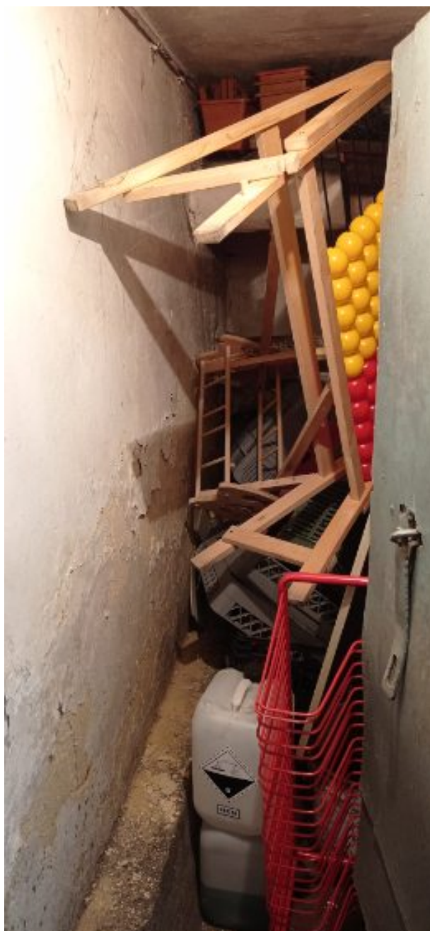
Fot. 3.10. Istniejące źródło ciepła dla budynku szkoły i biblioteki.
