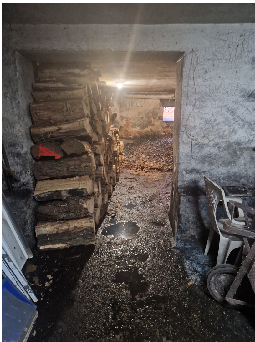
Fot. 3.5. Istniejące źródło ciepła dla budynku szkoły i biblioteki.
