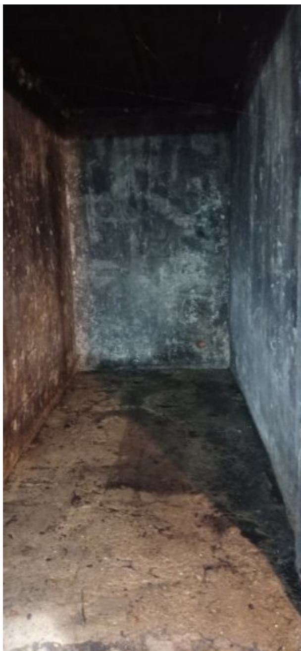
Fot. 3.11. Istniejące źródło ciepła dla budynku szkoły i biblioteki.
