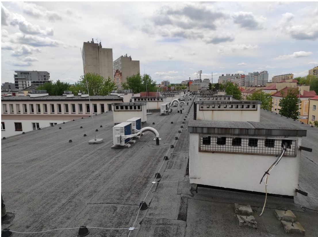
Zdj. 4 ( widok ogólny dachu )
