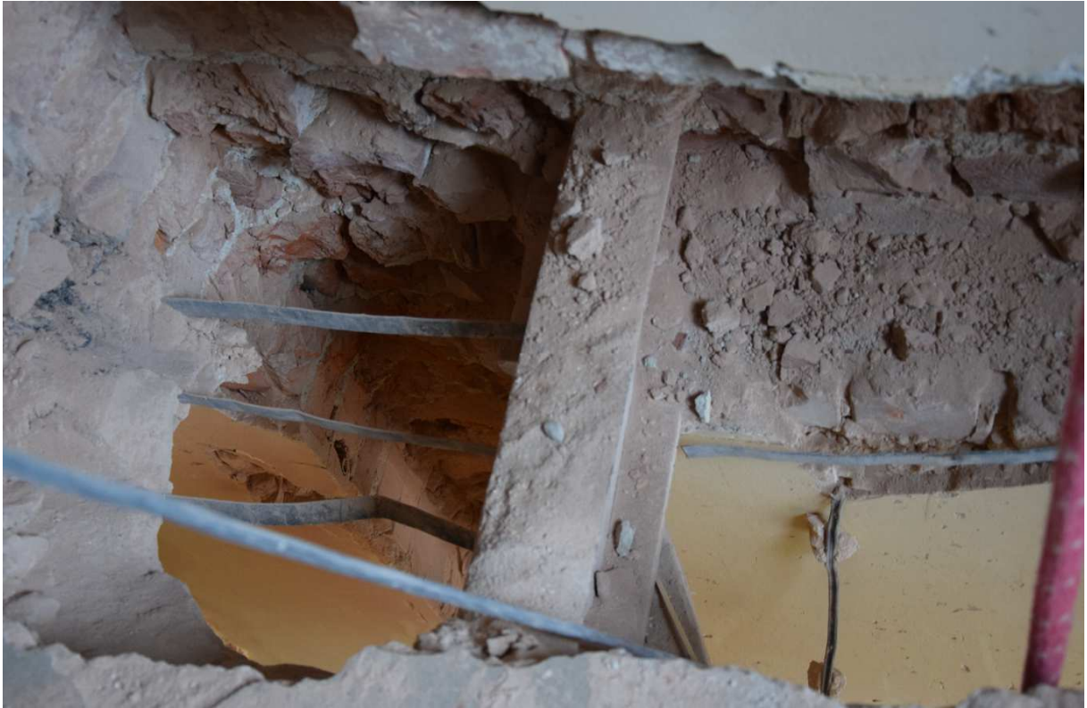
Zdj. 10 ( belka stropu Klein )
