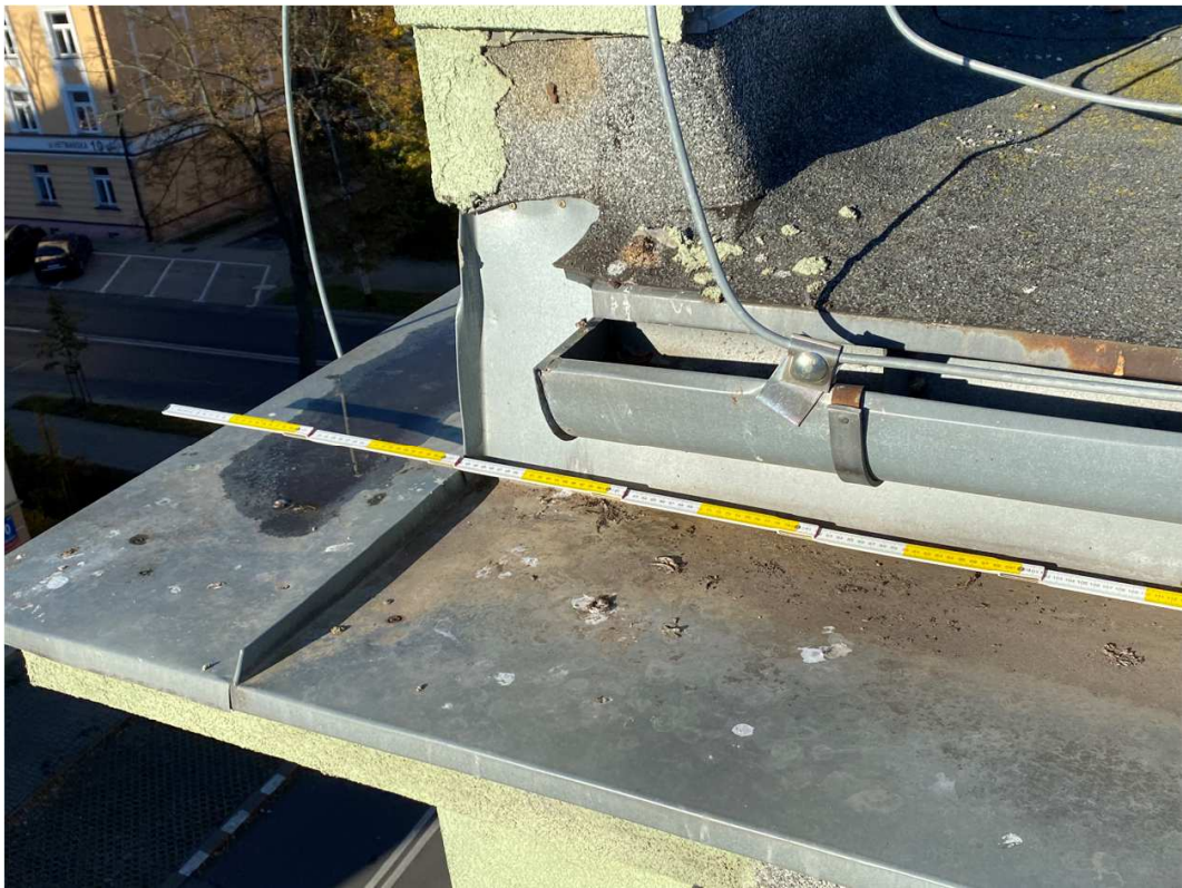
Zdj. 2 ( widok narożnika dachu )
