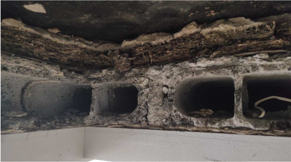
Zdj. 7 ( widok stropu DZ-3 )
