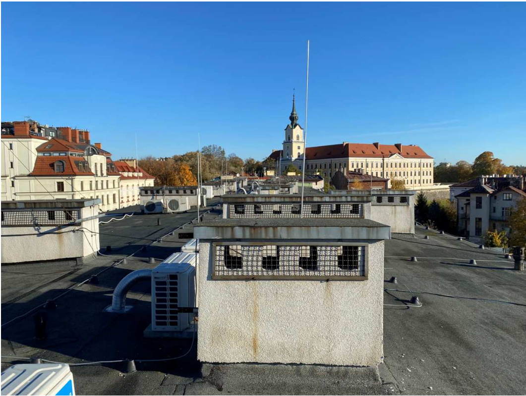
Zdj. 1 ( widok ogólny dachu )
