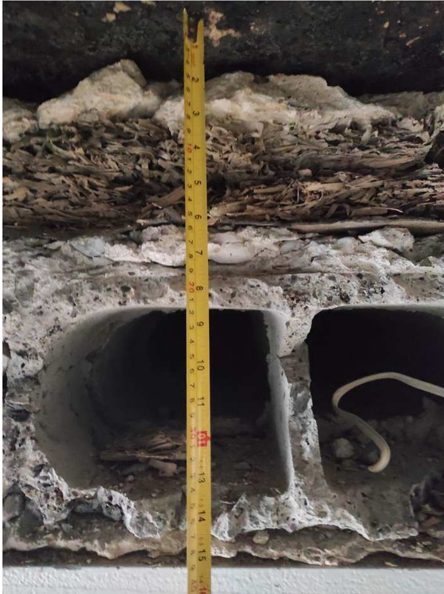
Zdj. 5 ( widok stropu DZ-3 )
