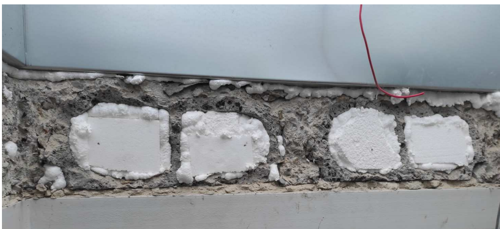
Zdj. 6 ( widok stropu DZ-3 )
