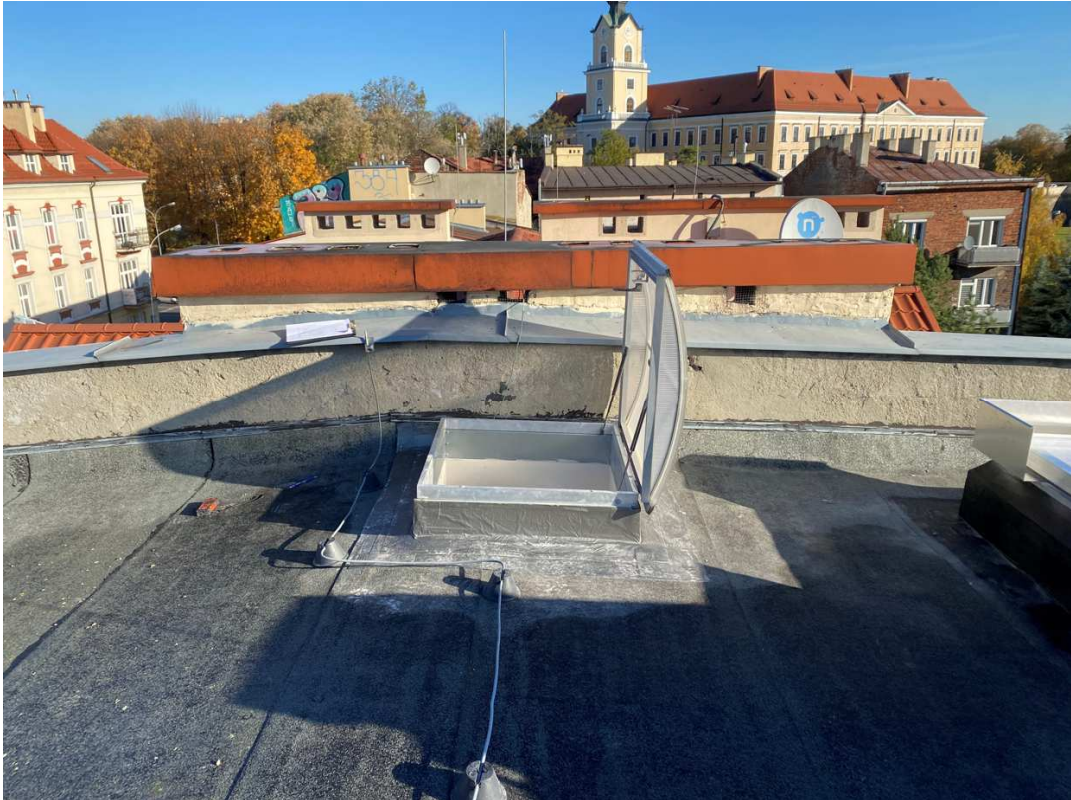
Zdj. 3 ( widok wejścia na dach )
